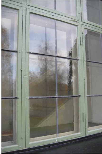
Figur 11. Detalj av fönster med blyspröjs och stormjärn efter ommålning. Foto: Daniel Olsson, Länsmuseet Gävleborg 2012-10-04.
