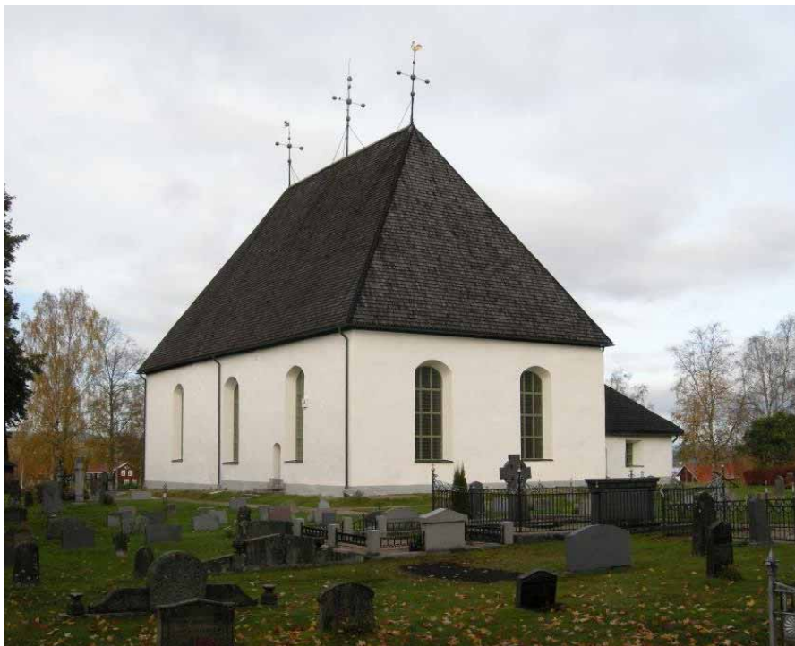
Figur 12. Kyrkan från sydöst efter avslutad fasadrenovering. Foto: Daniel Olsson, Länsmuseet Gävleborg 2012-10-04.
