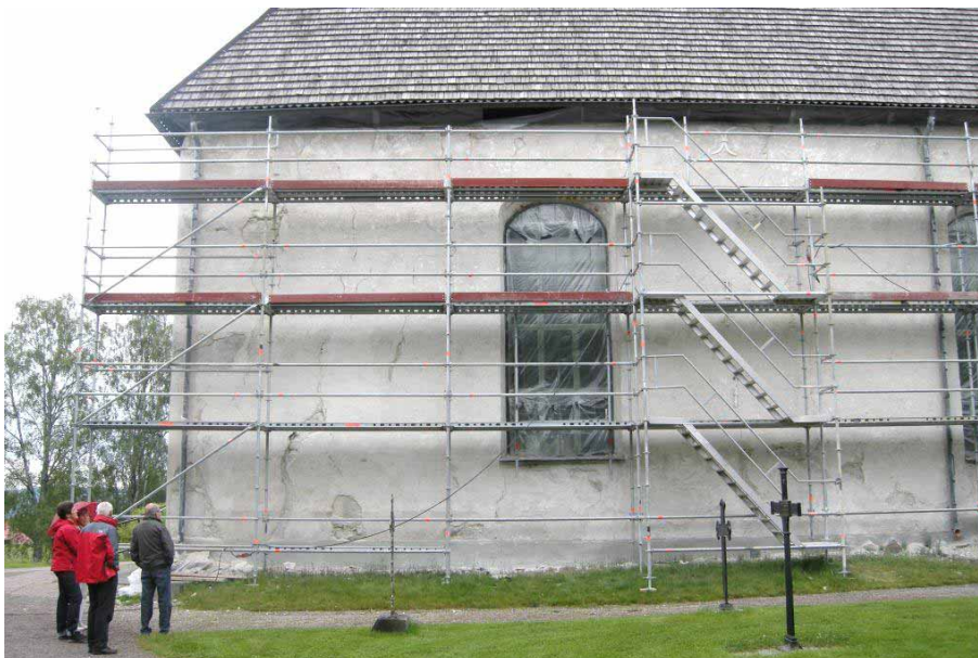
Figur 6. Den västra delen av den södra fasaden i samband med rundvandring på arbetsplatsen efter ett byggmöte. Foto från söder, Daniel Olsson, Länsmuseet Gävleborg 2012-06-26.
