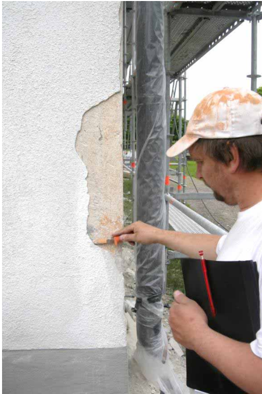
Figur 14. Pontus Johansson visar det underliggande gula färgen vid det sydöstra hörnet av kyrkans västra fasad. Foto: Daniel Olsson, Länsmuseet Gävleborg 2012-06-26.
