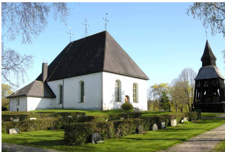
Figur 3. Bjuråkers kyrka innan fasadrenoveringen inleddes. Till höger i bild ses klockstapel från 1740. Foto från nordväst, Daniel Olsson, Länsmuseet Gävleborg 2012-05-22.
