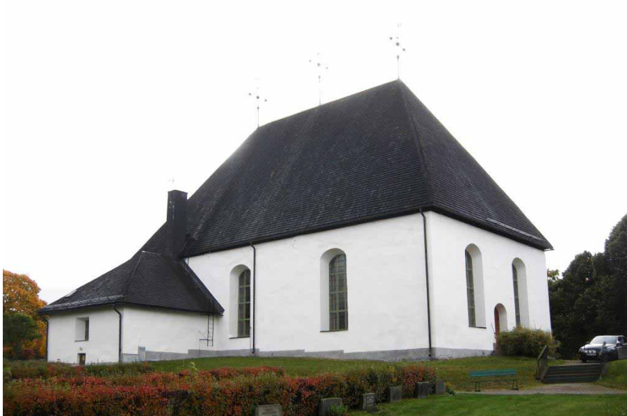
Figur 13. Kyrkan från nordväst efter avslutad fasadrenovering. Foto: Daniel Olsson, Länsmuseet Gävleborg 2012-10-04
