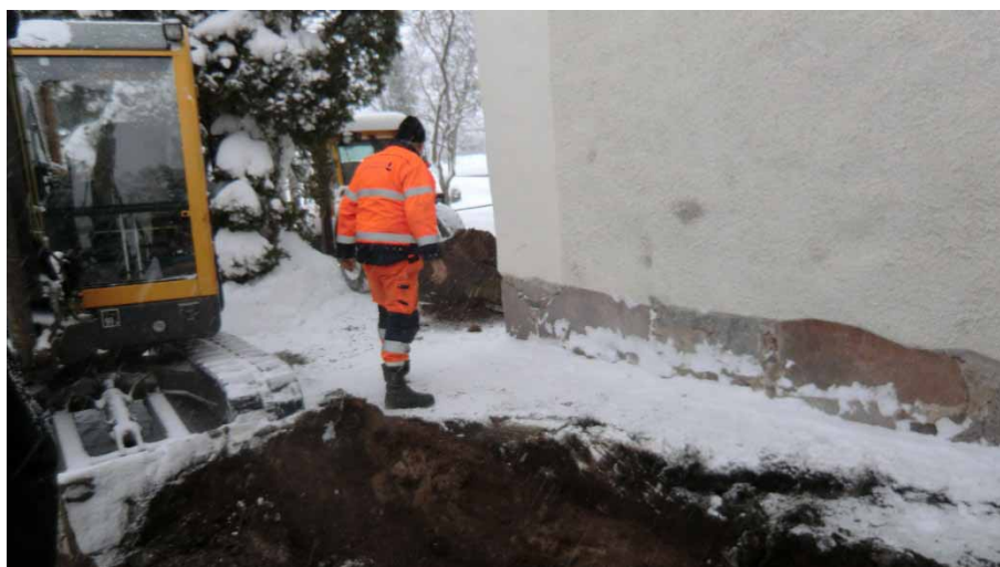
Figur 2. Schaktet för avloppstanken från sydöst. Foto: Katarina Eriksson.
