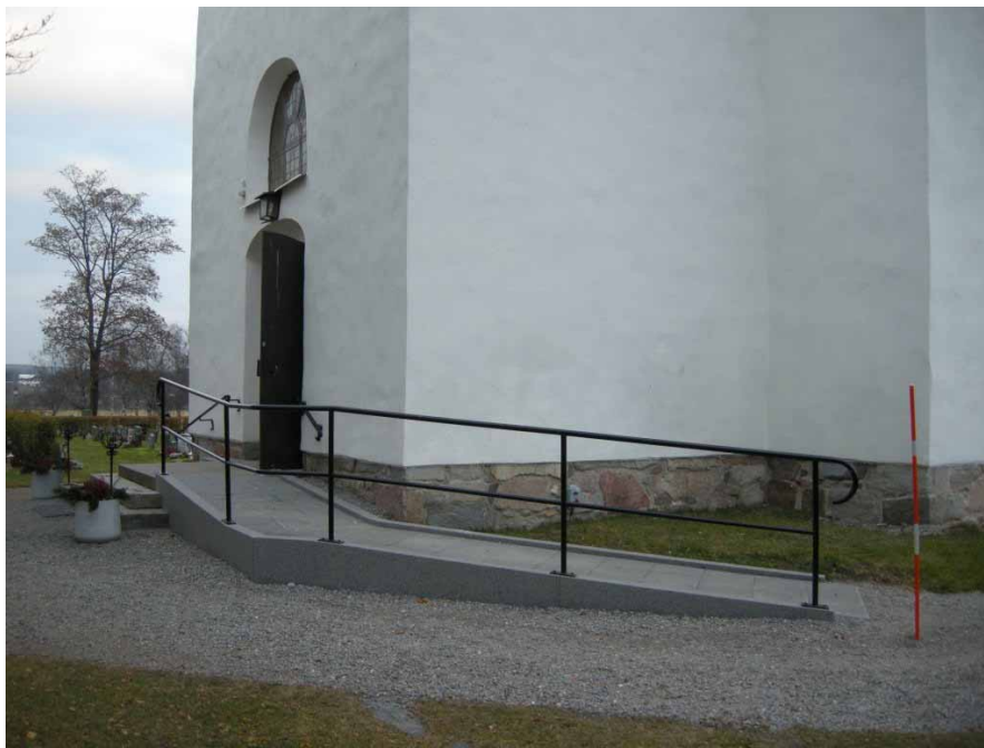
Ill. 7. Rampen från sydväst efter att räcket hade satts upp. Foto: Daniel Olsson, Länsmuseet Gävleborg 2009-11-03.
