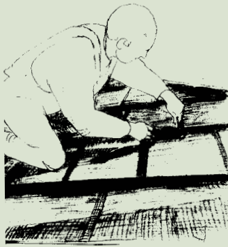
Plåtslagaren undersöker falsarna och avgör om det går att reparera.
