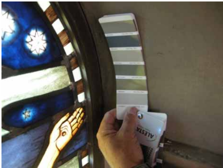
Figur 12. Bestämning av kulör för karm och ram vid ett av altarväggens romanska fönster. Foto från nordväst, Daniel Olsson, Länsmuseet Gävleborg 2013-08-26.
