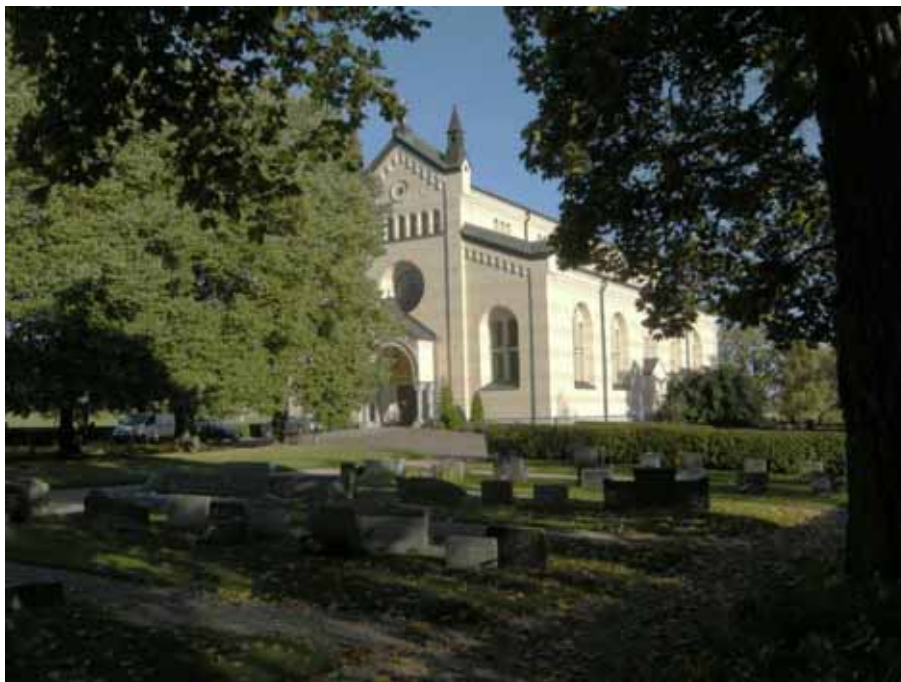
Figur 3. Delsbo kyrka från sydväst. Foto. Daniel Olsson, Länsmuseet Gävleborg 2013-10-03.
