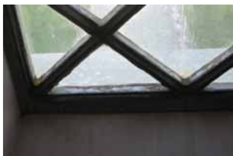
Figur 5. Detalj av gjutjärnsbåge i ett av kyrkorummets fönster. Foto: Daniel Olsson, Länsmuseet Gävleborg 2013-05-17.
