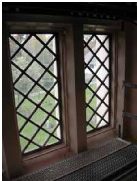
Figur 8. Detalj av fönster mot söder i kyrkorummet efter montering av karm av aluminium. Foto från nordöst, Daniel Olsson, Läns museet Gävleborg 2013-10-01.
