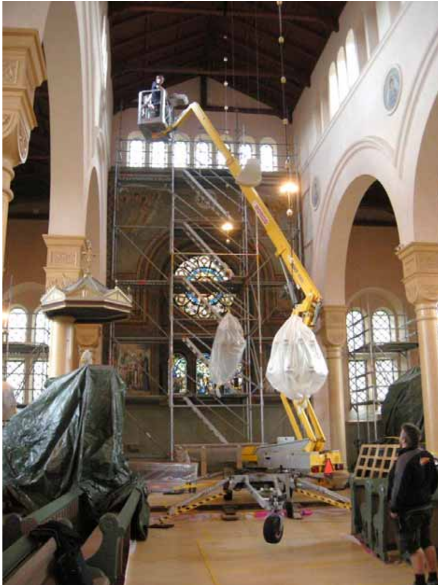
Figur 11. Arbetet med installationerna av isolerrutorna i mittskeppets sidofönster utfördes från skylift. Foto från väster, Daniel Olsson, Länsmuseet Gävleborg 2013-08-13.
