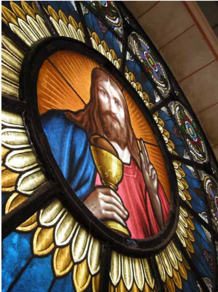
Figur 13. Detalj av rosettfönstrets centralmotiv före restaureringen. Foto från nordväst, Daniel Olsson, Läns museet Gävleborg 2013-08-13.
