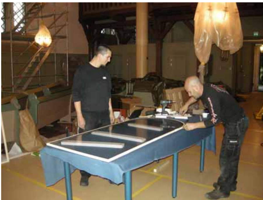
Figur 10. Isolerrutorna monterades i aluminiumramarna på plats i kyrkan. Foto från nordöst, Daniel Olsson, Läns museet Gävleborg 2013-10-09.
