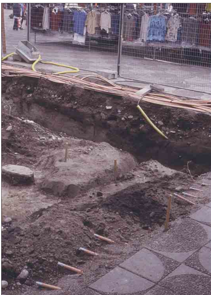
Bild 24. Stortorgetts betongplattor, grundläggning och underliggande värmeslingor ihopsamlade längs schaktkanten. Från SV. Foto Ylva Roslund- Forenius.
