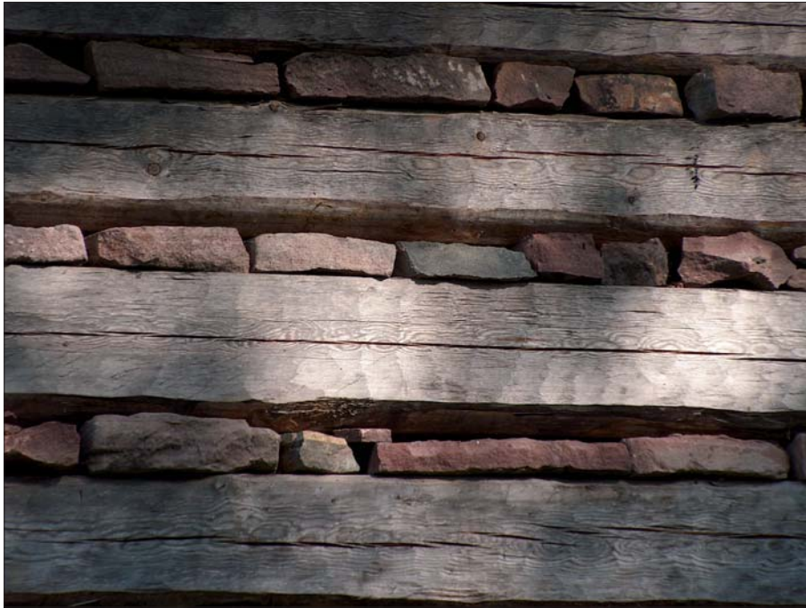
Bild 31. Mulltimmerkonstruktionen i masugnen vid Gysinge bruk. Foto: Katarina Eriksson.
