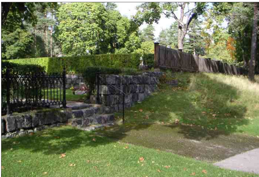
Bild 12. Slaggstensmur, gjutjärnsstaket och trästaket som omgärdar kyrkan.
