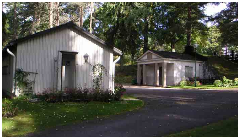
Bild 13. Personalbyggnaden och bårhuset i Högbo.
