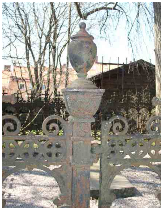
Bild 9. Rostigt gjutjärn i behov av underhåll.
