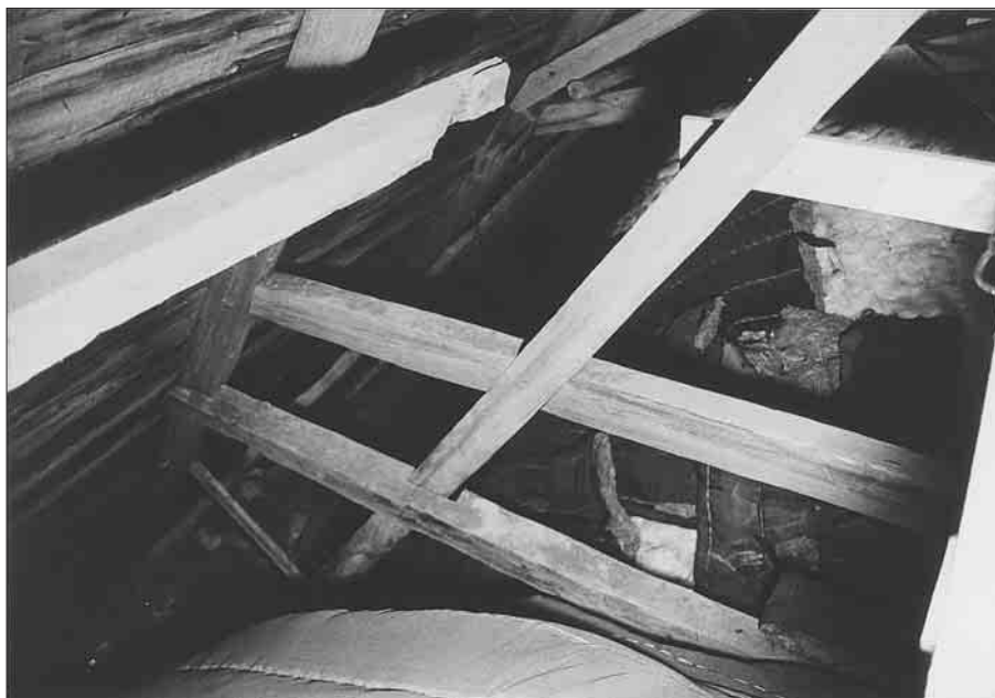
Bild 8. Isolering på valven vid takstol 9 före åtgärd. Foto Läns museet Gävleborg 2000.
