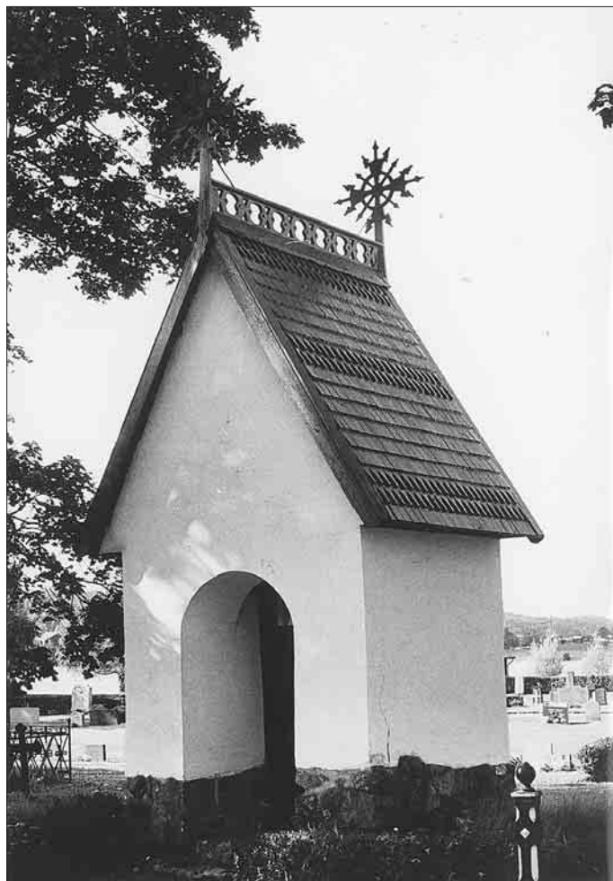
Bild 11. Stigporten efter tjärning av tak. Foto Länsmuseet Gävleborg 2001.
