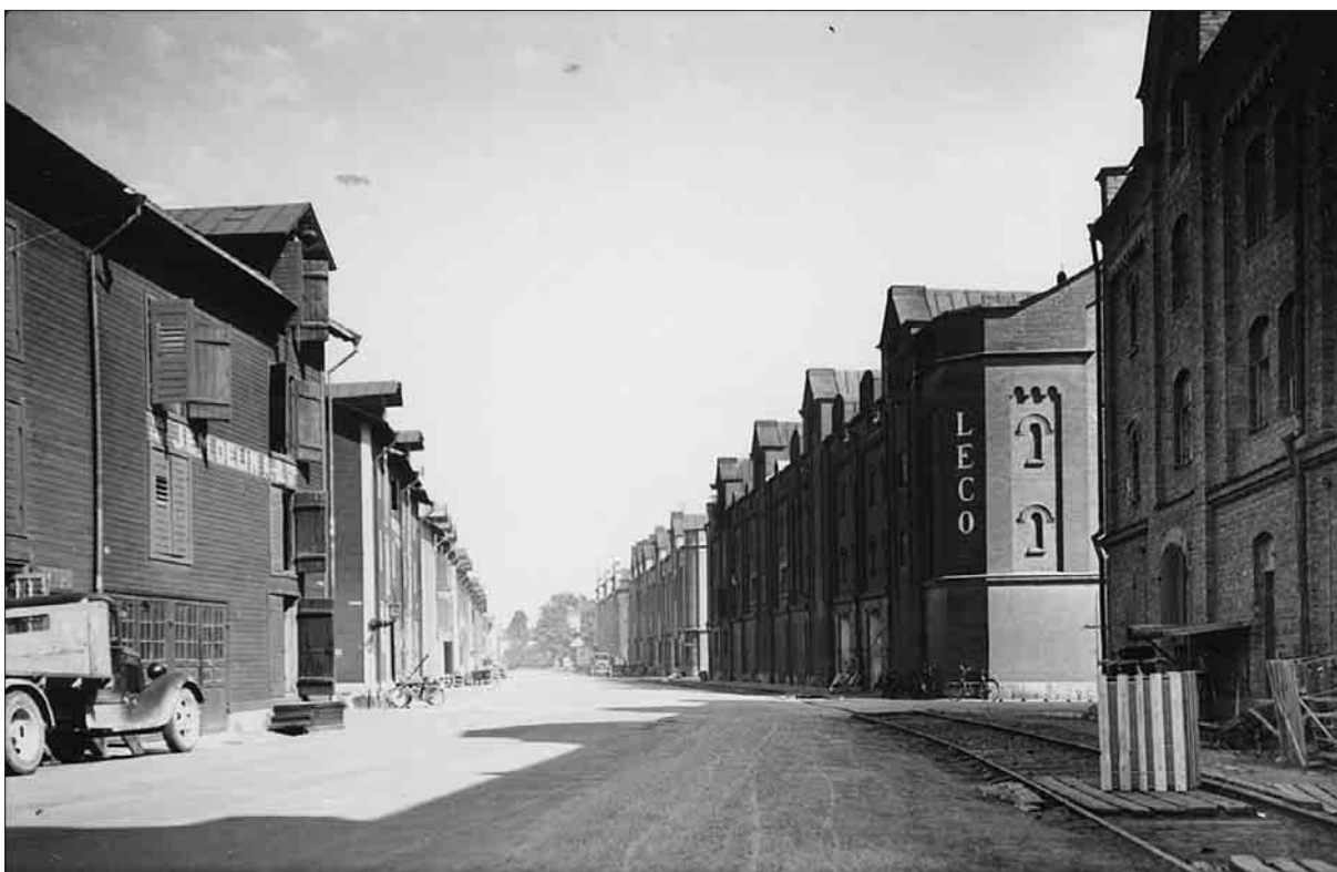
Innanför första magasinsraden löpte järnvägsspåren längsmed byggnadernas norra fasader. Marken var här grusad. Läns museet Gävleborg. Neg nr C88-2994.
