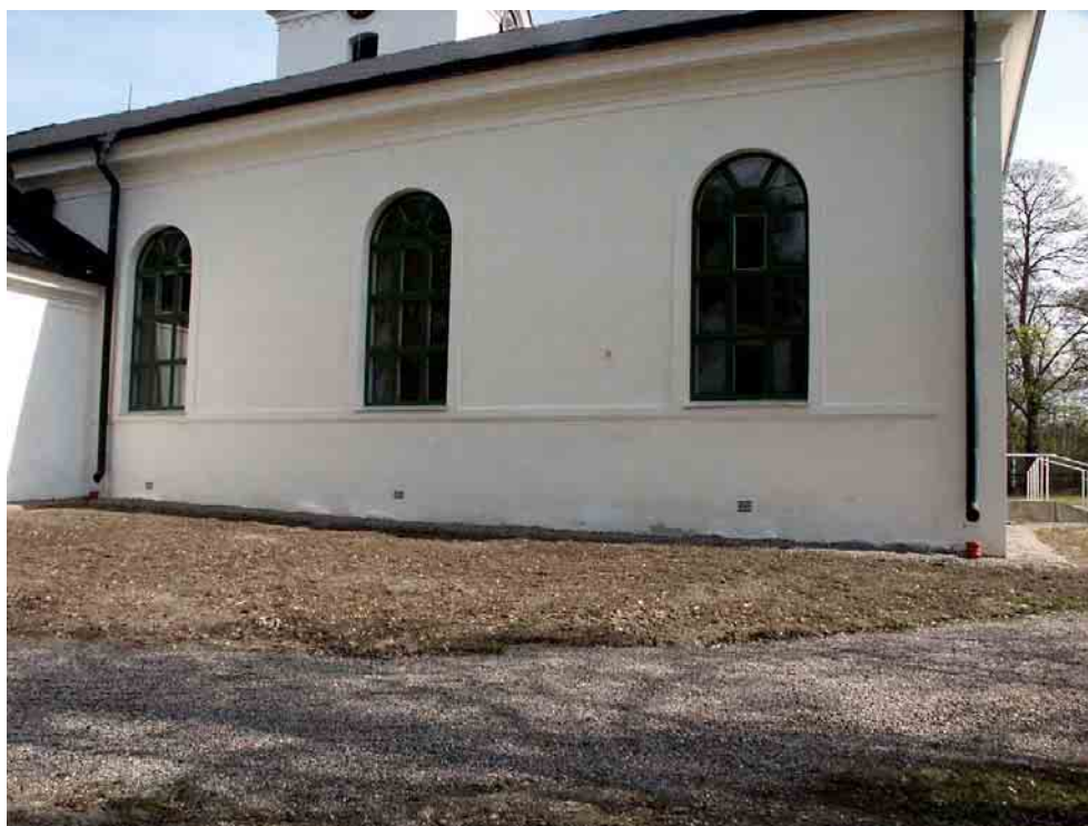
Skogs kyrka. Fasad mot norr-markarbeten.
