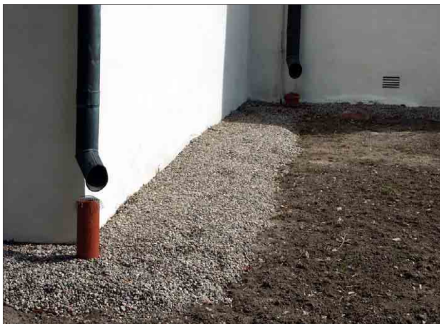
Bild 4. Marken närmast fasaden har åtgärdats. Foto Henrik Lindblad. Dg 03-1606
