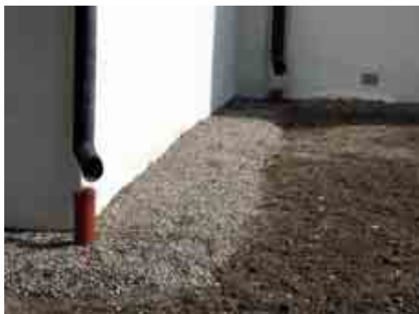
Stuprör vid norra fasaden. Bildnr Dg 03-1606
