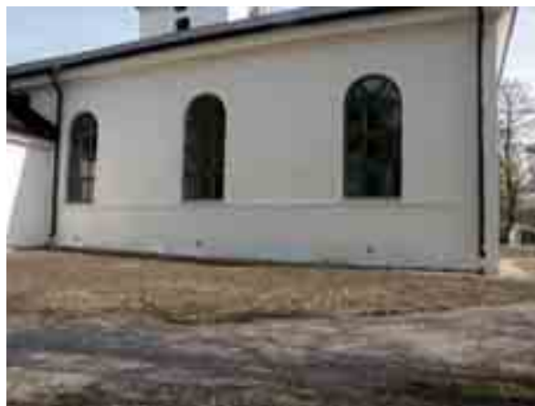
Exteriör från norr, markarbeten. Bildnr Dg 03-1605
