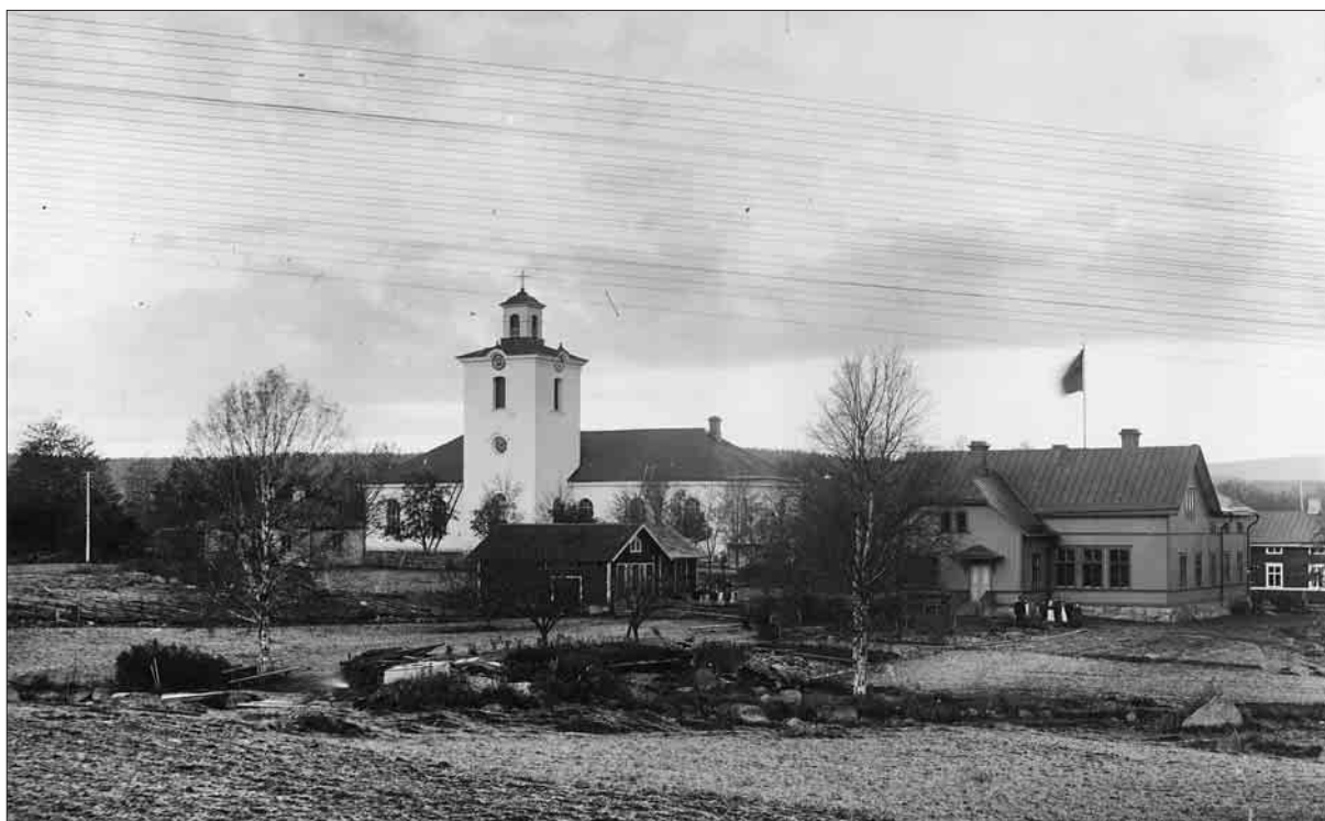
Bild 2. Skogs kyrka, byggd 1805. Närmast i bild är den södra fasaden med tornet. Fotot är från tiden efter 1904 då kyrkan fick skivfalsat plåttak. Byggnaden till höger är skolhuset. Foto Forsbäck. Neg nr K 76-973.
