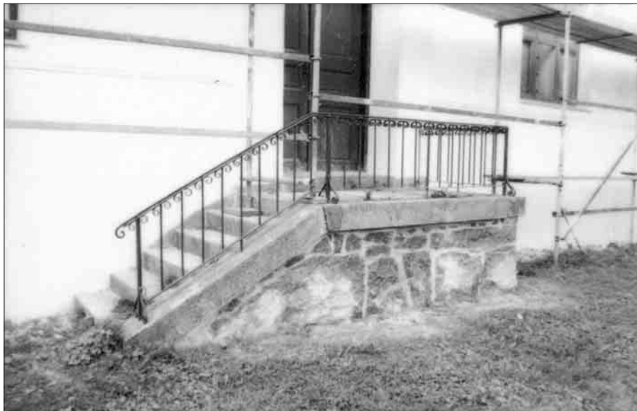
Bild 6. Trapp vid östra ingången efter åtgärd. Foto Henrik Lindblad. S 02-91:18.
