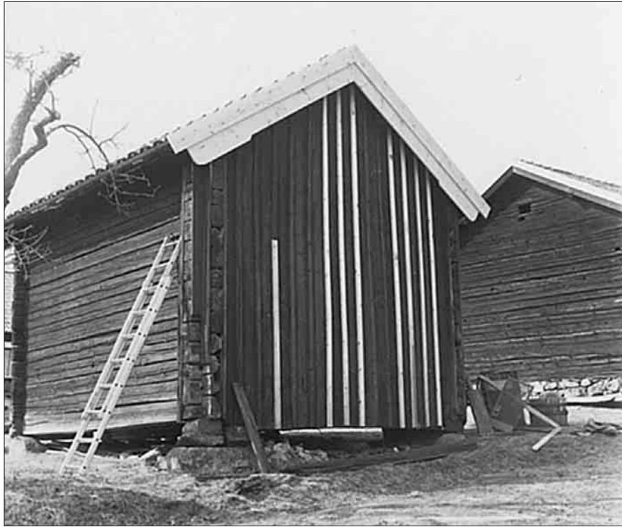
Bild 24. Härbret under renovering. Ny panel och vindskivor. K 00-141.
