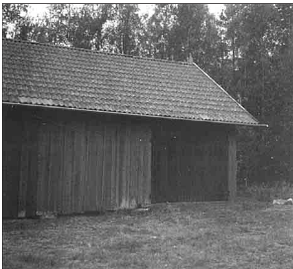
Bild 10. Del av garagebyggnaden. K 00-511.
