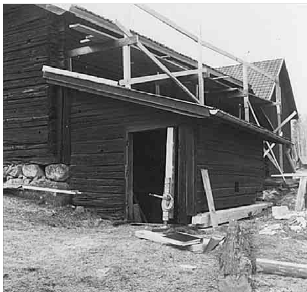
Bild 26. Källaröverbyggnaden under renovering. Omläggning av tak och utbyte av syll. K 00-145.
