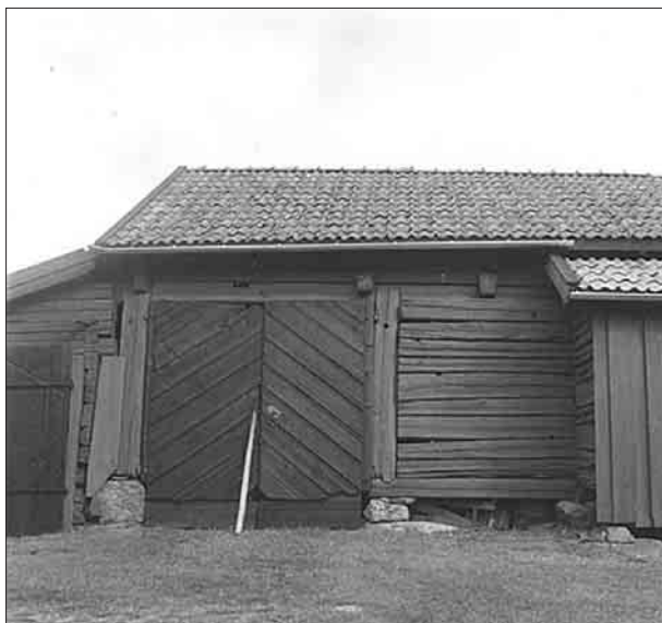
Bild 25. Vagnslider. Omlagt tegeltak och nya hängerännor. Porten har lagats varsamt för att dess ålderdomliga utseende inte skall förstöras. K 00-507.
