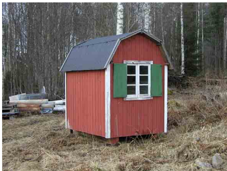
Bild 20. På gården har man också använt sig av en flyttbar byggnad. Denna raststuga på medar av trä drogs av häst och ställdes upp vintertid där arbete pågick, framförallt i skogen. Raststugan är byggd 1925 och har en för sin tid karaktäristisk form, högsjal byggnadskropp med brutet tak. I raststugan finns en gjutjärnskaamin. Dg 05-1353.
