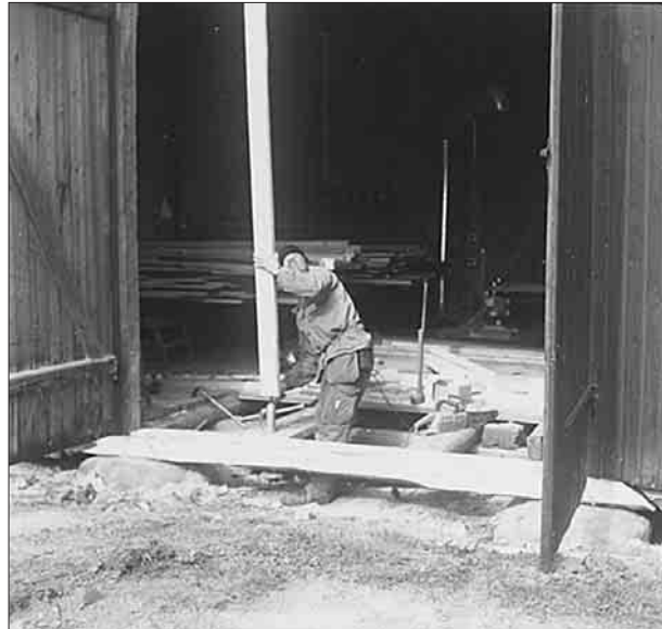
Bild 23. Ny syll har lagts in. K 97-1415.
