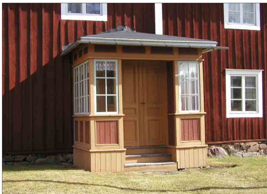
Bild 21. Verandan efter målning och renovering. Dg 05-1348.
