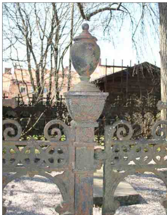
Bild 9. Rostigt gjutjärn i behov av underhåll.
