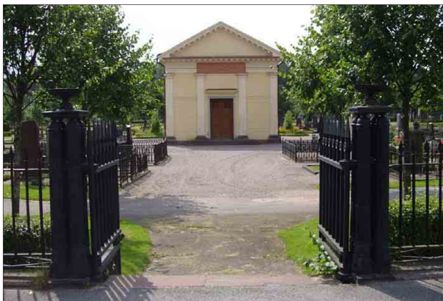
Bild 10. Enneska gravkoret byggt 1820. När denna byggnad uppfördes placerades den i områdets mitt. Begravningsplatsens huvudingång var troligen den grind som skiljde området från landsvägen mot Falun. Foto: Erika Englund. Läns museet Gävleborg.
