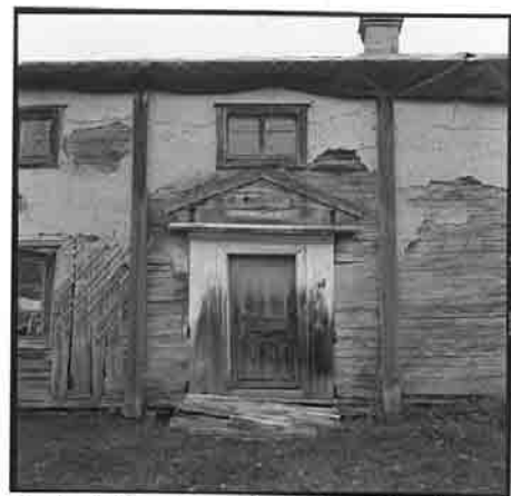
Brokvisten är nedmonterad och renoverad. Neg nr K 99-858
