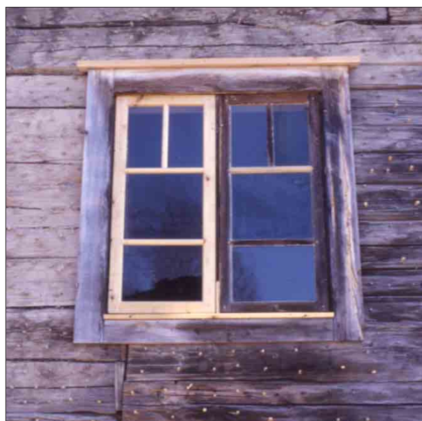
Bild 12. Åtgärdat fönster på byggnadens baksida. Foto Elsa Röing, Länsmuseet Gävleborg 2000. Diabild.
