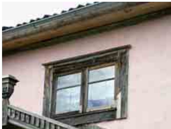
Fönster ovanför brokvist. Bildnr Dg 04-3366
