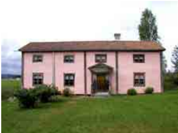
Gammelbyggnad med omfärgad fasad. Bildnr Dg 04-3361
