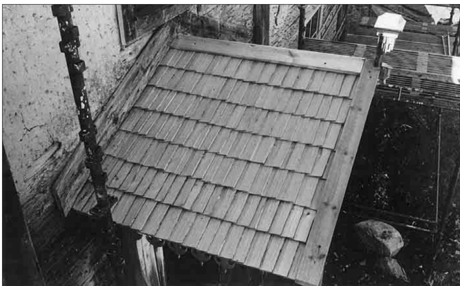
Bild 10. Brokvistens nya spåntak. Foto Elsa Röing, Läns museet Gävleborg 2000. S 00-62:32.
