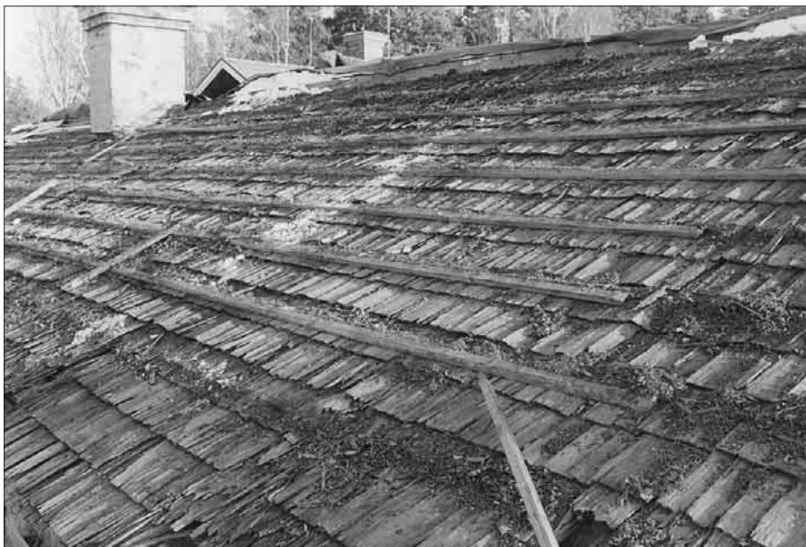
Bild 13. Det äldre spåntaket finns bevarat under tegeltaket. Foto Elsa Röing, Läns museet Gävleborg 2000. S 00-21:15.
