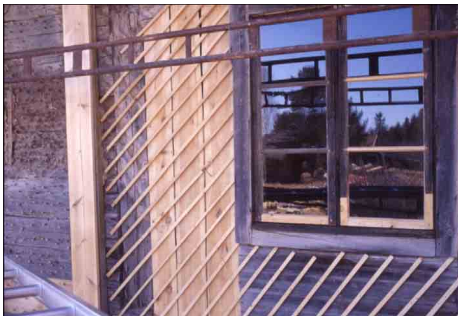
Bild 9. Snedställd spräckpanel användes som underlag för lerbruket runt den gamla portlideröppningen. Foto Elsa Röing, Länsmuseet Gävleborg 2000. Diabild.
