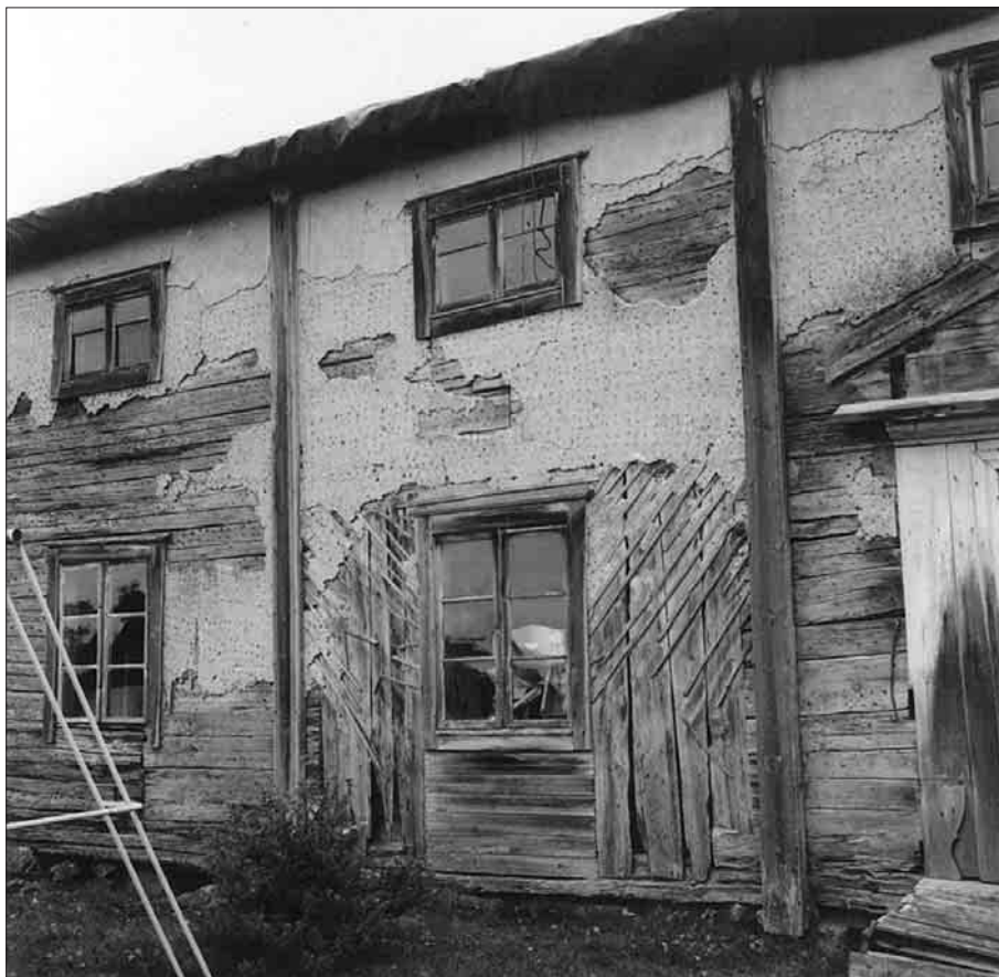
Bild 4. Spår efter det gamla portlidret. Foto Mimmi Göllas, Länsmuseet Gävleborg 1999. K 99-857.
