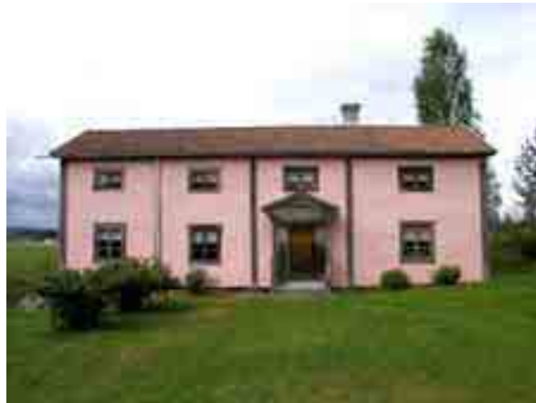
Gammelbyggnad med omfärgad fasad. Bildnr Dg 04-3362
