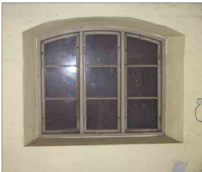
Bild 30. Befintliga fönster i bottenvåningen har ett och samma utseende men antalet lugter varierar. Troligen är trelufterna yngre än tvålufterna. Alla fönster är spröjsade och de flesta är segmentbågiga; ett utseende som är viktigt att behålla. Fönstret på bilden är från magasinets mellandel, Alderholmen 22:4, där källarvåningen finns. Vid ett borttagande av källaren och ett återställande av golvbjälklagsnivån kan fönsteröppningen göras större då bröstningen sänks. Foto L. Boox. Länsmuseum Gävleborg. Dg 04-5130.
