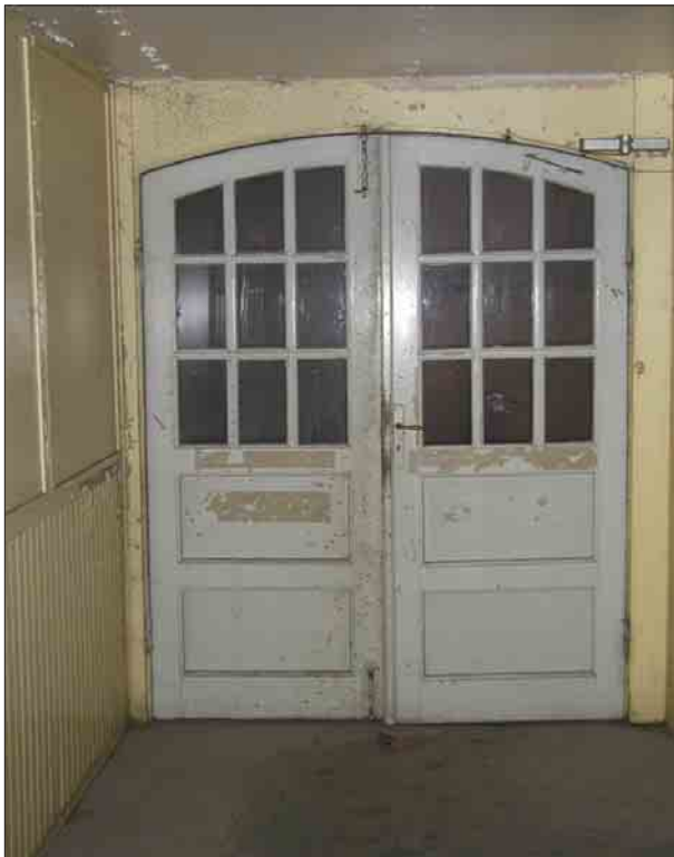
Bild 33. En vanlig, troligen ursprunglig, ytterdörrstyp i byggnaden. Bilden visar bottenvåningen i den mellersta delen, Alderholmen 22:4, där bjälklaget har höjts p.g.a. källarens tillkomst. Dörrbladet har därmed kortats genom att en fönsterrad tagits bort. I skeppshandeln finns en dörr i originalutförande bevarad. Foto L. Boox. Läns museet Gävleborg. Dg 05-0398
