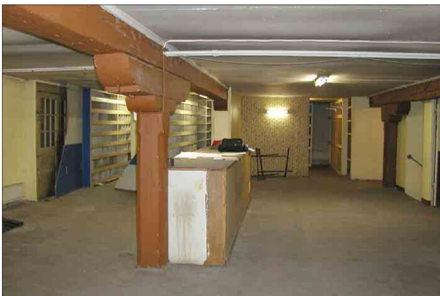
Bild 16. F.d. rörlager på plan 1. Takbjälklaget är inbyggt och sekundära väggar har tillkommit på 1960-talet. Foto L. Boox Länsmuseet Gävleborg. Dg 04-5121.
