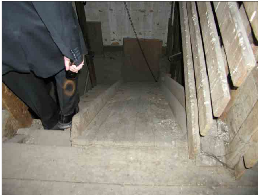
Bild 28. Mellan plan 1 och 4 finns en transportrännan inbyggd i den sydvästra trappan. Foto L. Boox. Länsmuseum Gävleborg. Dg 05-0427.
