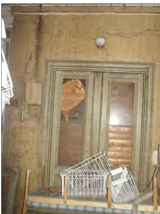
Bild 24. Igensatt dörr från det sydvästra trapphuset in mot kontor 2. Foto G. Jonsson. Läns museet Gävleborg. Dg 05-1401.
