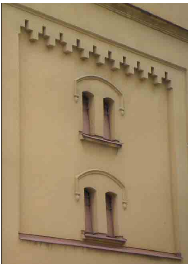
Bild 41. Upphöjda dekorationer i putsfasden omgärdar de små öppningarna. Foto K. Wirdby. Läns museet Gävleborg. Dg 2534.
