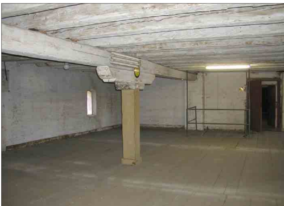
Bild 37. Mellanbjälklagskonstruktionen är mycket karaktäristisk för byggnaden då den speglar dess forna användning. I bakgrunden syns hisschaktet. Alderholmen 22:4. Foto L. Boox. Länsmuseet Gävleborg. Dg 04-5140.
