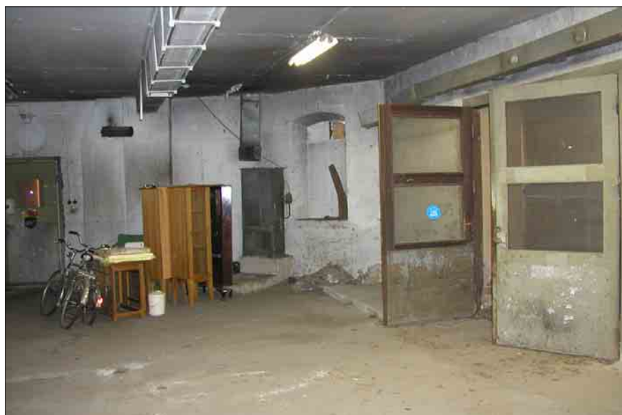
Bild 11. Den f.d. däckverkstaden. Det ursprungliga golvbjälklaget är borttaget. Takbjälklaget är inbyggt och träpelarna är borttagna. Foto L. Boox Länsmuseet Gävleborg. Dg 04-5112.
