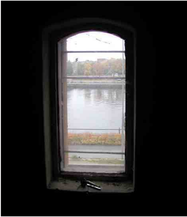
Bild 31. Fönster som satts i en av de små fasadöppningarna på plan 2 och 3. Foto L. Boox. Läns museet Gävleborg. Dg 04-5137.
