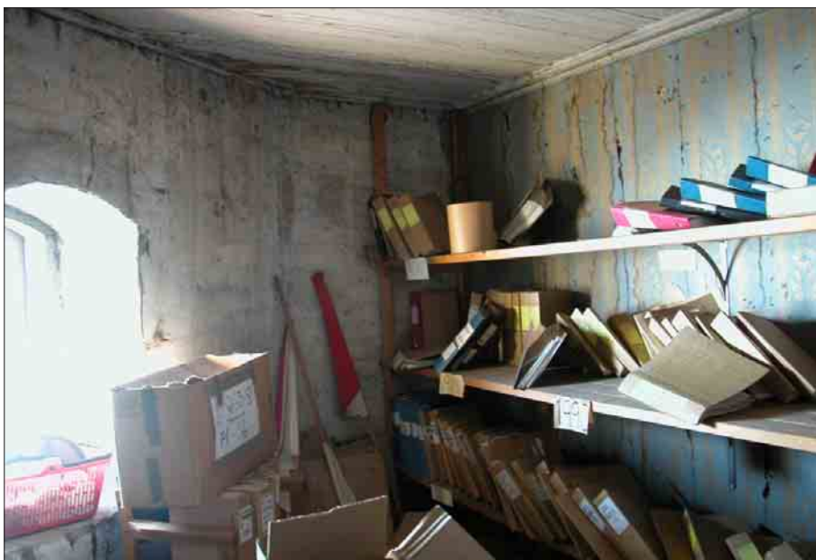
Bild 26. Hörnrum mot sydost. Foto K. Lenngren. Dg 05-0426.
