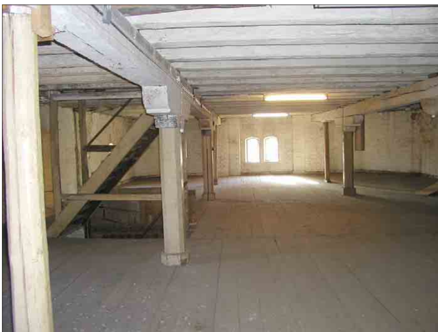
Bild 13. Plan 3 har bevarat sin magasinskaraktär med en öppen volym, brädgolv och den karaktäristiska takbjälkskonstruktionen som bärs upp av de kraftiga pelarna av trä. Foto L. Boox Läns museet Gävleborg. Dg 04-5154.
