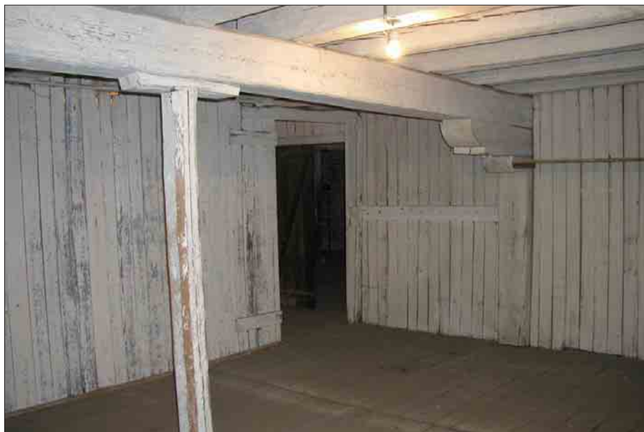
Bild 18. Enkla brädväggar delar av detta plan. Foto L. Boox. Läns museet Gävleborg. Dg 04-5152.
