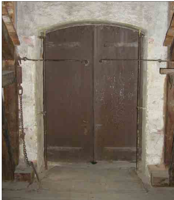
Bild 35. Lastintag täckta med järnluckor. Foto L. Boox. Länsmuseet Gävleborg. 05-0414.
