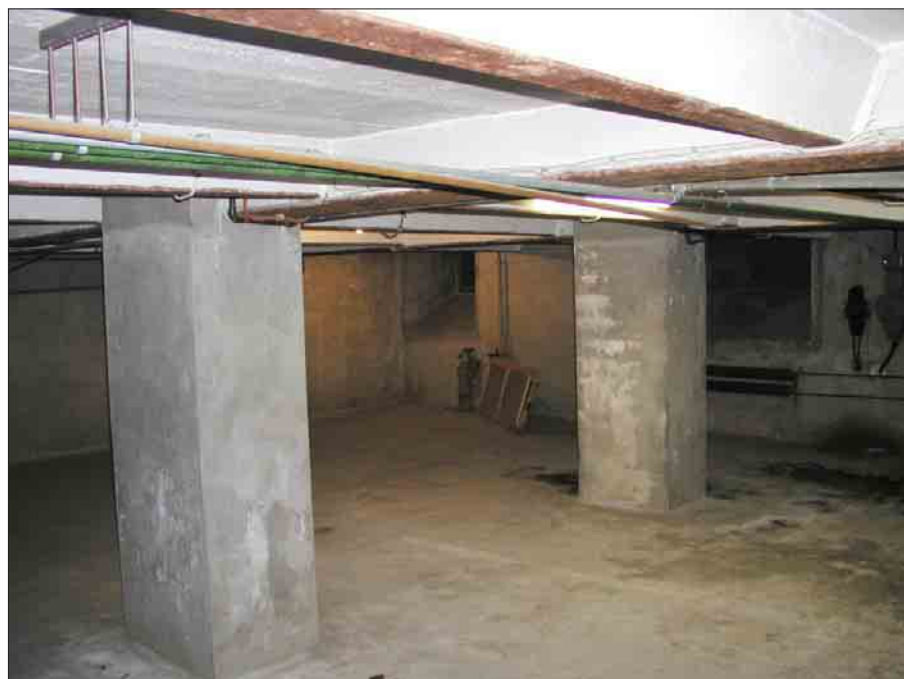
Bild 15. Den gjutna betongkällaren. Foto L. Boox Läns museet Gävleborg. Dg 04-5135.
