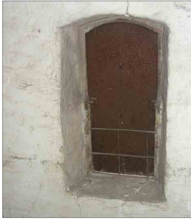
Bild 32. En av järnluckorna som täcker de små fasadöppningarna på plan 2 och 3. Foto L. Boox. Läns museet Gävleborg. Dg 05-0420.
