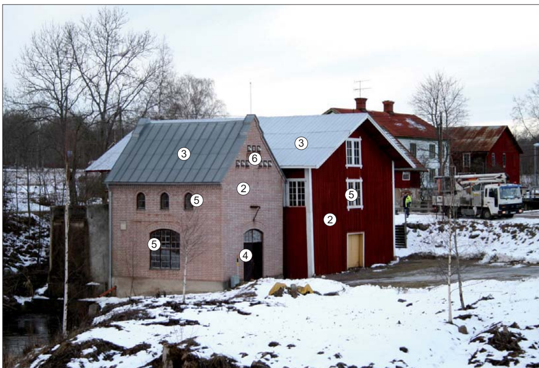
Bergs kvarn, kraftstationen. Karaktärsskapande arkitekturelement markerade.
