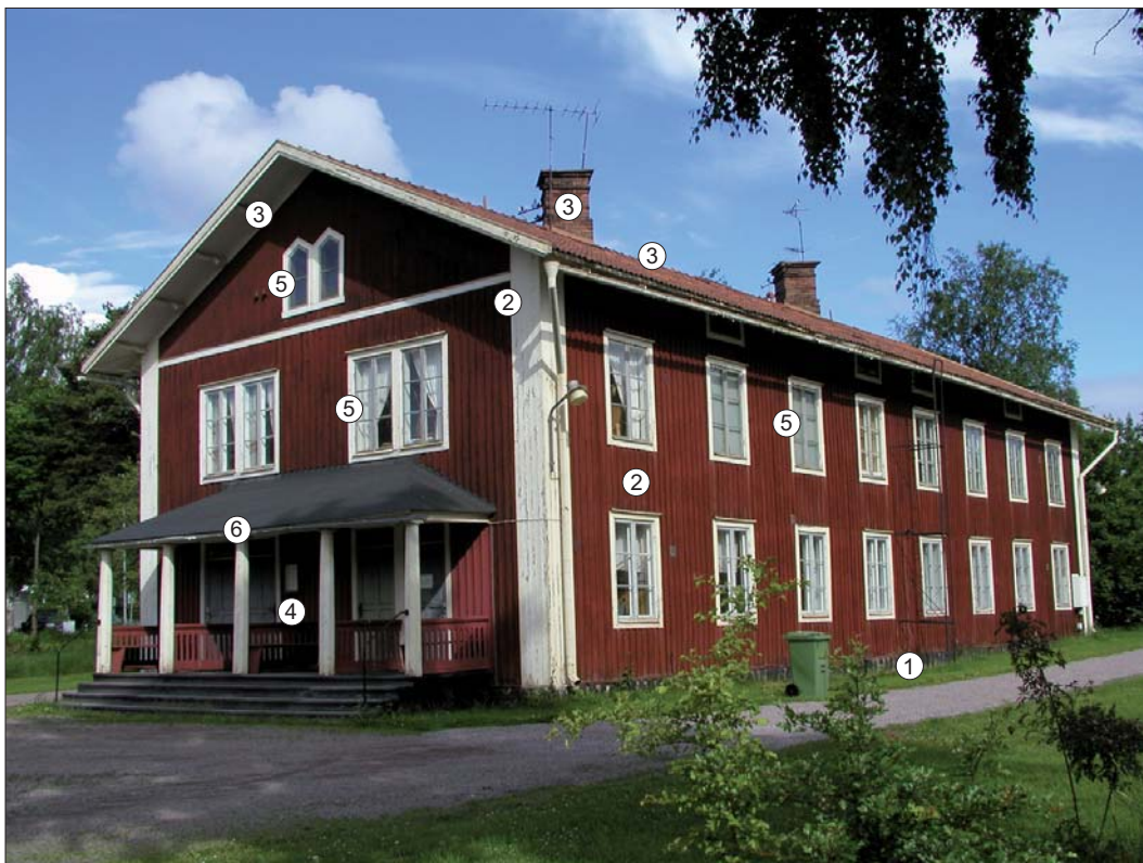
Storgatan 15, arbetarbostaden. Karaktärsskapande arkitekturelement markerade.
