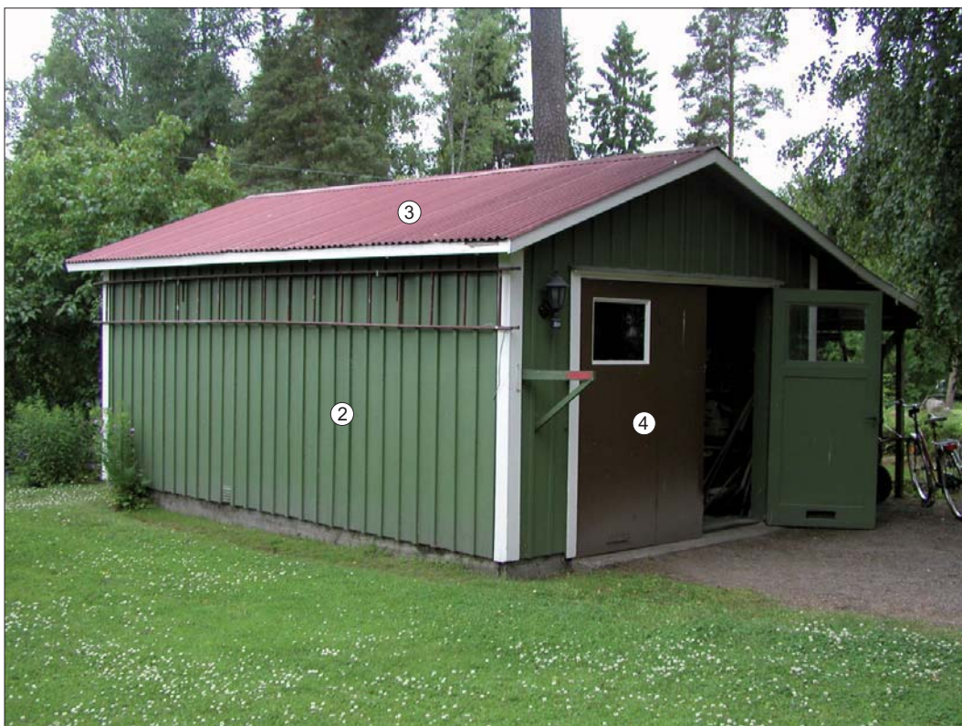
Brännkärrsgatan 17, garaget. Karaktärsskapande arkitekturelement markerade.
