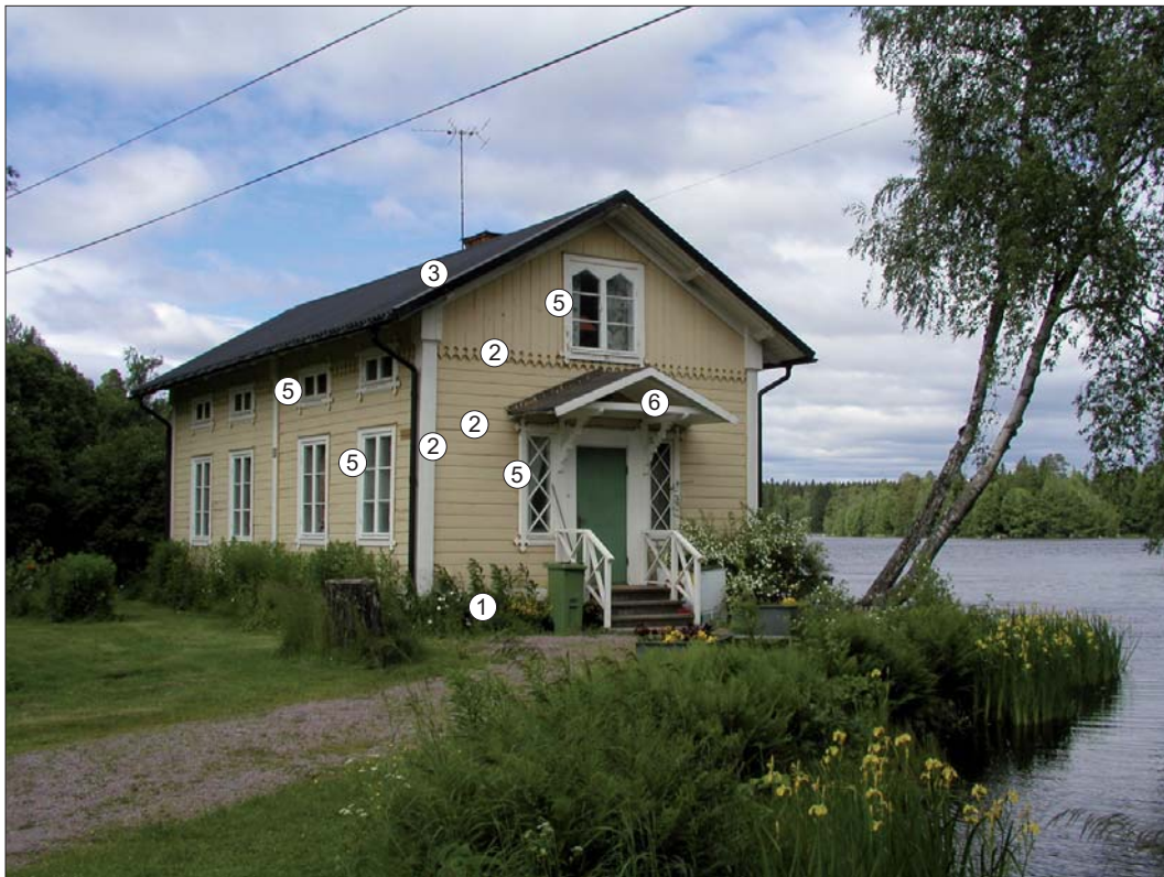
Kerstin Hesselgrensväg 2. Karaktärsskapande arkitekturelement markerade.
