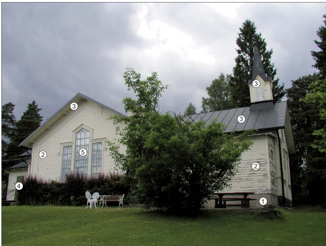
Kapellgatan 4, kapellet. Karaktärsskapande arkitekturelement markerade.
