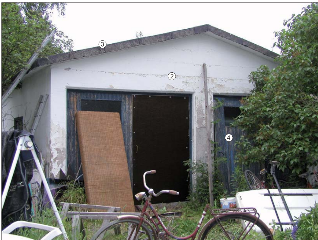
Eriksgatan 18, garaget. Karaktärsskapande arkitekturelement markerade.
