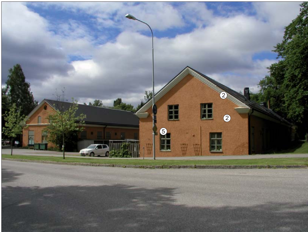
Bruksvägen 3. Karaktärsskapande arkitekturelement markerade.
