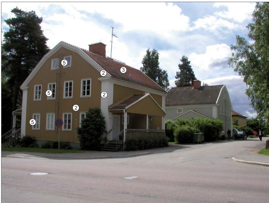
Skolgatan 3 och Östra Parkgatan 19. Karaktärsskapande arkitekturelement markerade.
