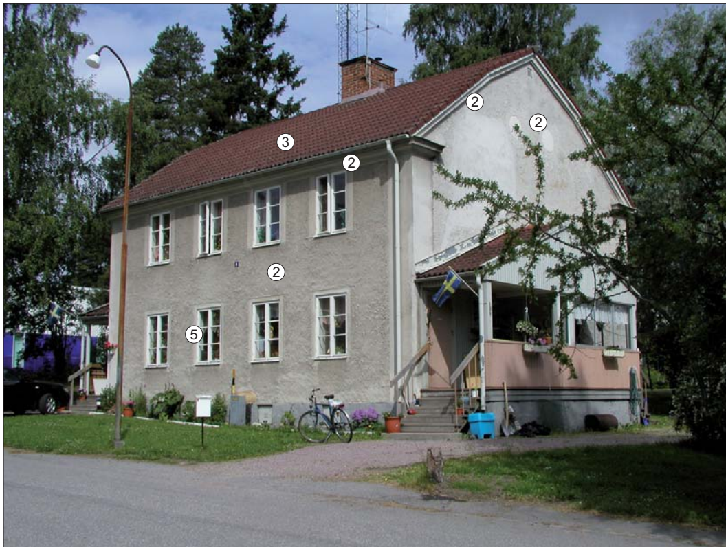
Bryggargatan 4. Karaktärsskapande arkitekturelement markerade.
