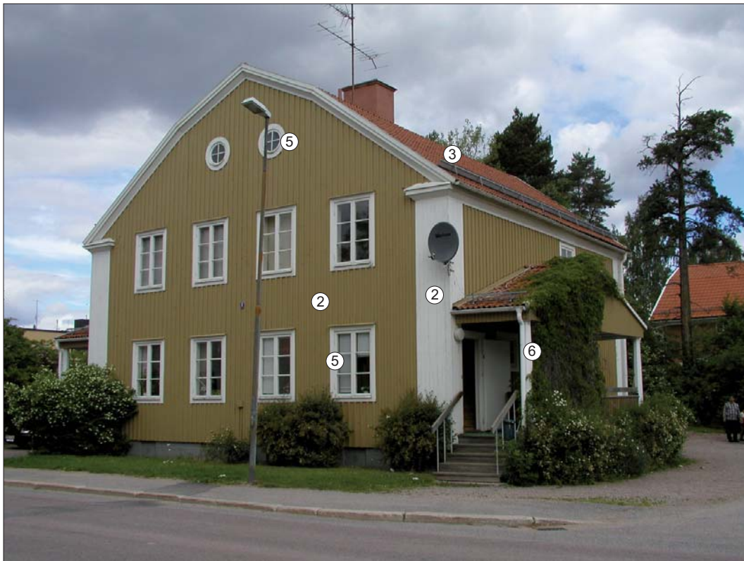
Skolgatan 8. Karaktärsskapande arkitekturelement markerade.
