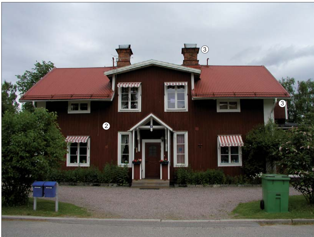
Källgatan 6, bostadshuset. Karaktärsskapande arkitekturelement markerade.
