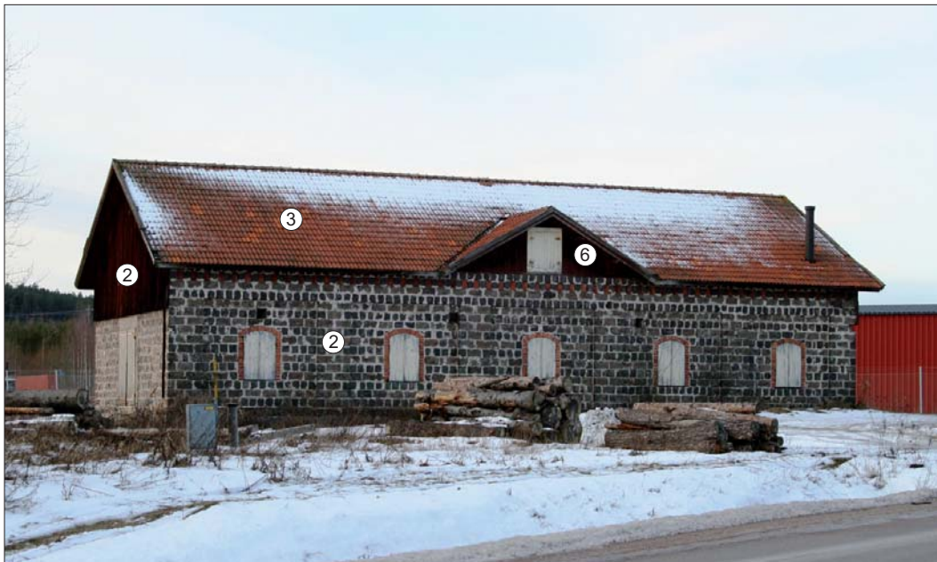
Karaktärsskapande arkitekturelement markerade.
