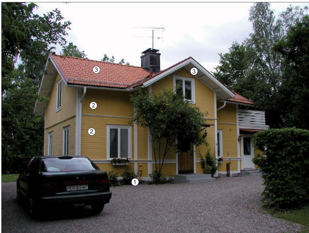
Kanalgatan 9, bostadshuset. Karaktärsskapande arkitekturelement markerade.
