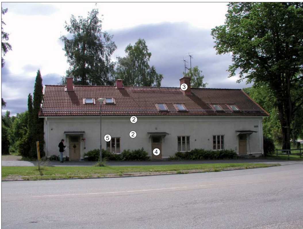
Bostadshuset. Karaktärsskapande arkitekturelement markerade.
