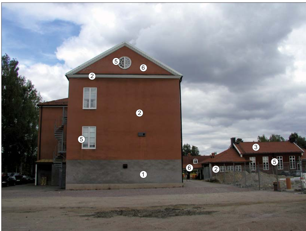
Högtomtaskolan och gymnastikbyggnaden. Karaktärsskapande arkitekturelement markerade.
