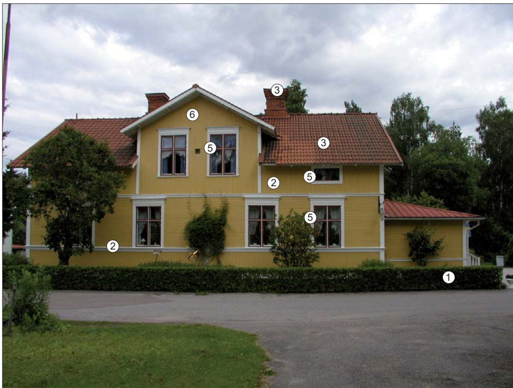
Armégatan 5, bostadshuset. Karaktärsskapande arkitekturelement markerade.
