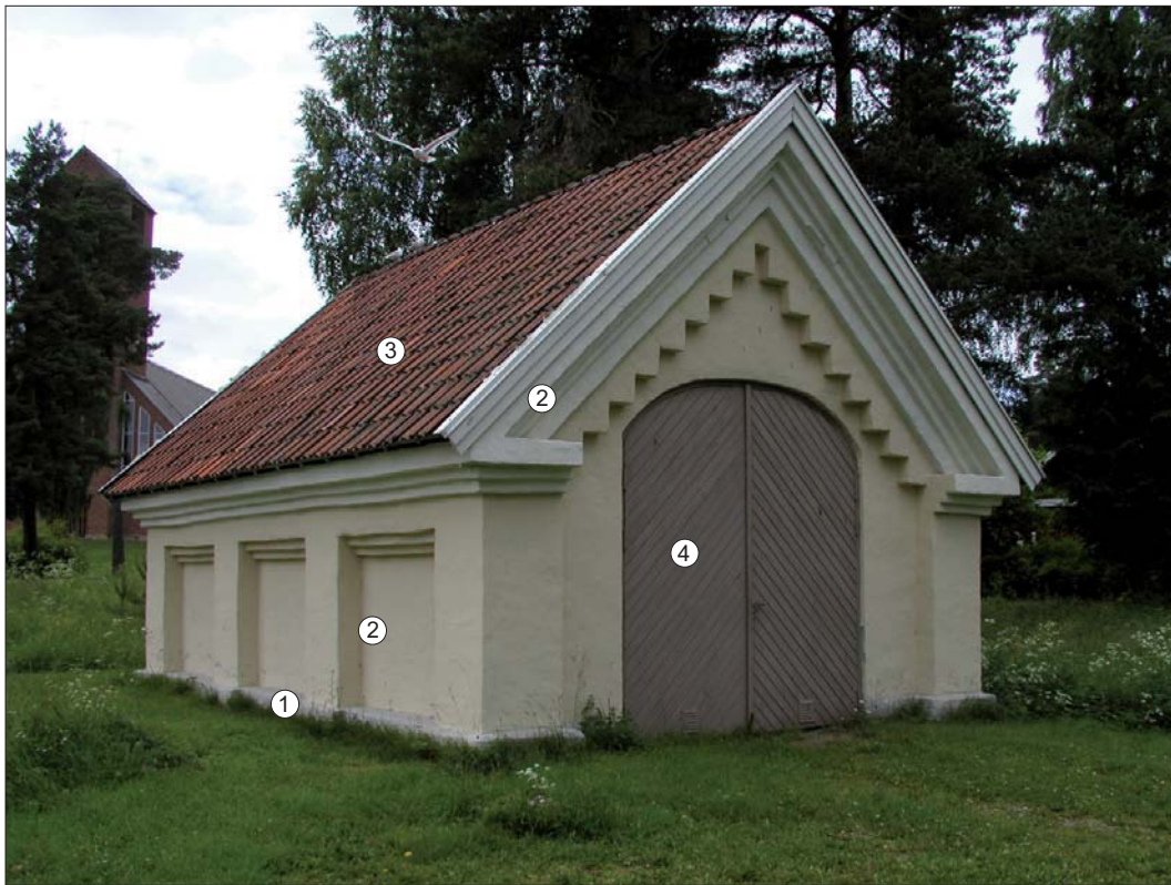
Hantverkargatan 2, likboden. Karaktärsskapande arkitekturelement markerade.
