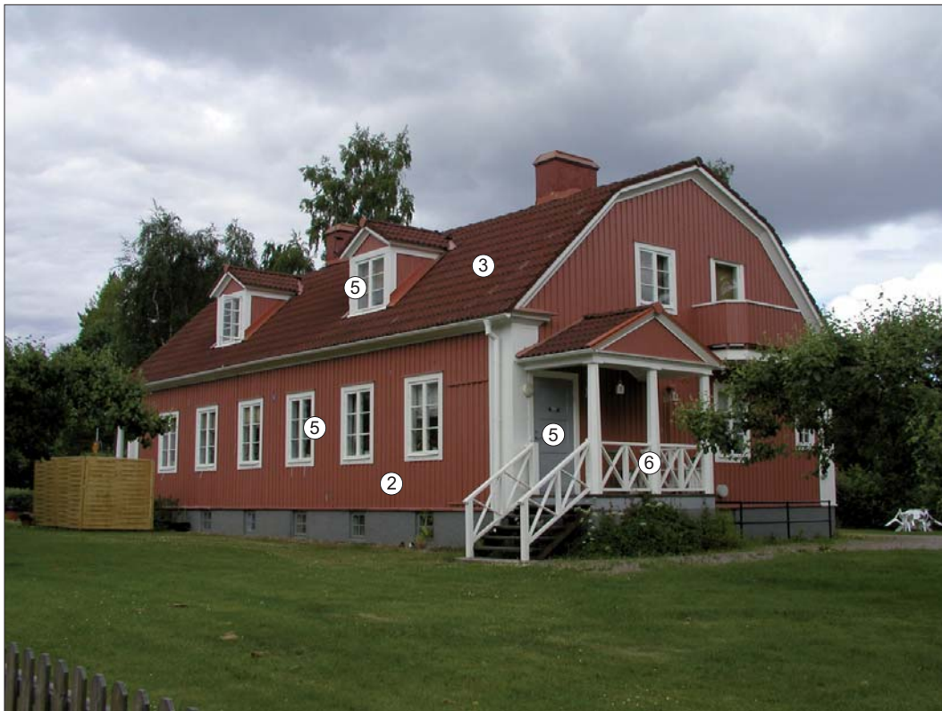
Skolgatan 6. Karaktärsskapande arkitekturelement markerade.
