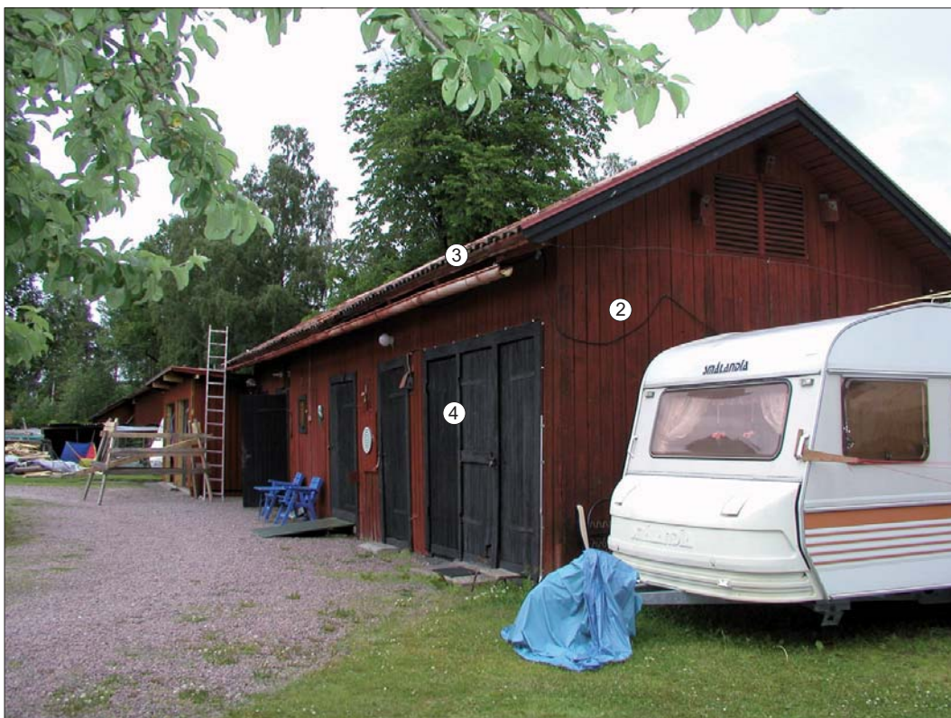
Källgatan 6, uthuset. Karaktärsskapande arkitekturelement markerade.
