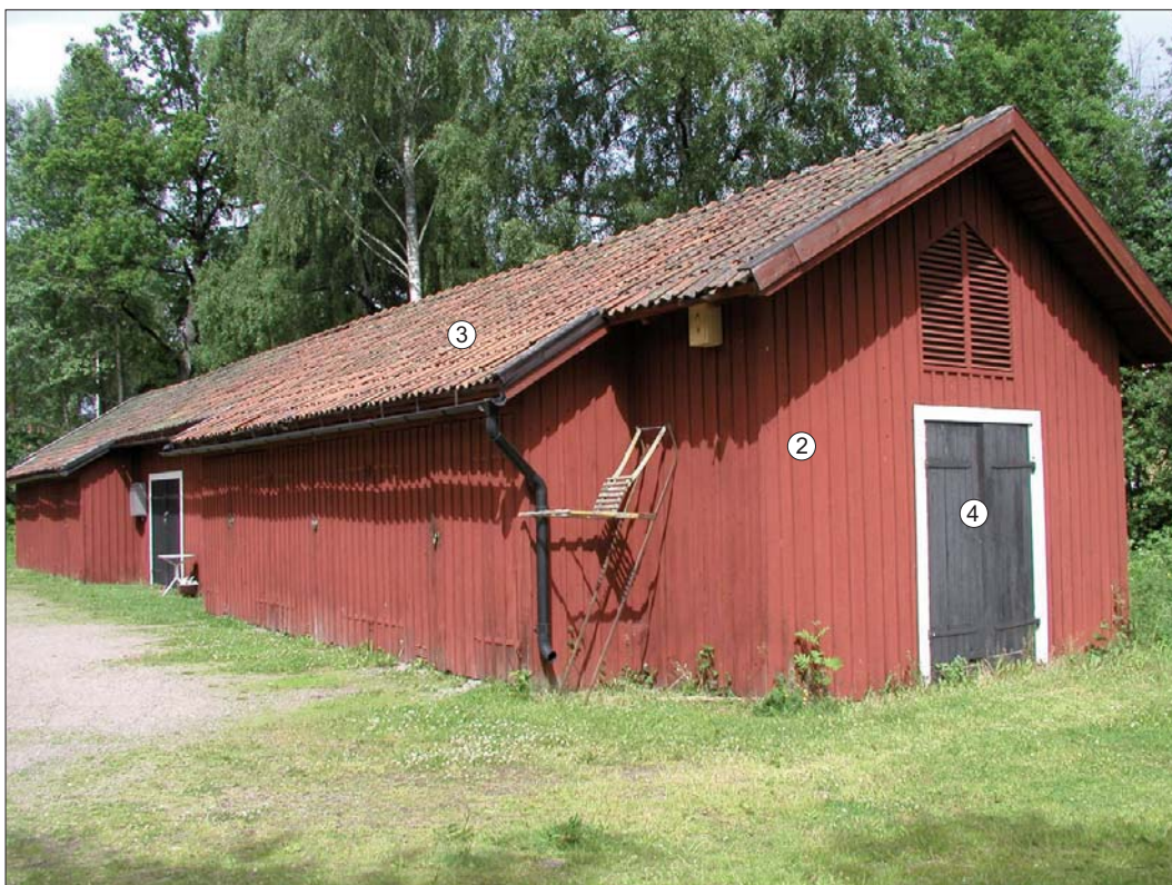
Källgatan 8, uthuset. Karaktärsskapande arkitekturelement markerade.
