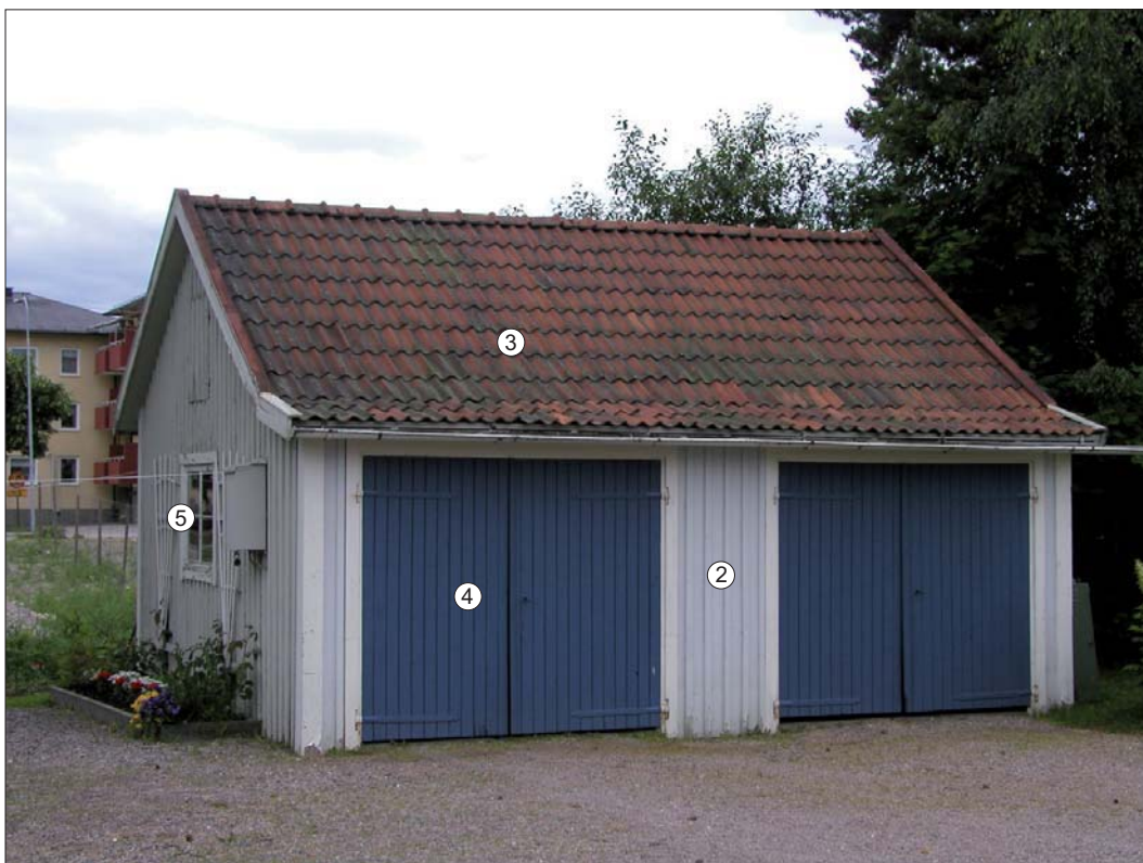
Smålandsgatan 12, uthusbyggnaden med garage. Karaktärsskapande arkitekturelement markerade.
