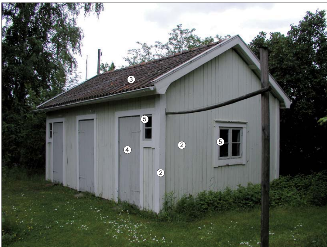
Eriksgatan 11, uthuset. Karaktärsskapande arkitekturelement markerade.
