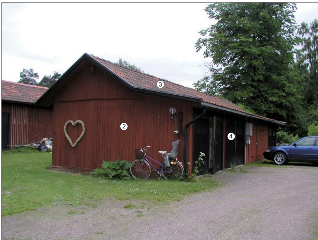
Kanalgatan 7, uthuset. Karaktärsskapande arkitekturelement markerade.
