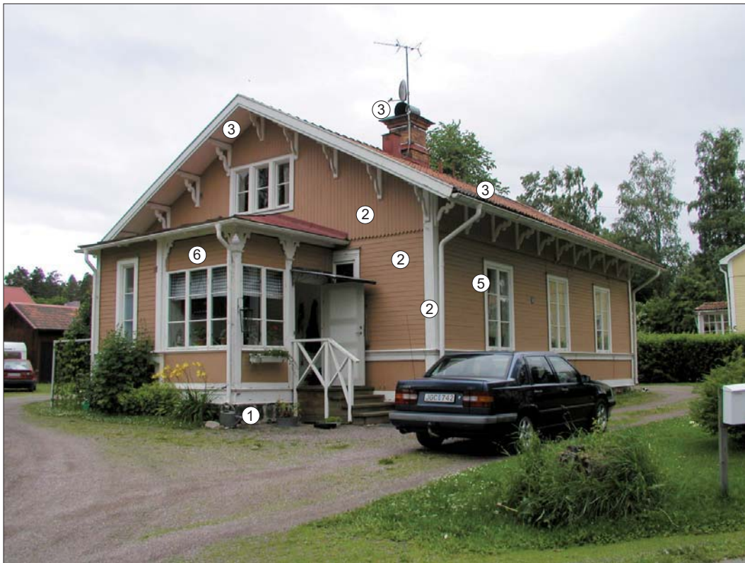
Kanalgatan 5, bostadshuset. Karaktärsskapande arkitekturelement markerade.
