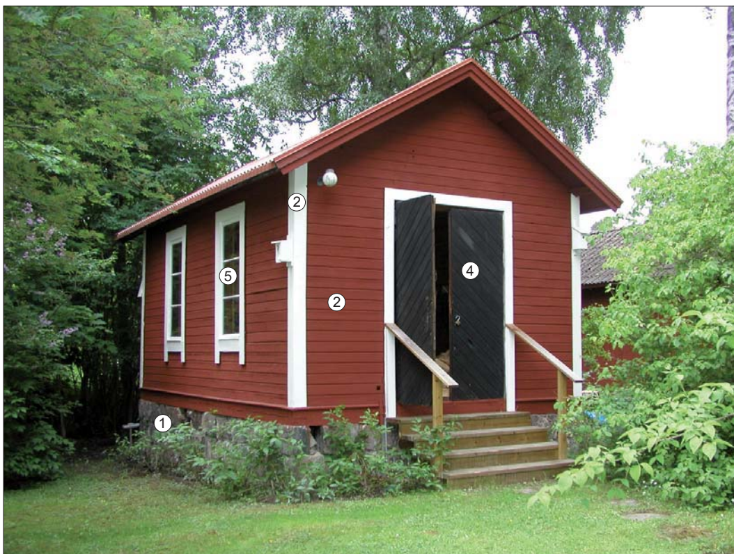
Kanalgatan 9, uthuset, f.d. affär. Karaktärsskapande arkitekturelement markerade.
