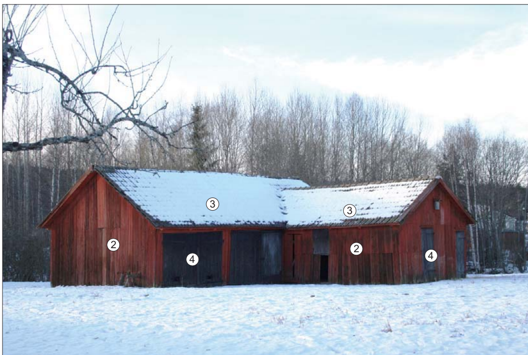
Wirénska gården uthus/garage. Karaktärsskapande arkitekturelement markerade.
