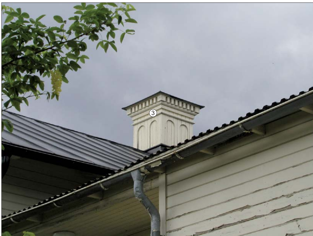
Kapellgatan 4, detalj av ventilationsskorsten. Karaktärsskapande arkitekturelement markerade.
