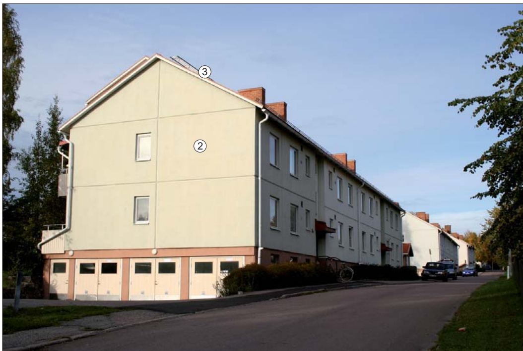
Synargatan 8, från gatan. Karaktärsskapande arkitekturelement markerade.
