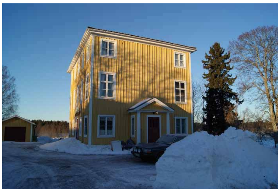
Mangårdsbyggnaden, östra fasaden med köksfarstun. Foto: Länsmuseet Gävleborg
