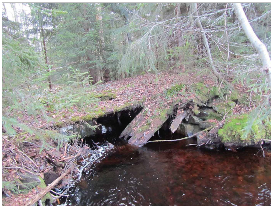
Bild 5. Övergiven bro efter äldre vägsträckning, lämning nr 15. Foto: Inga Blennå
