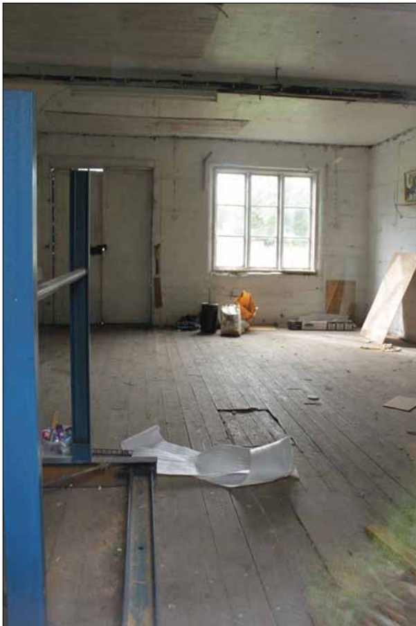
Verkstaden är indelad i två utrymmen. Detta utrymme ligger vägg i vägg med garagen och bär spår från remdrivna maskiner. Foto: Länsmuseum Gävleborg.
