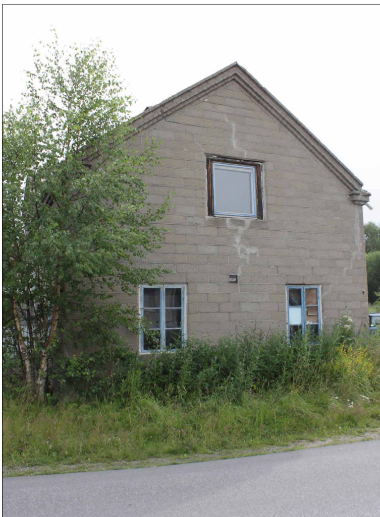
Byggnadens sydvästra gavel. Övervåningens troliga bostadsdel har moderniserats med perspektivfönster. Nedervåningen har originalbågarna med valsat glas bevarade. Foto: Läns museet Gävleborg.
