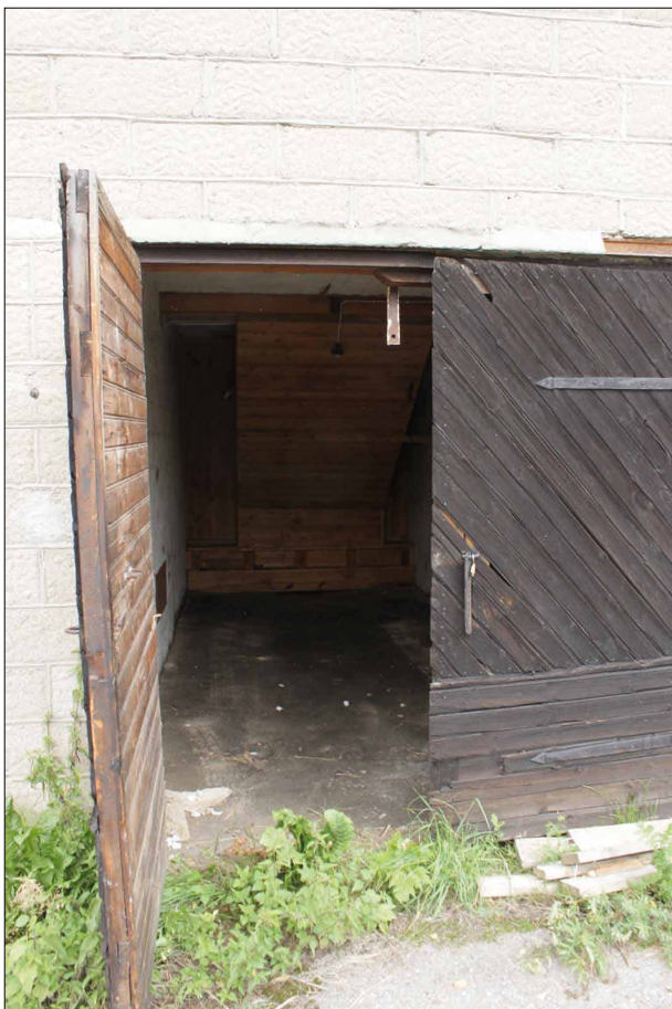
Garageportarna är av ramverk, klädda med spontad panel och ursprungligen tjärade. Portgångjärnen är smidda. Foto: Läns museet Gävleborg
