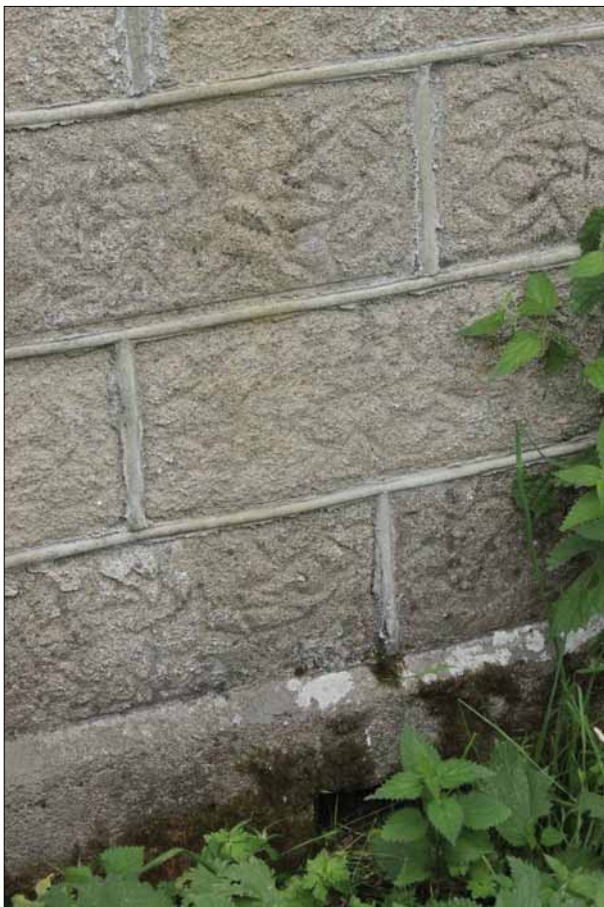
Väggarna är murade med dekorativt mönstrade cementblock. I sockeln syns även en luftglugg till grunden. Foto: Läns museet Gävleborg
