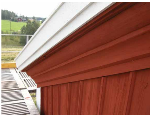
Ill. 14. Detalj av takfoten vid den nordöstra gaveln efter renovering. Foto: Daniel Olsson, Läns museet Gävleborg 2009-08-25.
