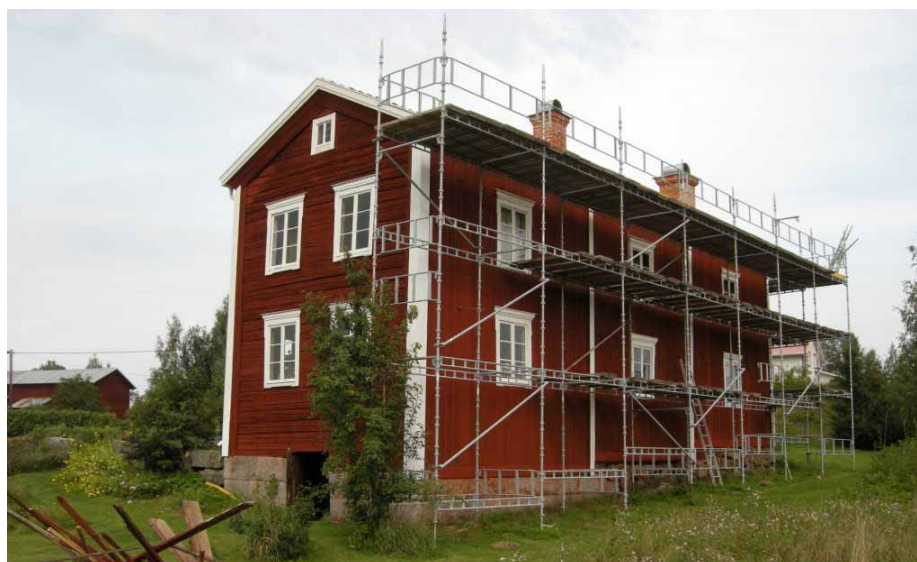
Ill. 8. Mangårdsbyggnaden från söder med byggnadsställning för takarbetet. Foto: Daniel Olsson, Länsmuseum Gävleborg, 2009-08-25.
