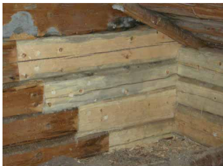
Ill. 9. Detalj av knut mot väster på vinden efter timmerlagning.
