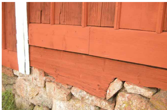
Ill. 11. Detalj av fasad mot sydost efter byte av sockelbrädor, en ny panelbräda samt ny profilerad läkt. Foto från öster, Daniel Olsson, Läns museet Gävleborg, 2009-08-25.
