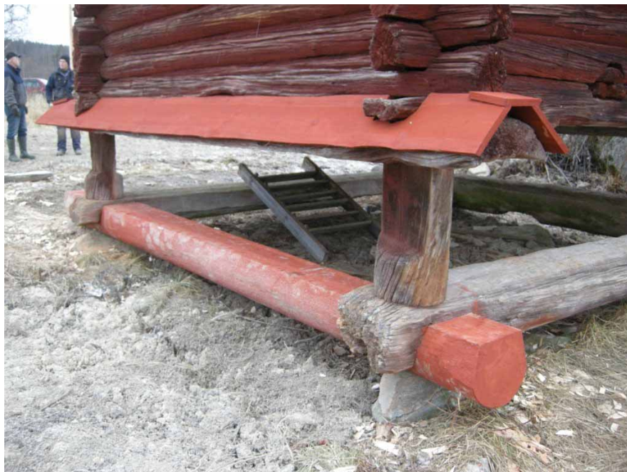
Ill. 8. Den nya västra delen av syllramen och den västra mushyllan sedan den renoverats och försetts med täckbrädor. I bakgrunden skimtar Olle Michelson och Roland Åkerman. Foto från sydväst, Daniel Olsson, Länsmuseet Gävleborg 2009-11-13.
