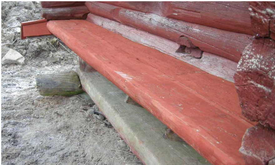
Ill. 9. Svalens golv efter byte av den yttersta golvplankan. Den inre golvplankan har enbart rödfärgats. Foto från nordväst, Läns museet Gävleborg 2009-11-13.
