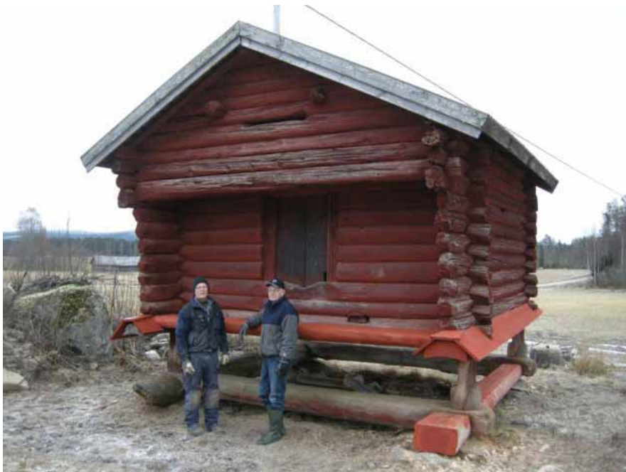
Ill. 10. Roland Åkerman och Olle Michelson vid slutbesiktningen efter renoveringen av härbret. Foto från nordväst, Daniel Olsson, Läns museet Gävleborg, 2009-11-13.
