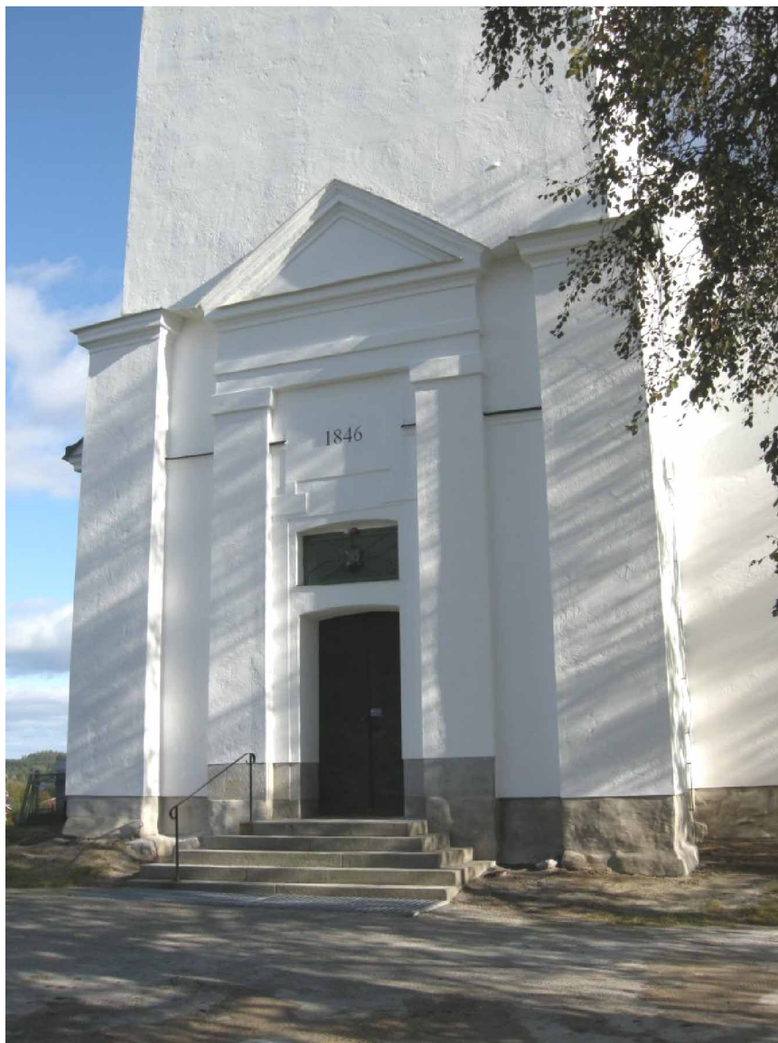
Ill. 16. Den nedre delen av kyrktornets västra fasad efter renoveringen. Foto: Daniel Olsson, Länsmuseet Gävleborg, 2009-09-16.
