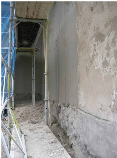
Ill. 9. Nytt bruk har påförts de frilagda naturstensytorna på tornfasaden. Foto från nordväst, Daniel Olsson Läns museet Gävleborg 2007-02-09.
