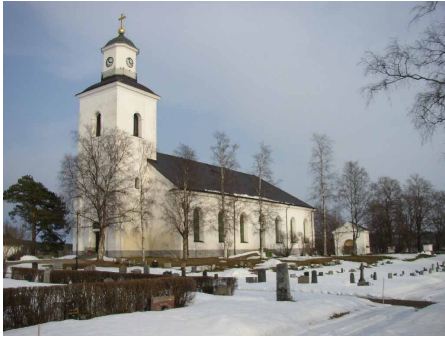
Ill. 1. Bergsjö kyrka före renoveringen sedd från sydväst. Foto: Daniel Olsson, Länsmuseet Gävleborg, 2007-03-23.
