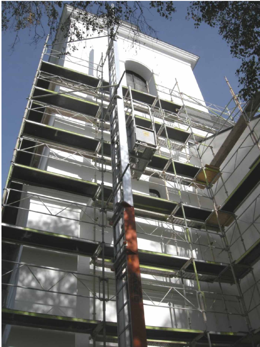
Ill. 17. Kyrktornets södra fasad efter påbörjad ställningsrivning. Foto från sydväst, Daniel Olsson Läns museet Gävleborg 2009-09-08.
