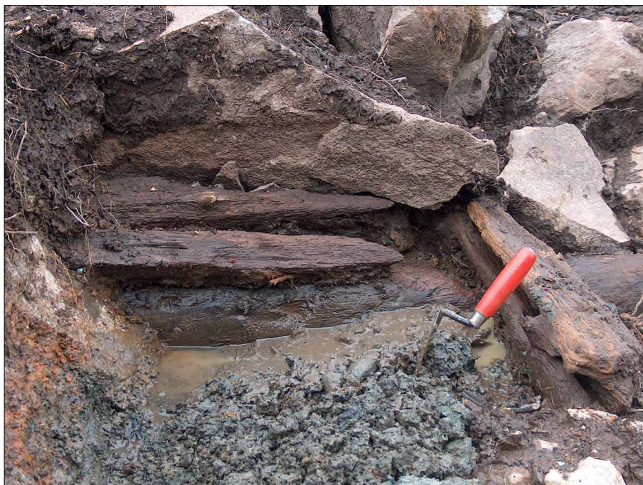
Bild 15. Knuttimrad träkonstruktion i botten av vallen. Foto: Bo Ulfhielm.
