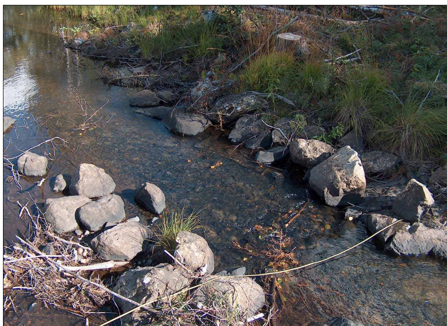
Bild 16. Södra delen av "vattenverket" direkt nedanför dammvall 2. Foto: Bo Ulfhielm.
