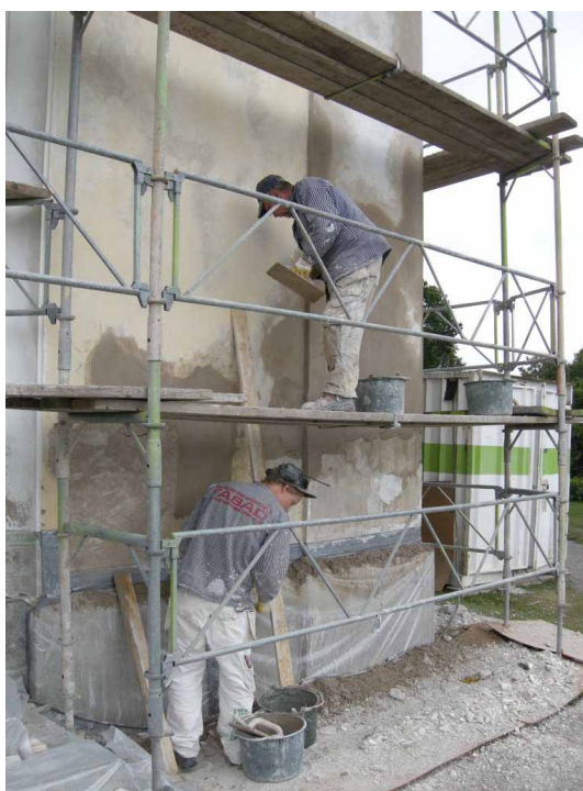
Ill. 7. Lars Abrahamsson (på ställningen) och Niklas Sundgren (på marken) båda Söderhamns fasadrenoveringar, under pågående putsningsarbete på tornets södra fasad. Foto från sydväst, Daniel Olsson, Läns museet Gävleborg, 2009-07-07.
