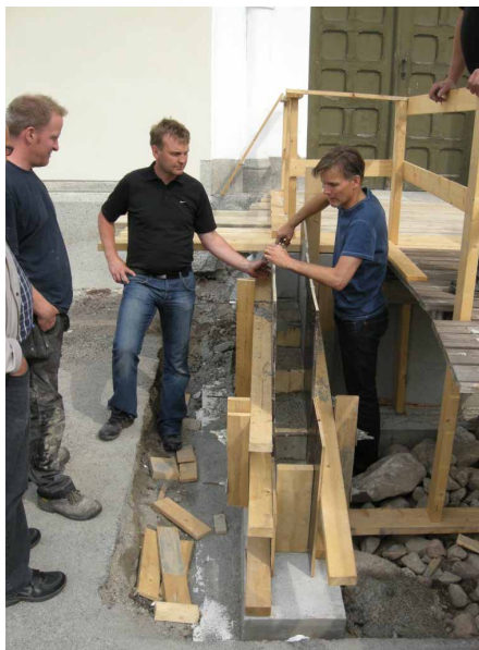
Ill. 13. P-O Johnsson, Kilafors sten & kakel, Patrik Lönn, Skanska och Hans-Erik Hansson, Länsstyrelsen, diskuterar stentrappans detaljutförande. Foto från söder, Daniel Olsson, Läns-museet Gävleborg, 2010-06-30.
