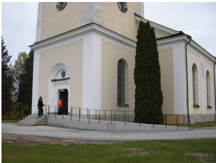
Ill. 16. Kyrkan med omputsade fasader på tornets nedre partier, långhusets södra fasad samt ny trappa och ramp. Foto: Daniel Olsson, Läns museet Gävleborg, 2010-10-06.
