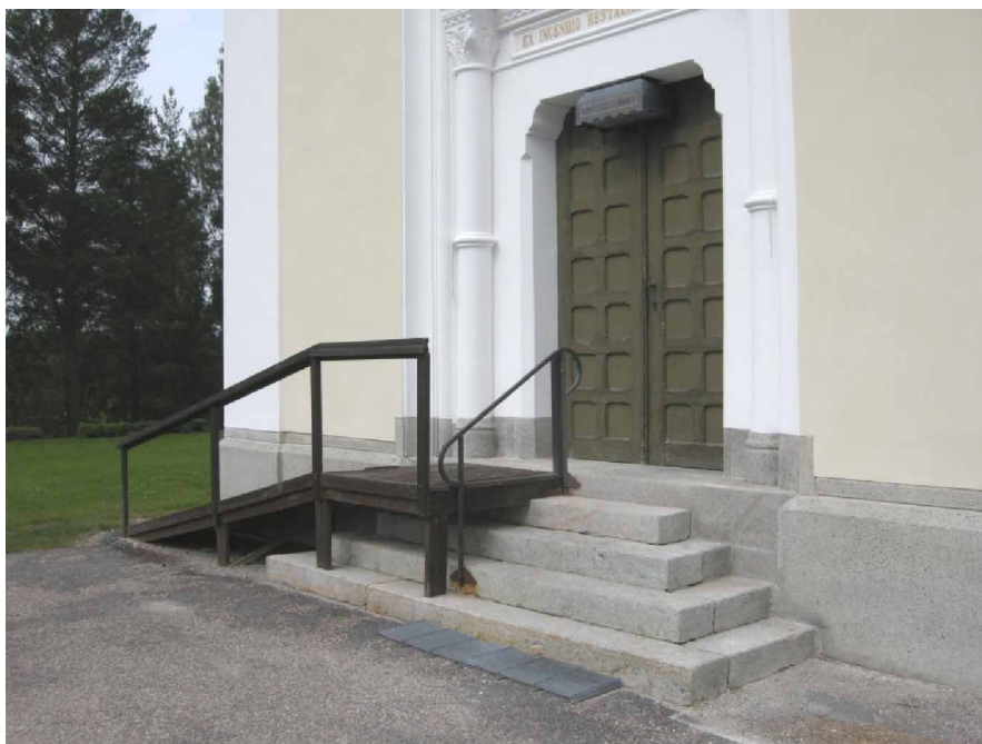
Ill. 5. Huvudentrén från sydost med ursprunglig stentrappa och träramp. Foto: Daniel Olsson, Läns museet Gävleborg 2009-08-10.
