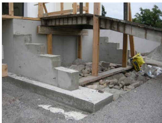
Ill. 9. Den nya trappans bärande gjutna betongkonstruktion. Över konstruktionen löper den tillfälliga rampen under byggtiden. Foto från sydväst, Daniel Olsson, Läns museet Gävleborg, 2010-08-18.
