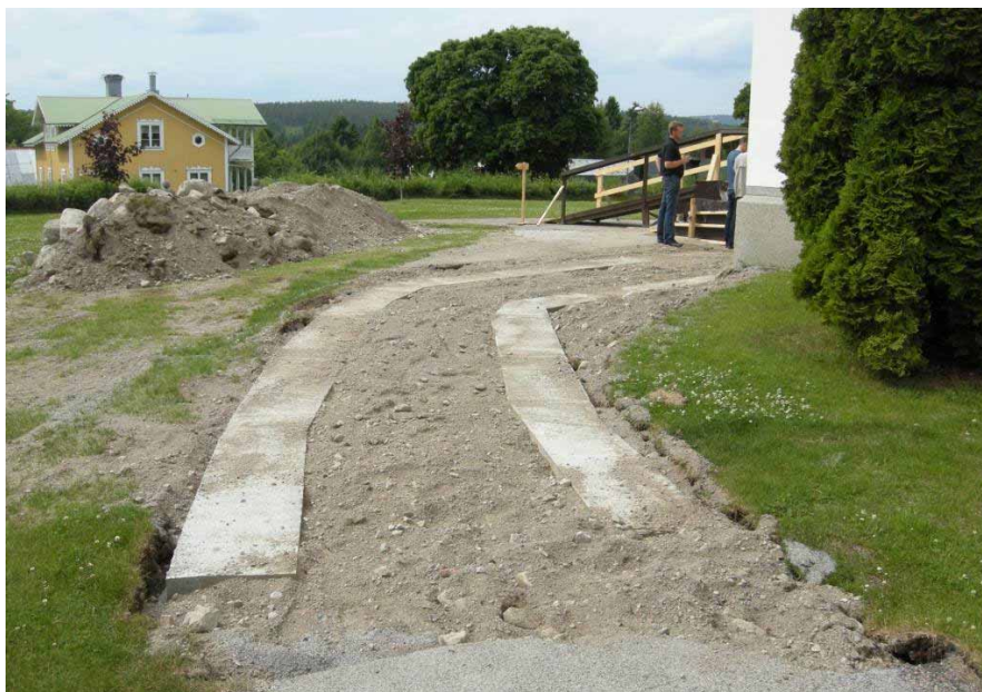
Ill. 8. Grundläggning med gjutna betongsulor utförd för rampen. Foto från nordost, Daniel Olsson, Läns museet Gävleborg, 2010-06-30.
