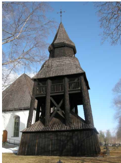
Ill. 3 Klockstapeln från sydväst före renoveringen. Foto: Daniel Olsson, Länsmuseet Gävleborg 2010-04-13.
