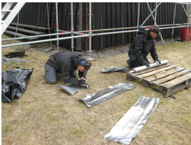
Ill. 9. Bröderna Mats och Jonas Hugg, Hälsinge takspån, klipper och viker till blyplåt till tätning av klockstapelns särskilt utsatta punkter. Foto från nordväst, Daniel Olsson, Läns museet Gävleborg 2010-04-27.
