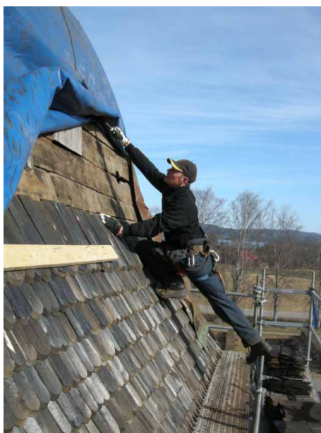
Ill. 7. Mats Hugg från Hälsinge takspån frilägger takluckan på klockstapelns östra takfall. På takytans nedre del har nya rader av takspån spikats fast. Foto från sydost, Daniel Olsson, Länsmuseet Gävleborg 2010-04-27.
