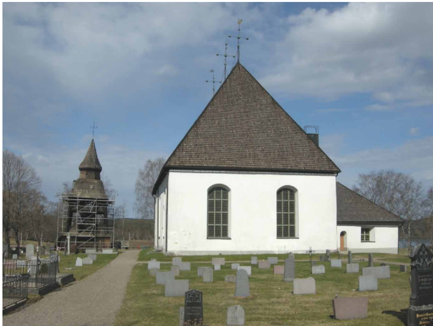
Ill. 2. Bjuråkers kyrkomiljö med klockstapeln med byggnadsställningar, del av kyrkogården samt kyrkan från öster. Foto: Daniel Olsson, Länsmuseet Gävleborg, 2010-05-06.
