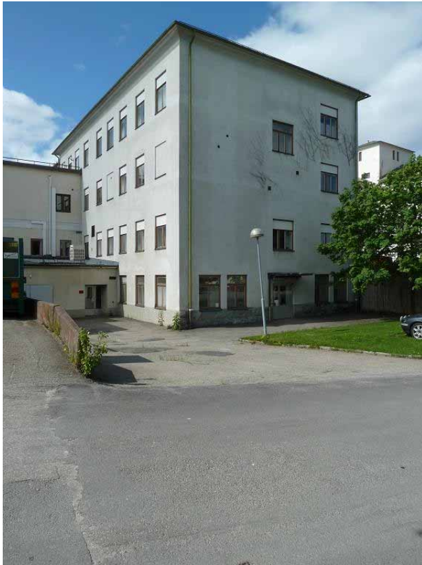
Bild 18. Byggnad 3 sedd från norr.
