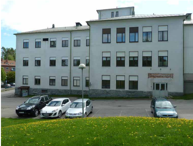
Bild 13. Byggnad 2 sedd från väster. Den högra delen är påbyggd på den ursprungliga flygeln, den vänstra delen sannolikt tillkommen vid samma tid. Uppe på taket skjuter hissens maskinrum upp som ett dekorativt torn.
