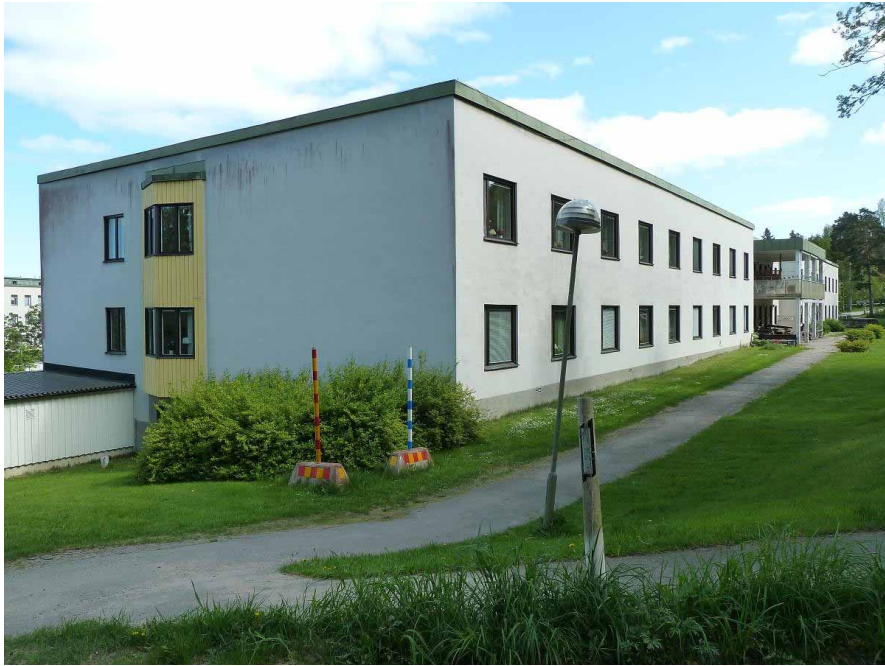
Bild 54. Byggnad 13 sedd från sydväst.
