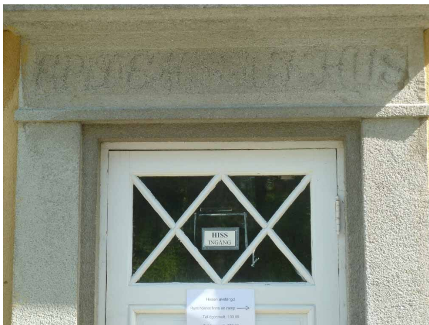
Bild 41. Fd epidemisjukhuset. Entré mot väster. Notera svag text i stenpartiet ovan dörren : "EPIDEMISJUKHUS".
