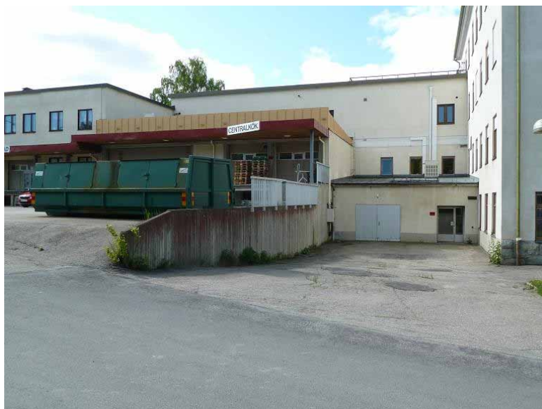
Bild 21. Byggnad 6 sedd från norr.
