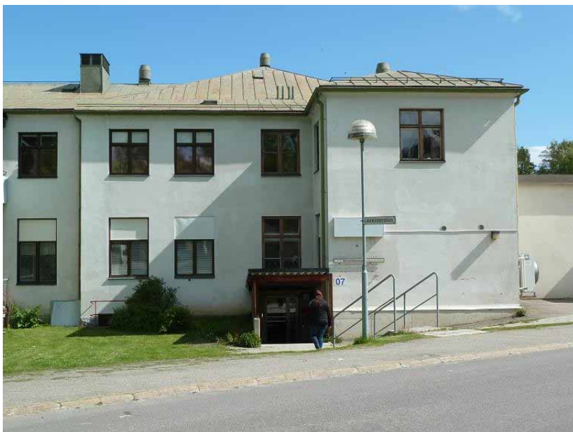
Bild 16. Byggnad 3 sedd från söder.
