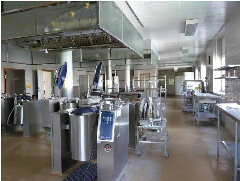
Bild 23. Centralköket i byggnad 6.
