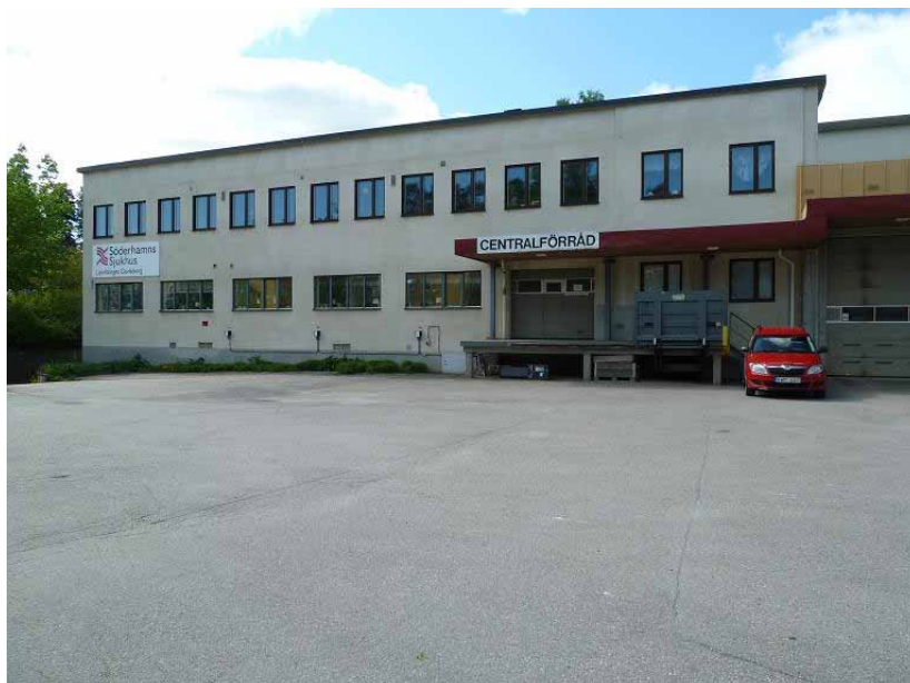
Bild 29. Byggnad 7 sedd från norr.
