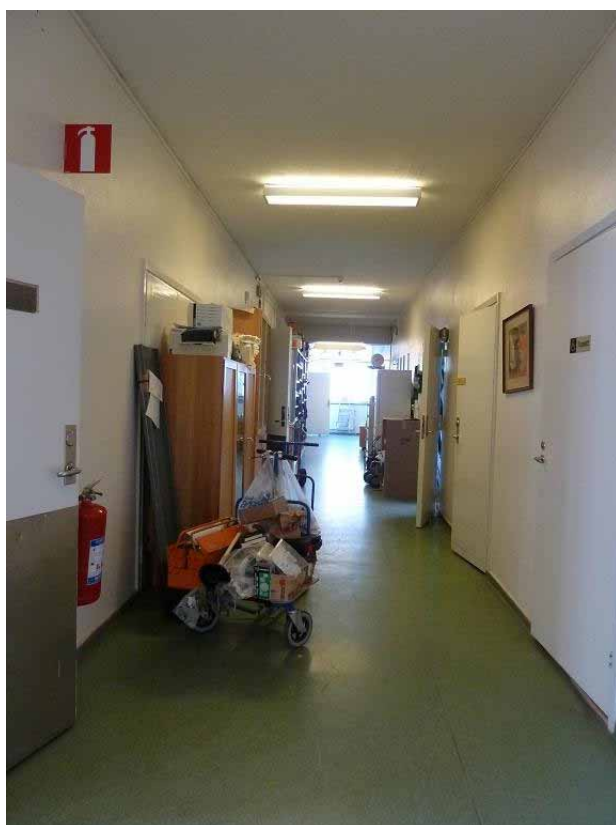
Bild 30. Byggnad 7, korridor utanför verkstadslokalerna.
