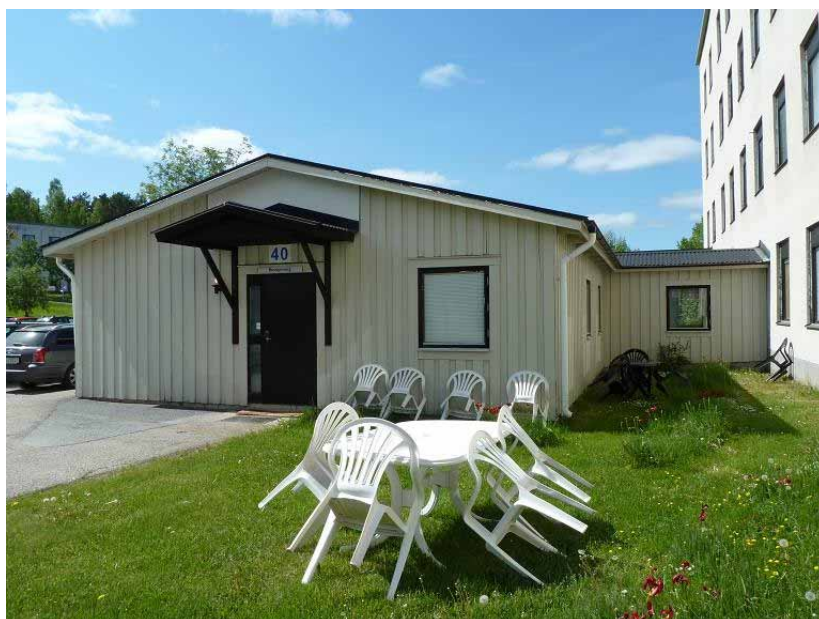
Bild 59. Byggnad 23 sedd från öster.
