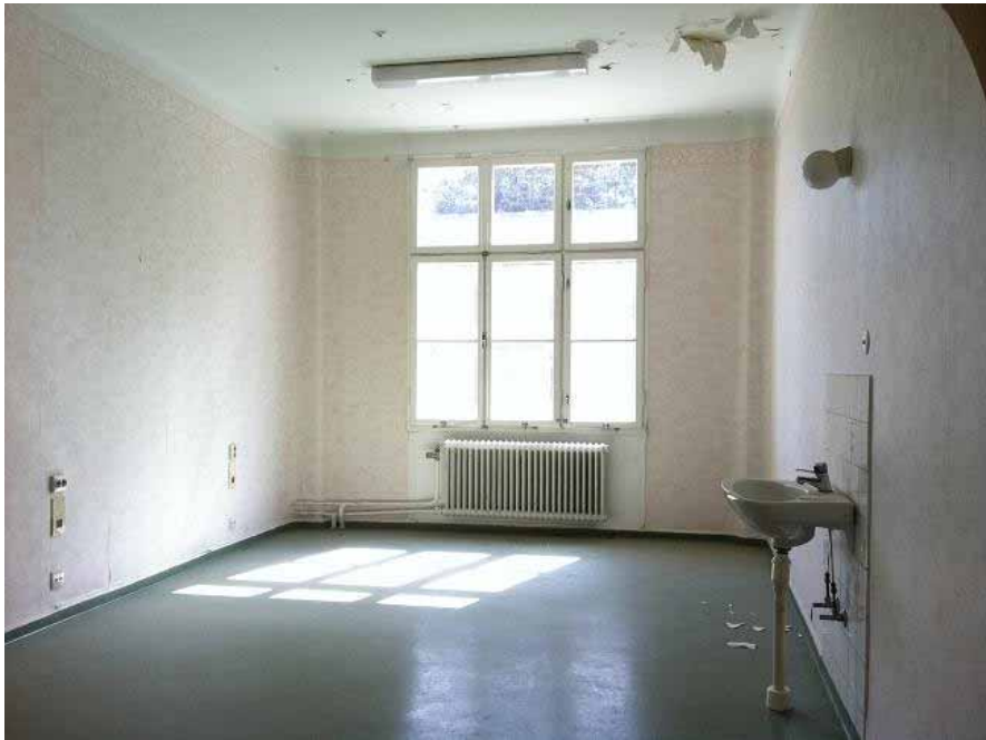
Bild 43. Ett av rummen i fd epidemisjukhuset, våning 2.
