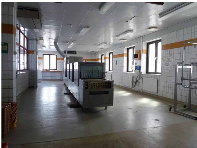
Bild 25. Centralköket/disken i byggnad 6.
