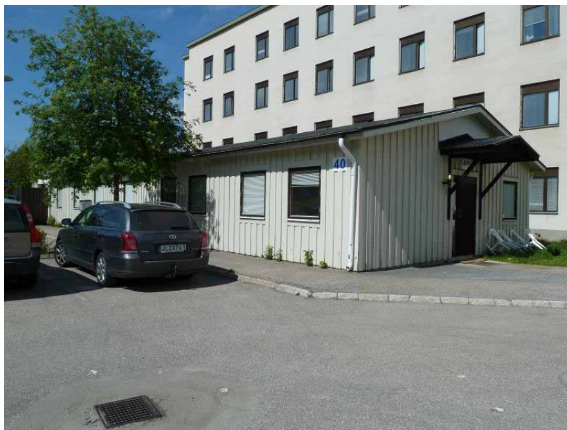
Bild 58. Byggnad 23 sedd från sydöst.
