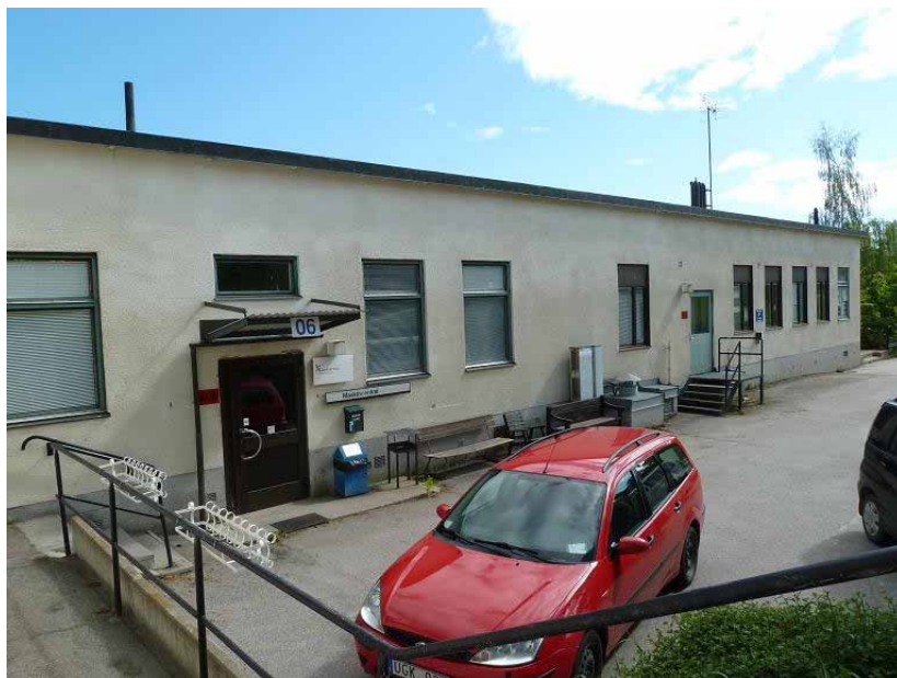
Bild 26. Byggnad 7 sedd från söder.
