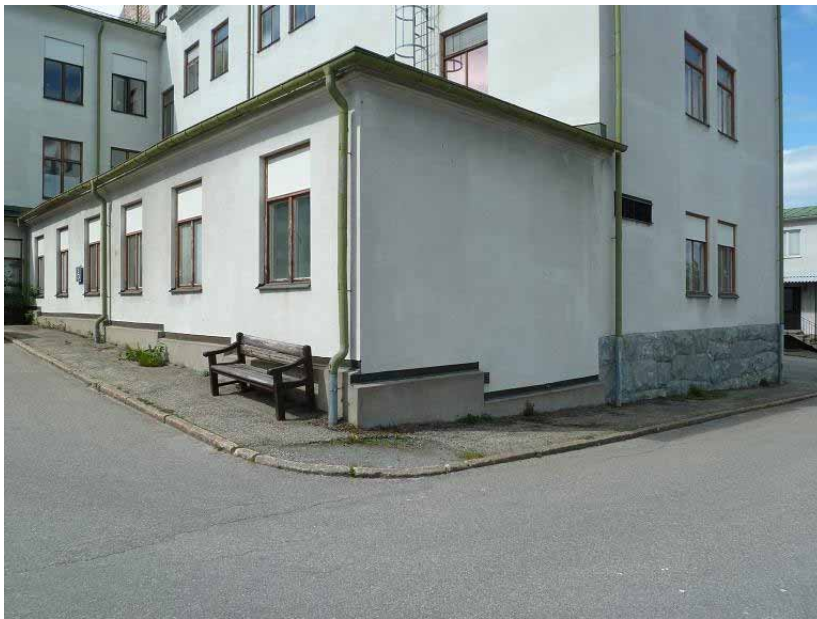
Bild 14. Byggnad 2 sedd från norr. Byggnaden är under ett senare skede tillbyggd med en del i en våning.
