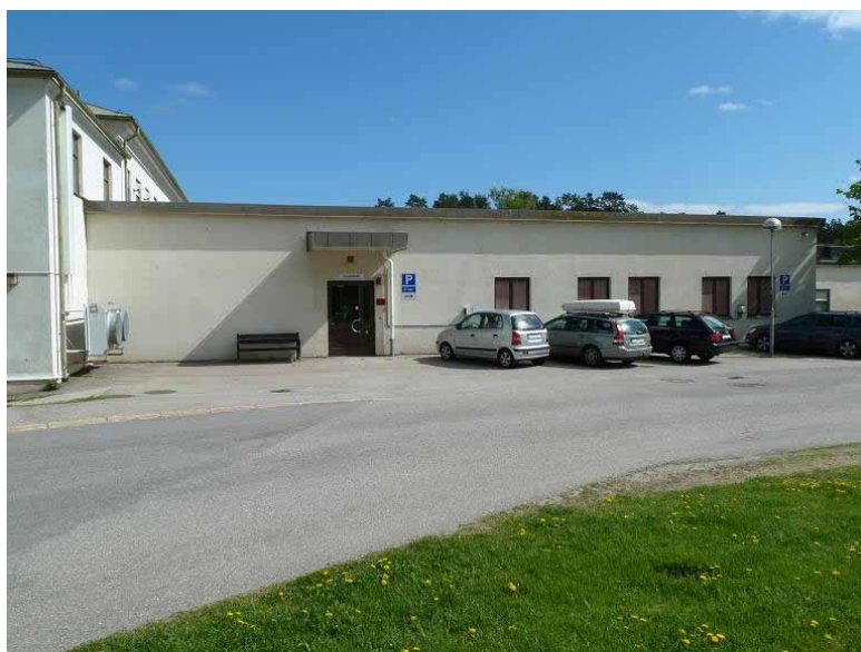
Bild 20. Byggnad 6 sedd från söder.
