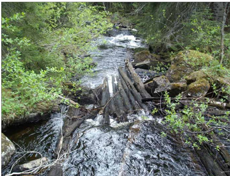
Bild 5. Skibord, en ränna av trästockar i bäckens riktning för att förhindra brötar och underlätta timrets väg över steniga partier och vattenfall. Lämning nr 3. Foto: Leif Andersson.
