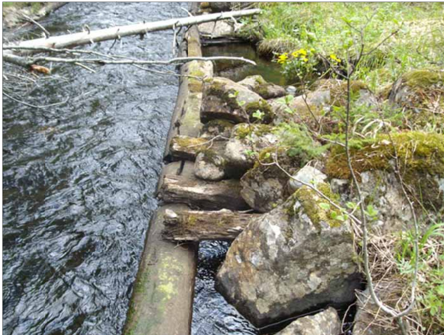
Bild 4. En av de många enkelkistorna längs med Bodsjöån. Här med väggen intakt som styrde timret och kanaliserade vattnet. Foto: Leif Andersson.
