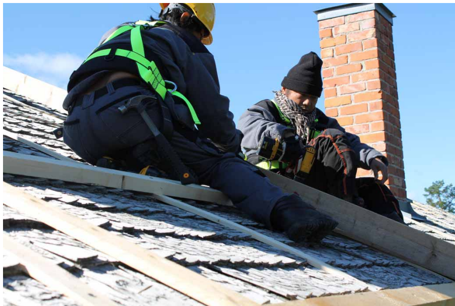
Figur 5. Ett spåntak läggs om med pannplåt. Ramsjö 2012.
