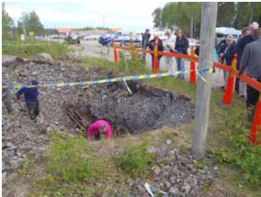
Bild 9. Besökare iakttar arbetena i gropen under invigningsdagen.
