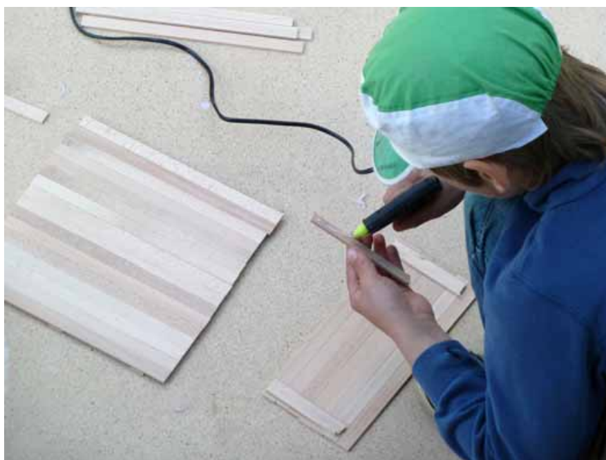
Figur 27. En vägg håller på att ta form!
