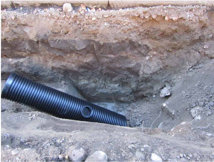
Figur 7. Schakt 1 från VNV. Det mörkbruna lagret utgör sannolikt en äldre markhorisont. Foto: Anders Altner
