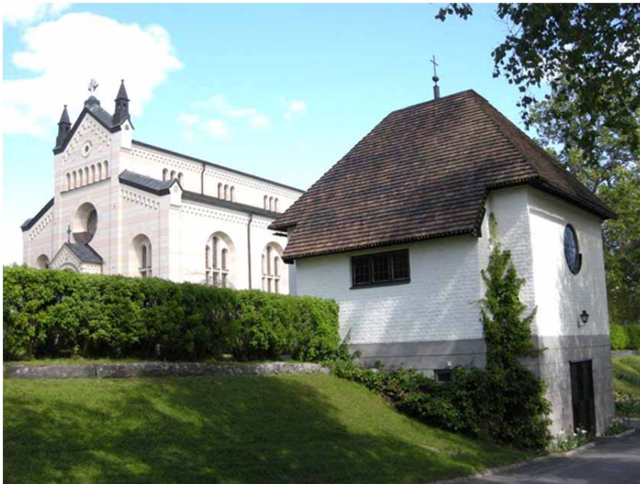
Figur 9. Gravkapellet vid Delsbo kyrka efter avslutad takrenovering. Foto från sydväst, Daniel Olsson, Läns museet Gävleborg 2010-06-04.
