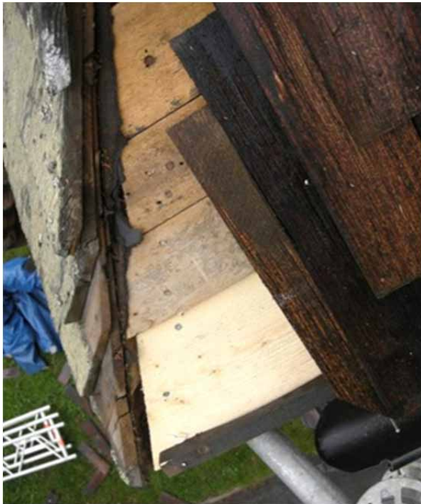
Figur 5. Detalj av det södra takfallet vid takfoten under omläggning. Panelbrädan nederst är utbytt. Det angränsade västra takfallet har kvar ursprunglig spåntäckning på takpapp. Foto från sydväst, Daniel Olsson, Läns museet Gävleborg 2010-05-19.
