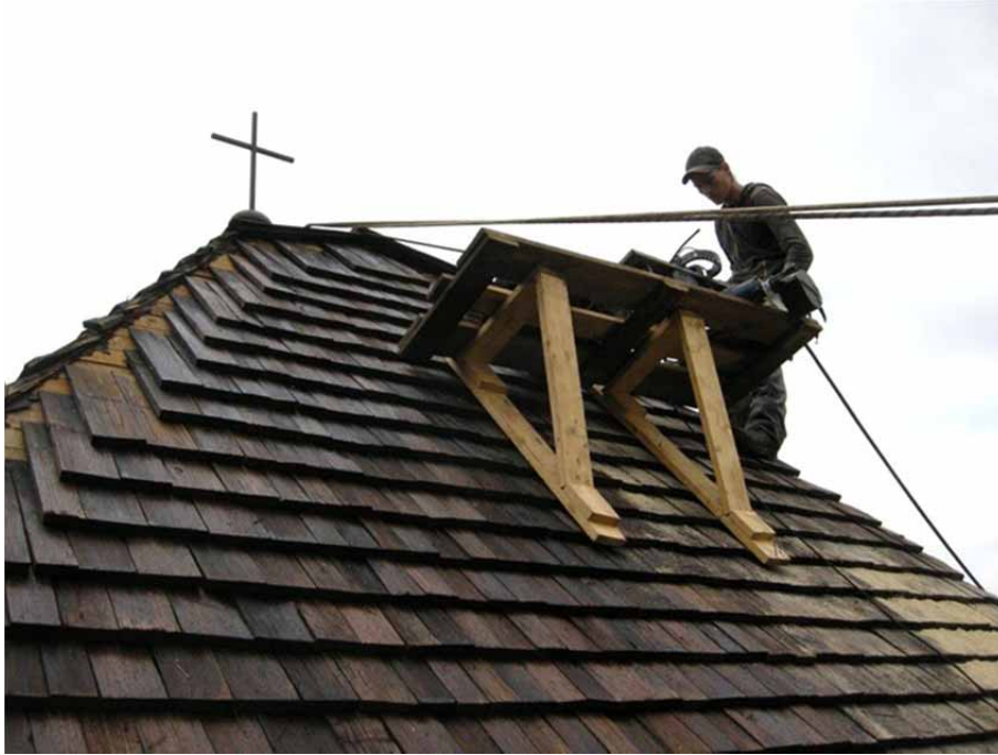
Figur 4. Jonas Hugg, Hälsinge takspån, Kilafors, under arbete på gravkappellets södra takfall. Foto från sydväst, Daniel Olsson, Läns museet Gävleborg 2010-05-19.
