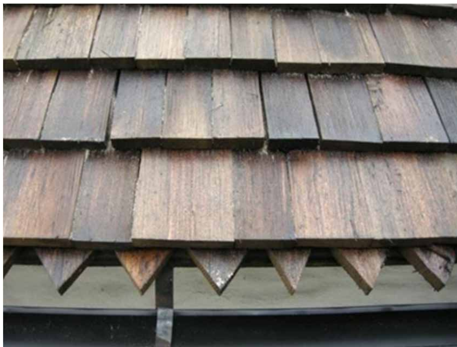
Figur 6. Detalj av takets nedersta del på ett av takfallen efter omläggning med ny takspån. Foto: Daniel Olsson, Länsmuseum Gävleborg 2010-05-19.
