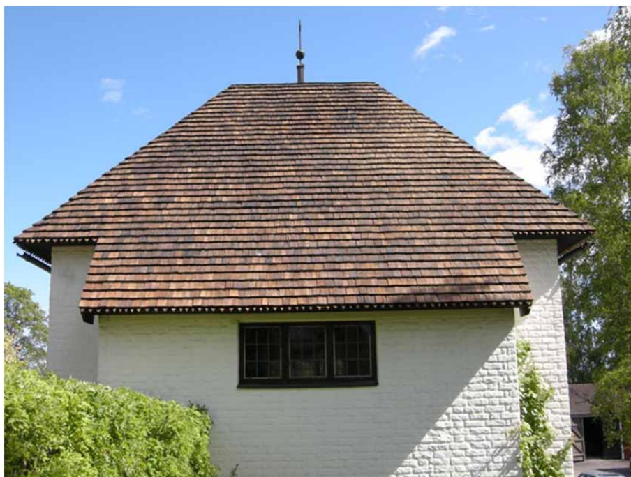
Figur 7. Gravkapellets östra fasad med nylagda takspån på takfallet. Foto från öster: Daniel Olsson, Läns museet Gävleborg, 2010-06-04.
