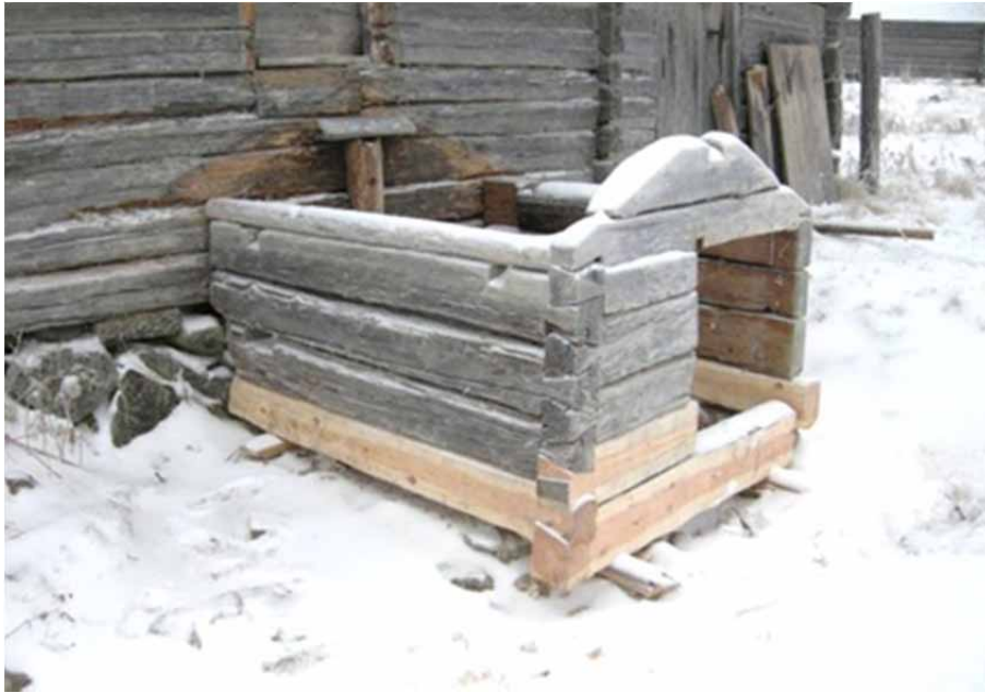
Figur 8. Källarsvalen under återuppförande. Foto från öster, Daniel Olsson, Läns museet Gävleborg 2010-11-12.
