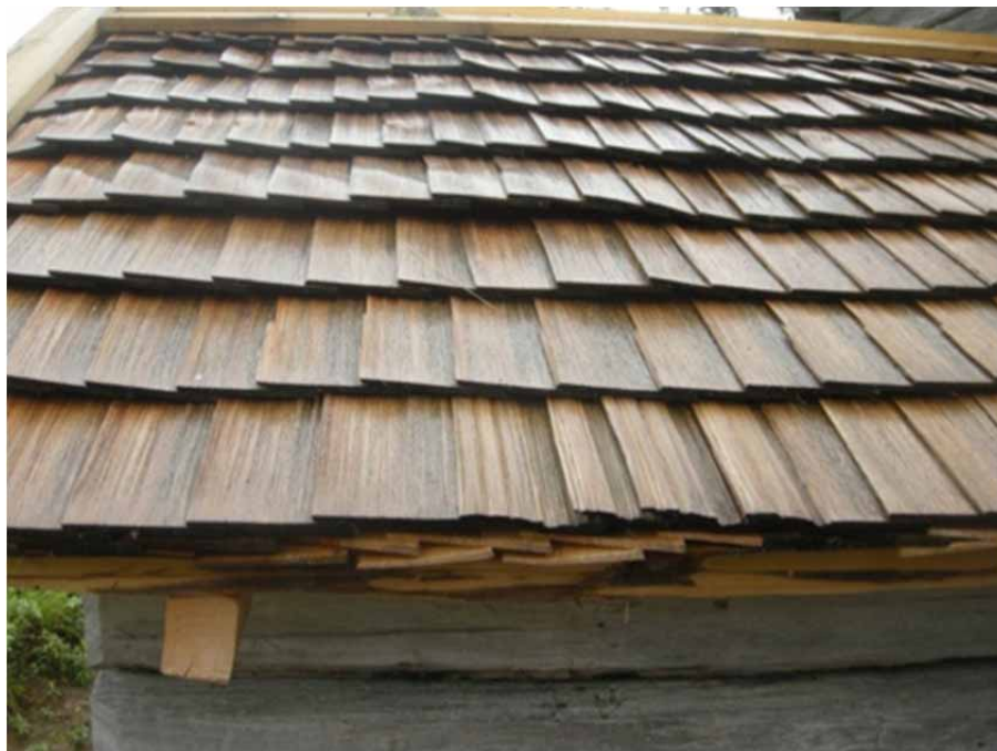
Figur 10. Detalj av källarsvalens takfall mot nordväst med nya takspån. Foto från nordväst, Daniel Olsson, Läns museet Gävleborg 2011-09-07.
