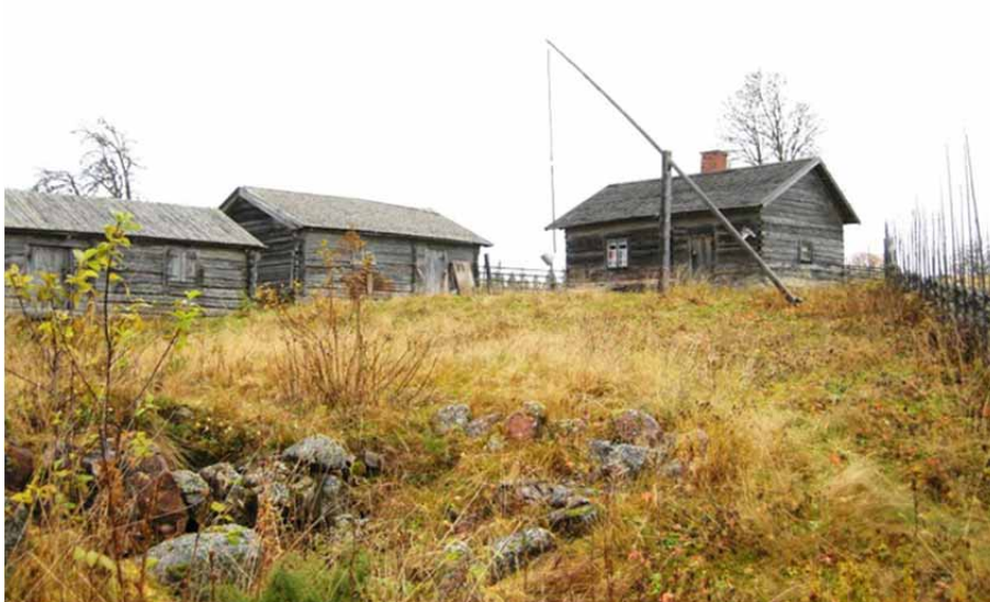
Figur 2. Oppigårds bod (i mitten av bilden) och vallstugan (till höger i bild). Foto från öster, Daniel Olsson, Länsmuseet Gävleborg 2010-10-07.
