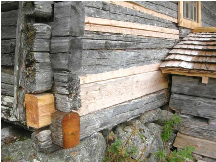
Figur 9. Detalj av timmerlagningar i bodens nordöstra vägg, Foto från öster, Daniel Olsson, Läns museet Gävleborg 2011-09-09.
