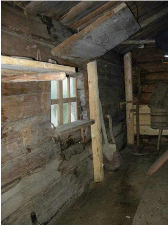
Figur 4. Interiör från bodens inre rum med luckan innanför fönstret i uppfällt läge. Foto från väster, Daniel Olsson, Länsmuseet 2009-10-29.
