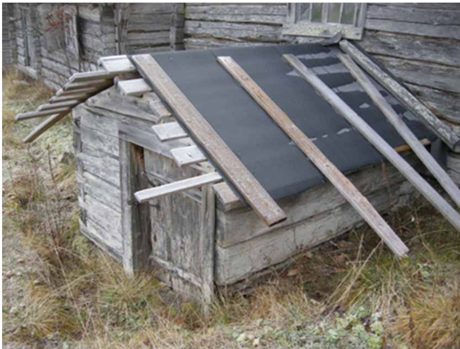
Figur 6. Källarsvalen före renoveringen med provisorisk täckning med takpapp. Foto från norr, Daniel Olsson, Läns museet Gävleborg 2009-10-29.
