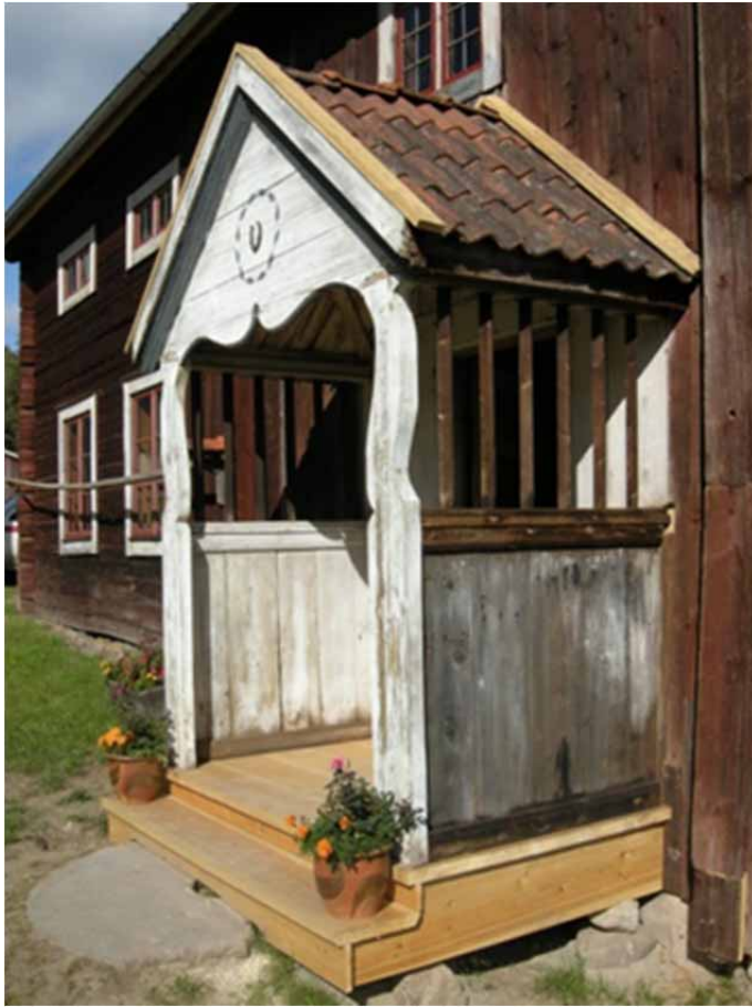
Figur 10. Brokvisten efter renovering. Foto från sydost, Daniel Olsson, Läns museet Gävleborg 2009-09-03.
