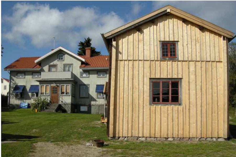
Figur 9. Gammelbyggningen med ny panel på den östra gaveln. Till vänster ses gårdens huvudbyggnad. Foto från öster, Daniel Olsson, Länsmuseet Gävleborg 2009-09-03.
