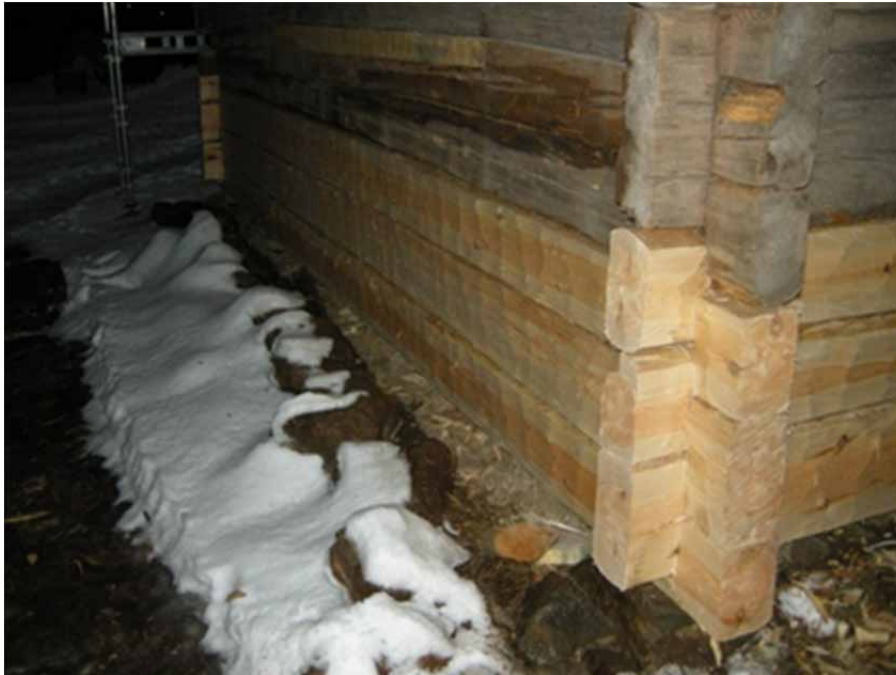
Figur 8. Utbytt timmer i husets östra fasad. Foto från nordost, Daniel Olsson, Länsmuseet Gävleborg 2008-12-17.
