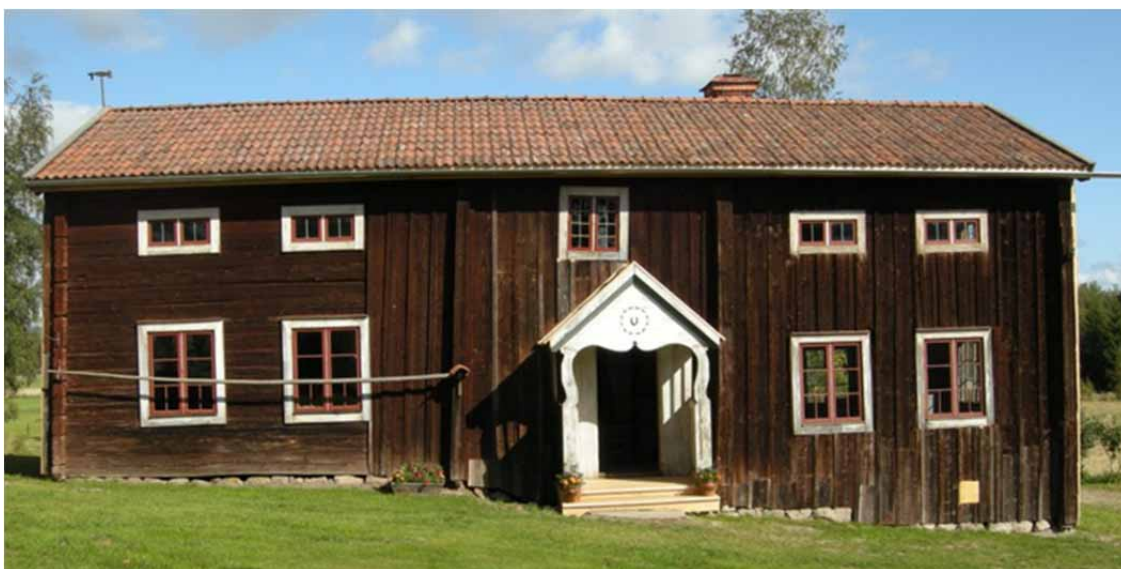
Figur 12. Byggnaden efter avslutad renovering. Foto från söder, Daniel Olsson, Länsmuseet Gävleborg 2009-09-03.
