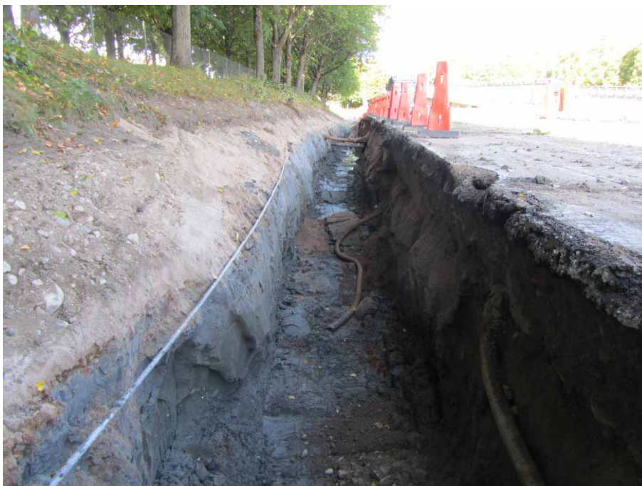
Figur 9. Schakt 2 vid Fältskärsleden, visar bärlager och gammal sjöbotten av blålera, taget från S. Foto: Anders Altner
