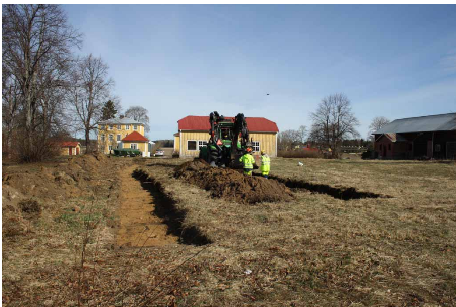
Figur 3. Upptagande av sökschakt. Foto: Maria Björck, taget från söder.
