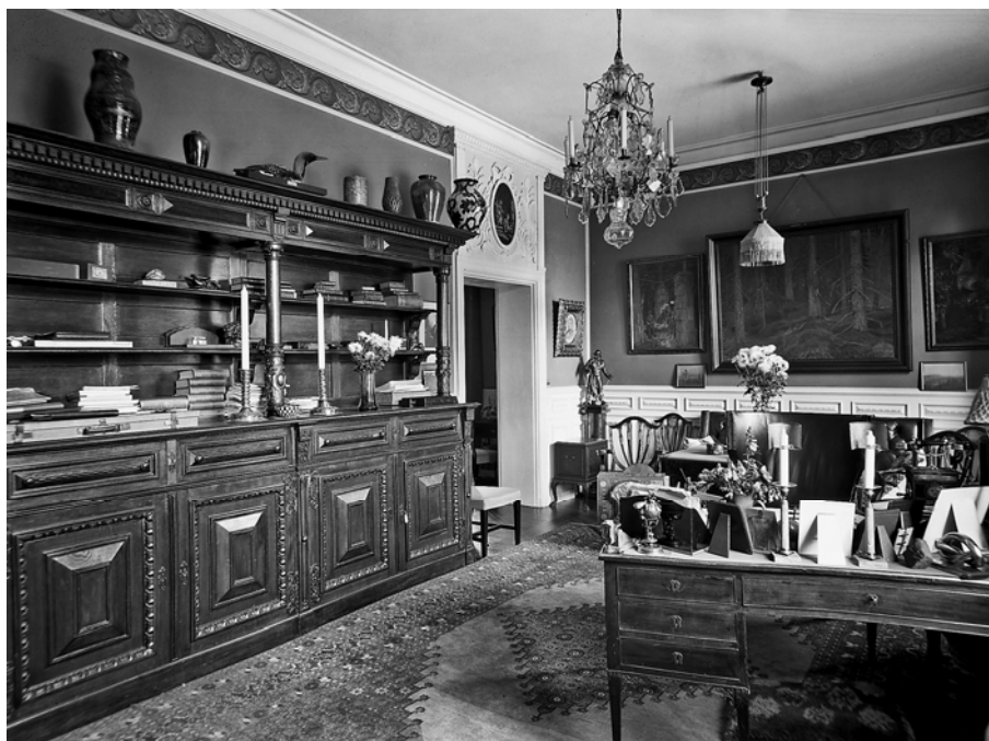
Bild 9. Per Erikssons arbetsrum år 1927. Foto: Hofors hembygdsförening.
