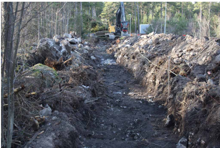
Figur 6. Grävning med maskin i schaktets nordvästra del. Foto: Bo Ulfhielm.
