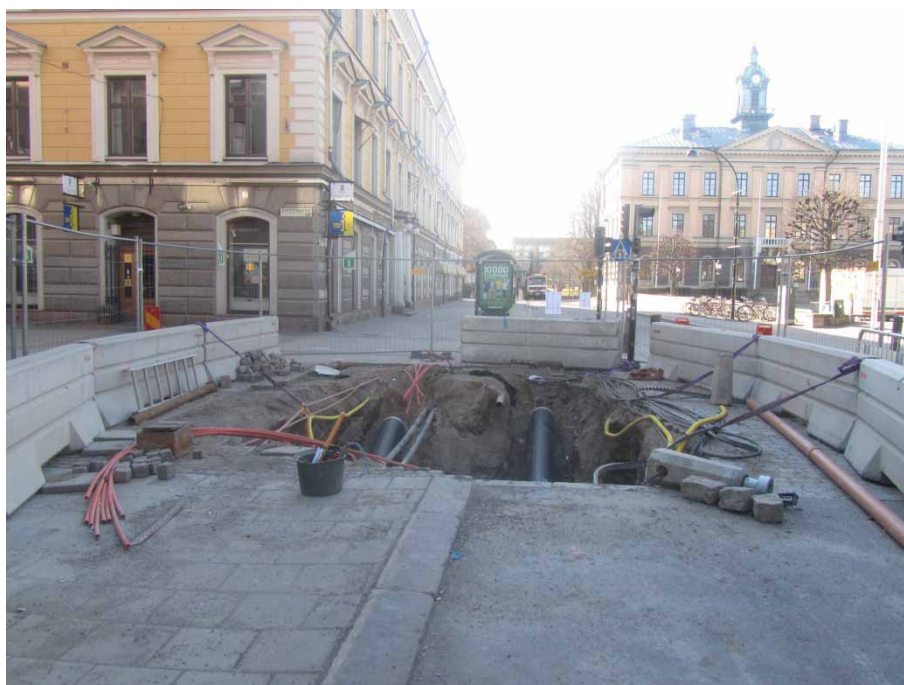
Schakt 1:5. Foto: Josefin Olsson.
