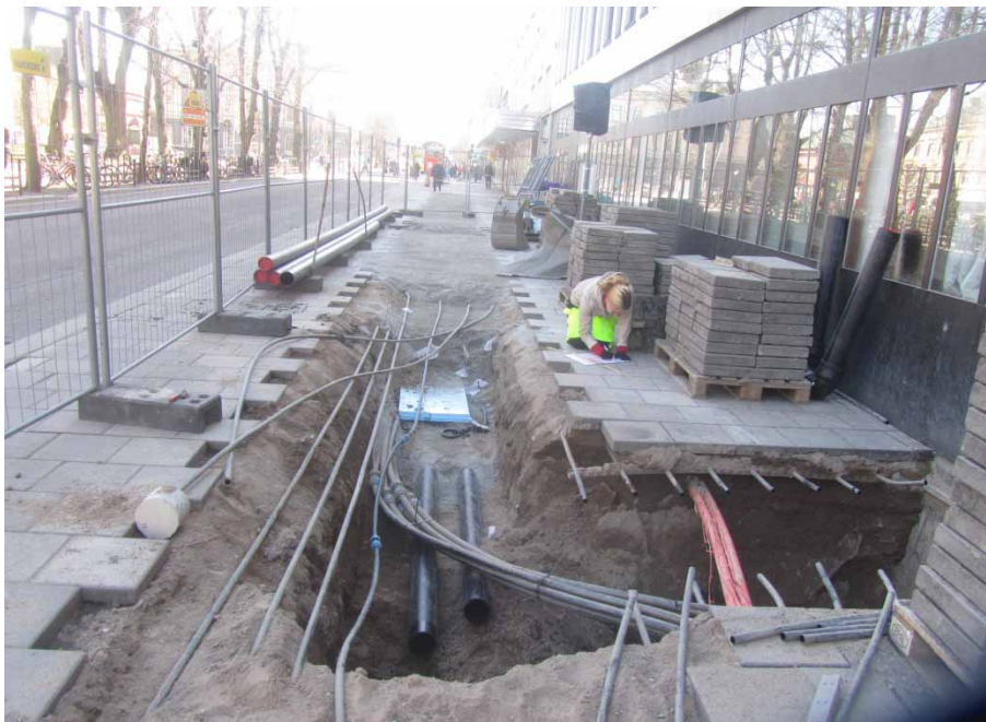
Schakt 1:4, längst norrut, under grävarbetet: Foto: Bo Ulfhielm.
