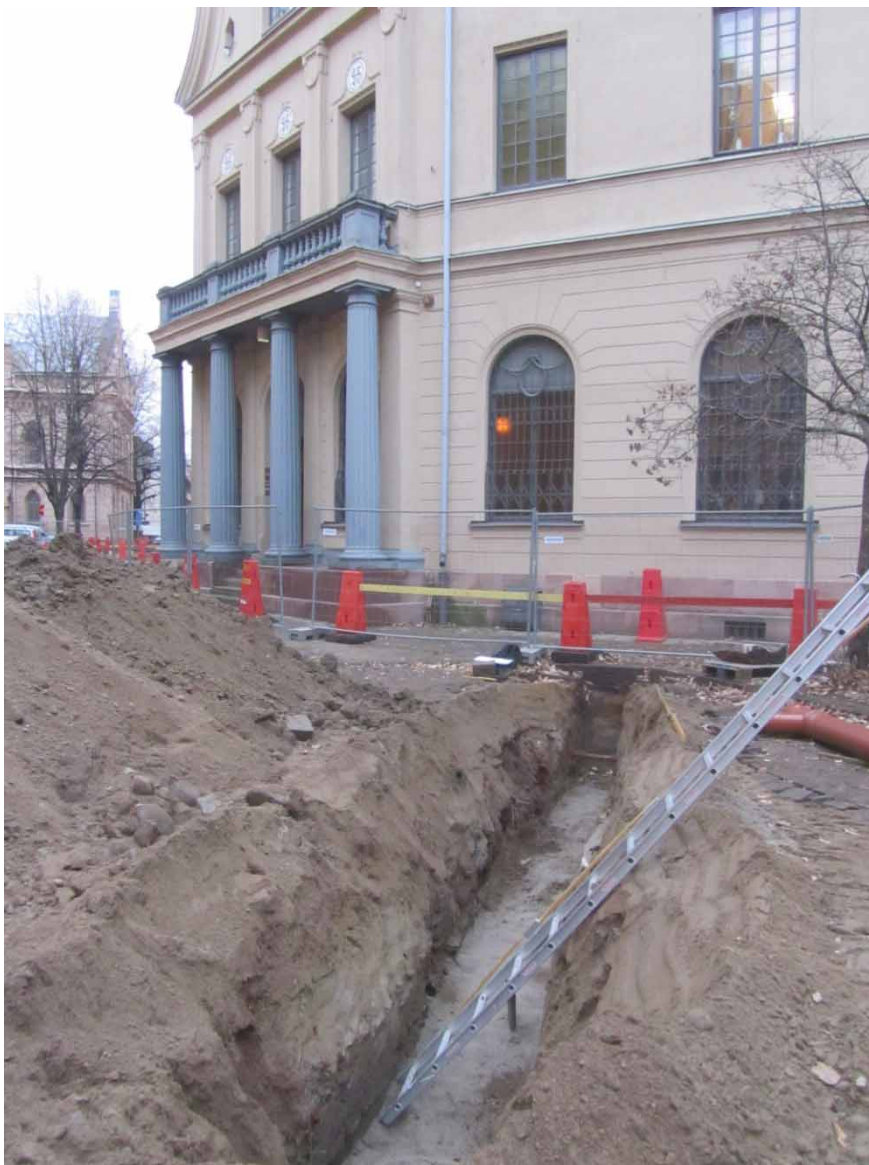
Bild 4. Schaktet mellan brunnen och Börshuset. Här ser man för övrigt järnkolonnerna vid börshusets ingång och delar av fasaden som är desamma som satt på den bankbyggnad som stod här före stadsbranden 1869 (Karlström 1974:126). Foto: Bo Ulfhielm.
