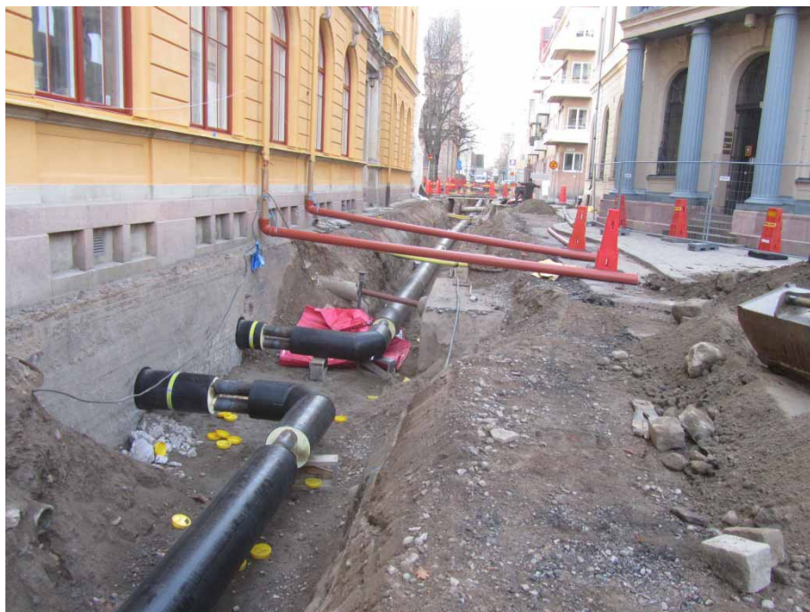
Bild 3. Längs Kyrkogatan går ledningschaktet nära Grand Hotell och kulturlagren har sannolikt förstörts av grundgrävning till byggnaden. Foto: Bo Ulfhielm.
