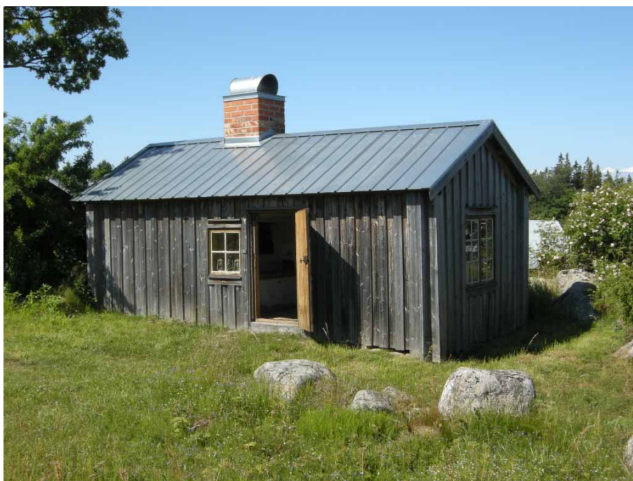
Bagarstugan. Foto: Daniel Olsson, Länsmuseet Gävleborg 2011.
