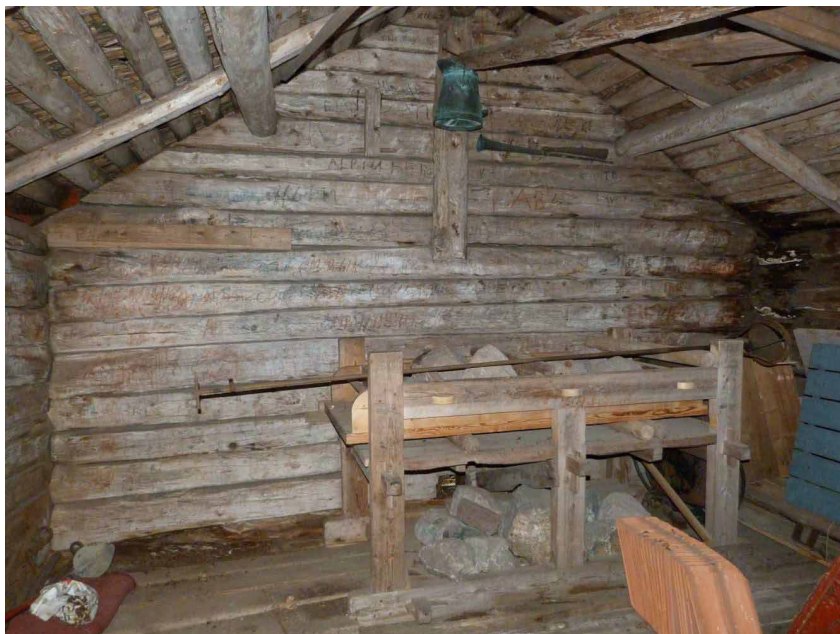
Stenmangeln mot den norra gaveln. Ovanför den hänger åttongen på den bjälke som man monterar upp varpan i. I det högra hörnet syns svampen i det fuktiga virket. Foto: Anna-Karin Martinsson, Hälsinglands museum 2012.
