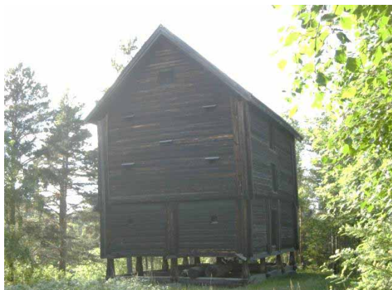
Ill. 8. Det fyra våningar höga sockenmagasinet i Järvsö.
