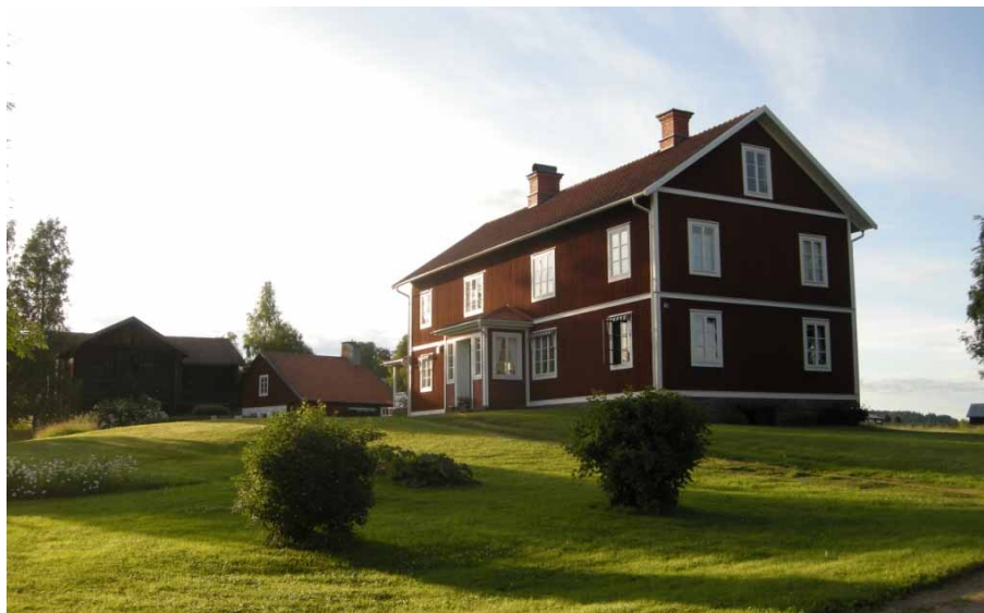
Ill. 68. Huvudbyggnaden vid Ers-Karlsas i Hamre, uppförd i slutet av 1910-talet (128).
