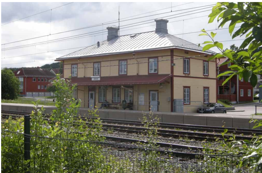
Ill. 77. Järvsö järnvägsstation (69).
