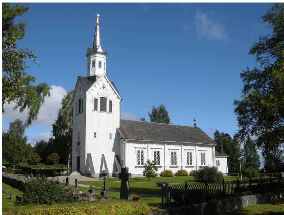
Figur 12. Los kyrka från sydväst efter avslutad tornrenovering. Foto: Daniel Olsson, Läns- museet Gävleborg 2013-08-22.
