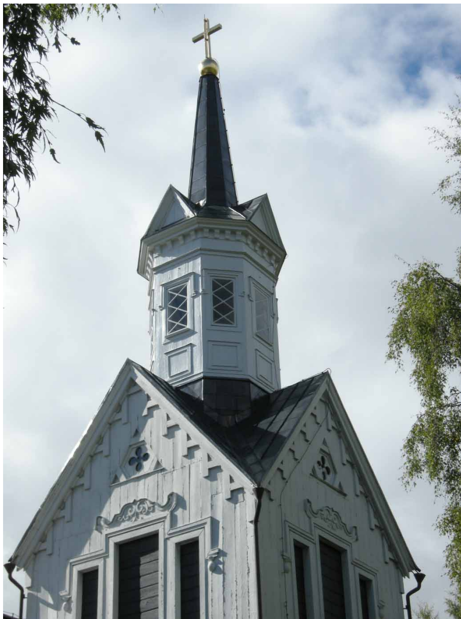
Figur 11. Detalj av kyrktornets övre del från nordost efter avslutad renovering. Foto: Daniel Olsson, Länsmuseet Gävleborg 2013-08-22.
