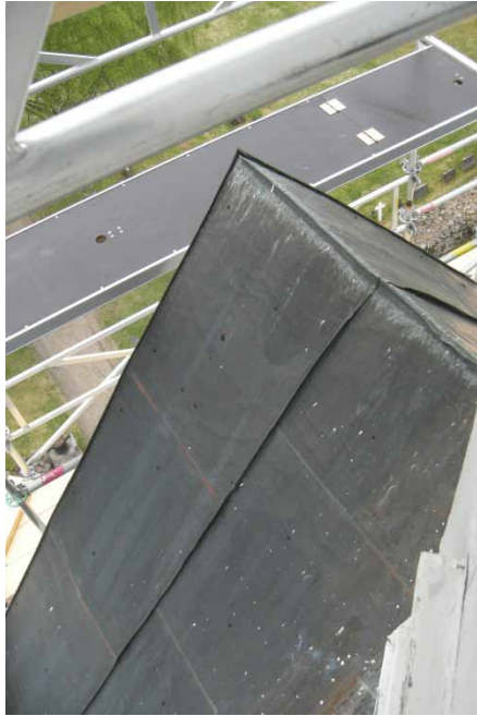
Figur 3. Detalj av plåttaket på tornhuven med stora skivformat. Foto: Daniel Olsson, Läns museet Gävleborg 2013-05-21.
