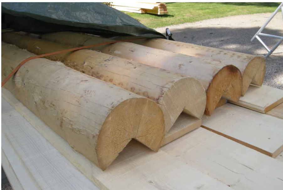
Figur 5. Detalj av nytillverkade åsar till tornhuvens hörn. En av dessa kom inte att användas då den ursprungliga åsen ej behövde bytas ut. Foto: Daniel Olsson, Länsmuseum Gävleborg 2013-05-30.
