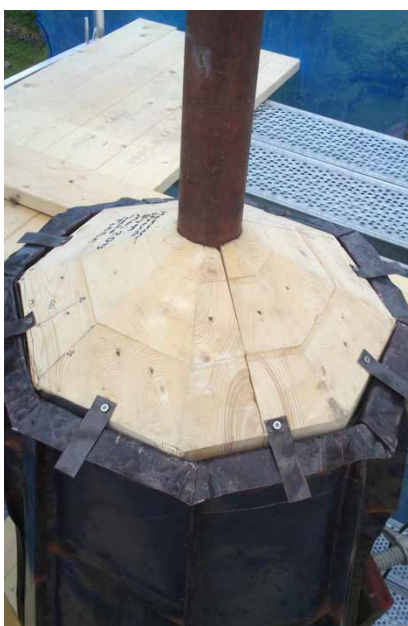
Figur 9. Detalj av spirans infästning. Foto: Torbjörn Cajonberg, Winther bygg.
