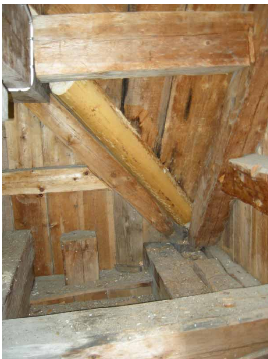
Figur 6. Detalj av utbytt takås som bär upp ett av torntakets fyra hörn. Foto: Daniel Olsson, Länsmuseum Gävleborg 2013-07-10.
