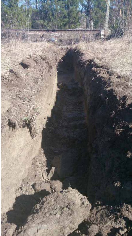
Figur 6. Schakt 2 fotograferat från väster. Foto: Inga Blennå.
