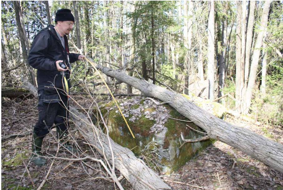
Figur 17. Bo Ulfhielm vid cementblocket ovanpå skyddsrum 17. Foto: Maria Björck.
