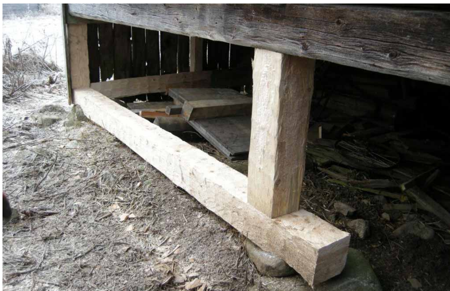
Figur 7. Detalj av utbyta syllstockar och stolpar under logens sydöstra del. Foto från nordöst, Daniel Olsson, Läns museet Gävleborg 2009-12-09.
