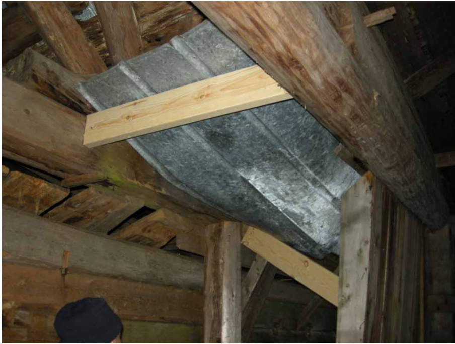
Figur 11. Detalj av det nya skyddstaket som är uppsatt mellan ladugården och logen. Foto från nordväst, Daniel Olsson, Läns museet Gävleborg 2009-12-09.
