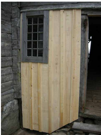
Figur 9. Detalj av lidrets norra vägg efter renovering. Foto från norr, Daniel Olsson, Länsmuseet Gävleborg 2009-12-09.
