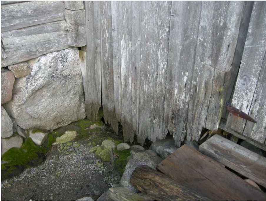
Figur 4. Detalj av hörnet mellan bryggstugans västra fasad och lidrets norra fasad med rötskadad panel där det brukar samlas vatten. Foto från nordväst, Daniel Olsson, Läns-museet Gävleborg 2009-09-13.
