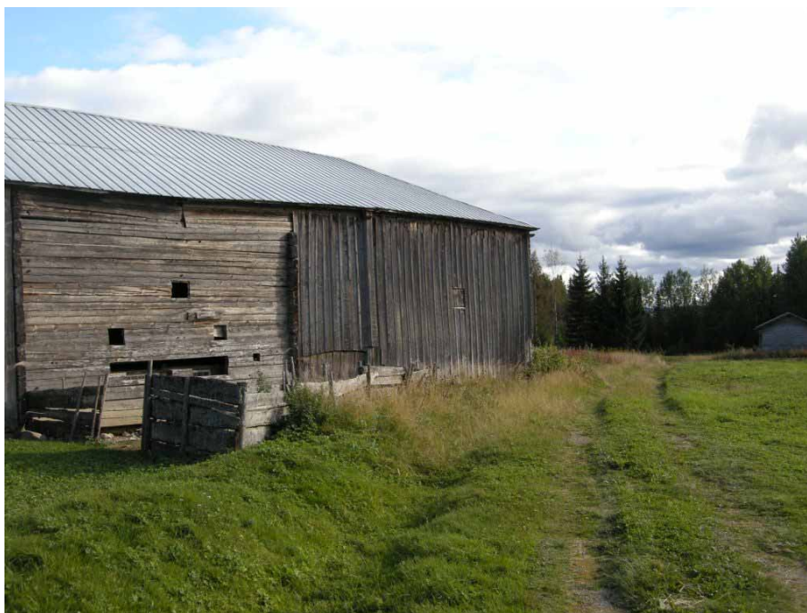
Figur 6. Ladugårdskomplexets västra fasad med diket längs körvägen mot Ny-Ersk-Mats före grävarbeten. Foto från nordväst, Daniel Olsson, Läns museet Gävleborg 2009-09-13.
