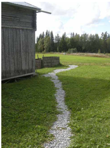
Figur 10. Det stensatta diket norr om ladugårdskomplexet. Daniel Olsson, Länsmuseet Gävleborg 2011-08-31.
