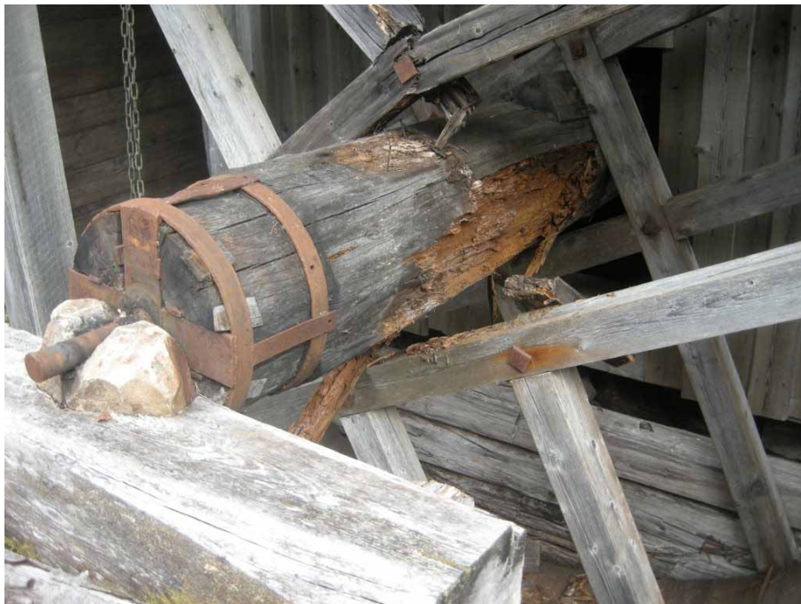
Figur 7. Detalj av den horisontella axeln och vattenhjulet med omfattande skador innan renoveringen inleddes. Foto: Daniel Olsson, Läns museet Gävleborg 2011-08-31.
