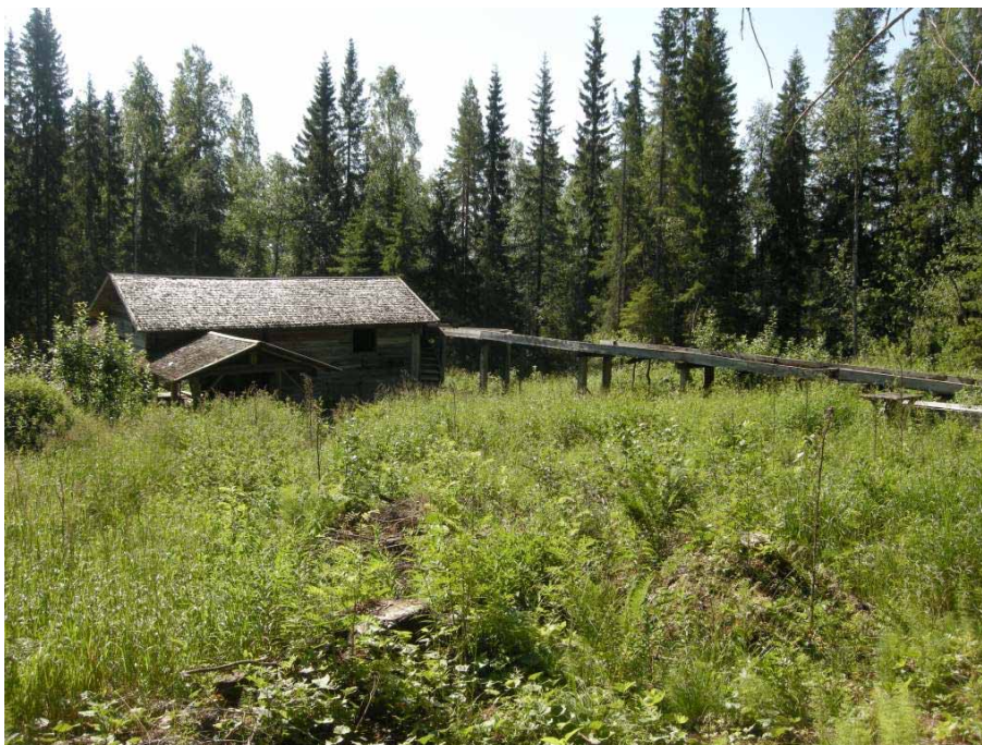
Figur 2. Vattenverket före renoveringen. Foto från norr, Daniel Olsson, Läns museet Gävleborg 2011-06-30.
