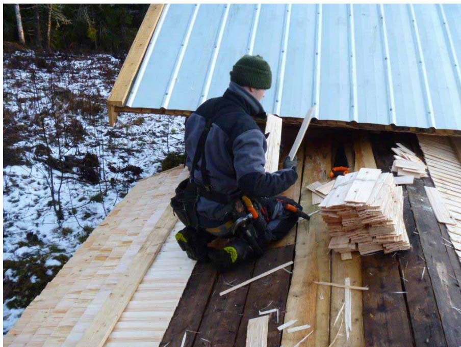
Figur 11. Timmerblock under arbetet med spåntaket på taket ovanför spånhyveln. Foto från nordväst, Magnus Wallin, hösten 2011.
