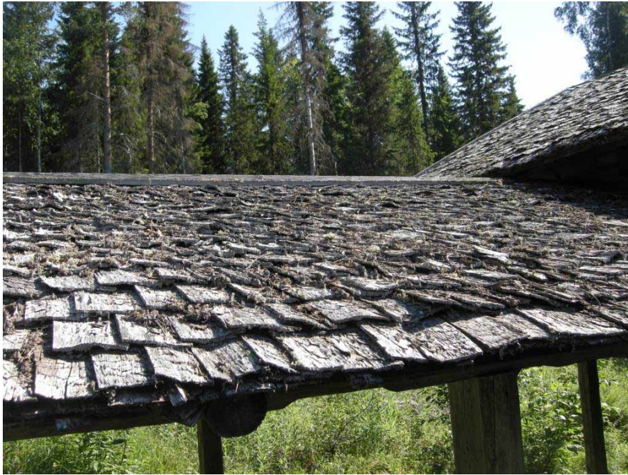
Figur 8. Detalj av spåntaket vid spånhyveln före renoveringen. Foto från sydväst, Daniel Olsson Läns museet Gävleborg 2011-06-30.
