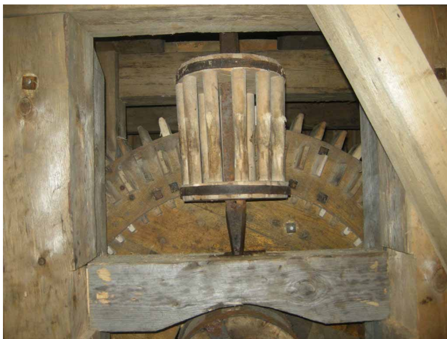
Figur 3. Detalj av kraftöverföringen vid kronhjulet mitt i byggnaden. Foto: Daniel Olsson, Länsmuseet Gävleborg 2011-08-31.
