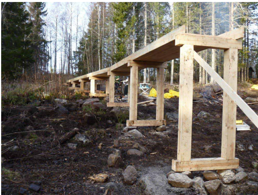
Figur 12. Timmerrännan under återuppbyggnaden. Foto från söder, Magnus Wallin, hösten 2011.
