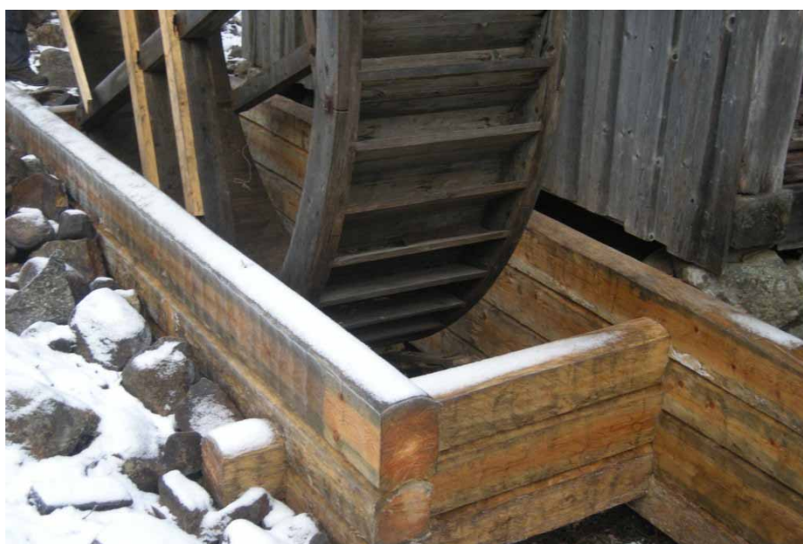
Figur 9. Den timrade konstruktionen vid hjulgraven efter byte av timmer. Foto från söder, Daniel Olsson, Länsmuseum Gävleborg 2011-11-22.
