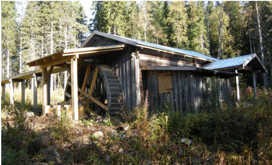
Figur 14. Vattenverket från söder efter avslutad renovering. På bilden ses bland annat den södra delen av den nya vattenrännan, det nya förstorade taket över vattenhjulet och den nya luckan in till linskäkten. Foto från söder, Daniel Olsson, Läns museet Gävleborg 2012-09-21.
