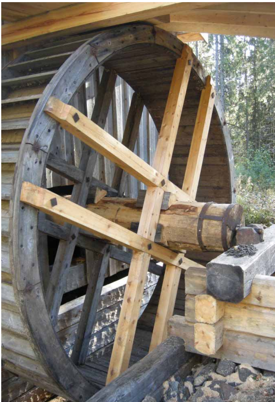
Figur 10. Vattenhjulet efter byte av ekrar på den södra sidan och axel. Till vänster ses en del av den timrade upplagskonstruktionen. Foto från väster, Daniel Olsson, Läns museet Gävleborg 2012-09-21.
