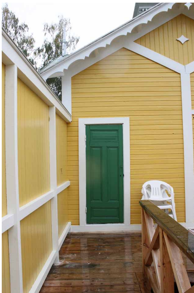
Figur 16. Inne bakom planket vid badplatsen. Ett nytt plank av hyvlad fasspontpanel med avdelande listverk, har tillverkats inom projektet. Foto: 2015-09-24.
