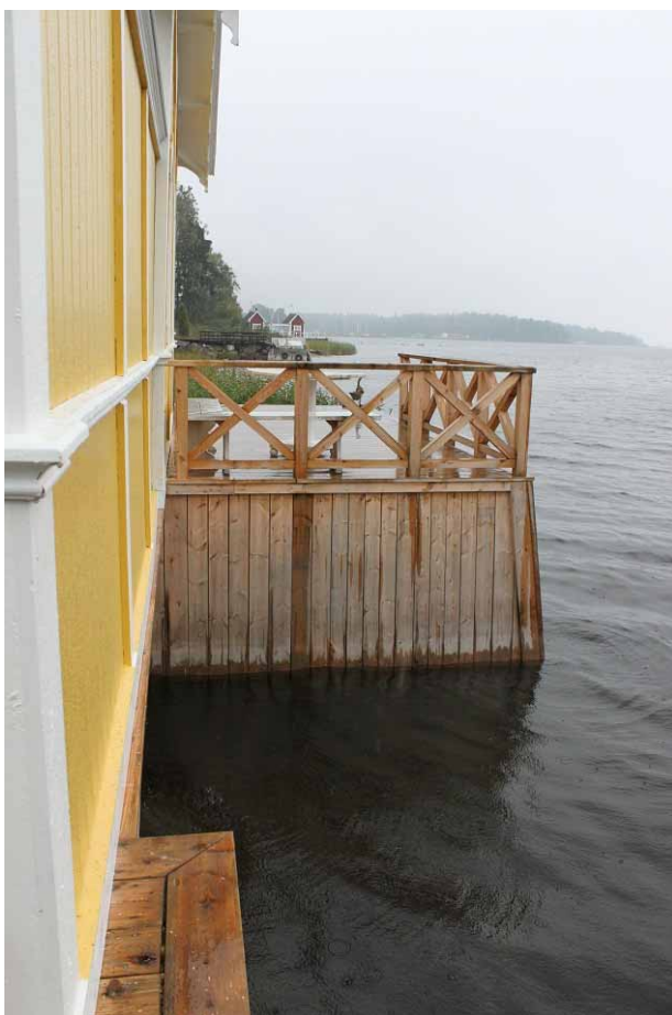
Figur 14. Räcke vid badhusets östra sida. Foto: 2015-09-24.
