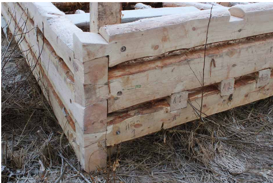
Figur 9. Närbild på den nytimrade stenkistan. Foto: 2014-12-03.
