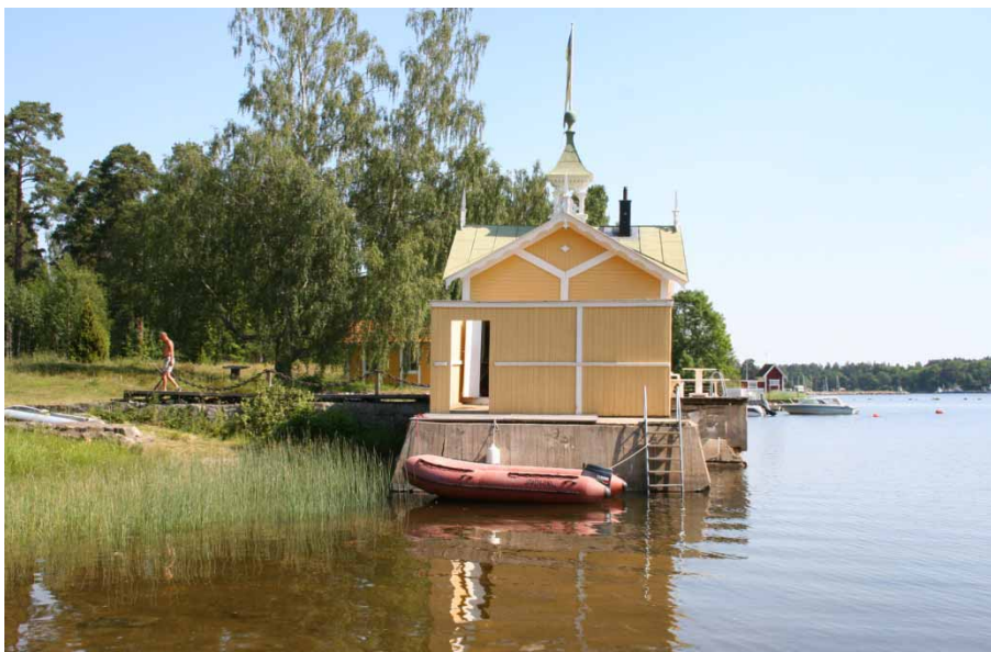
Figur 4. Badhuset från söder, 2006-08-01. Här syns den gjutna betongen på den södra stenkistan. Foto: Johannes Kruusi, Länsmuseet Gävleborg.
