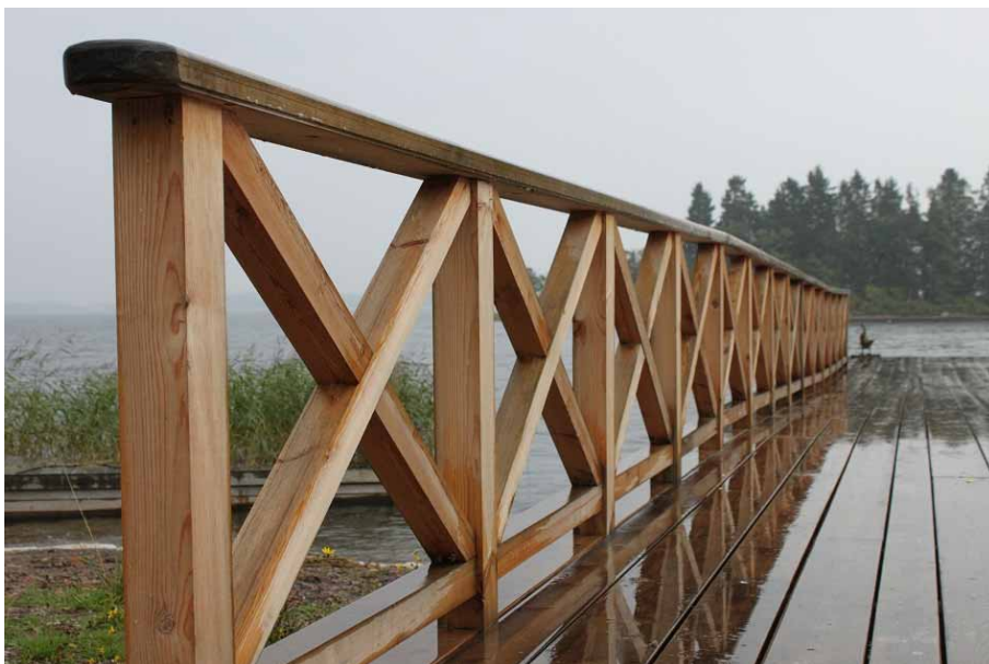
Figur 13. Nytt krysställt räcke i otryckt furu utesfter trädäckets norra sida. Foto: 2015-09-24.
