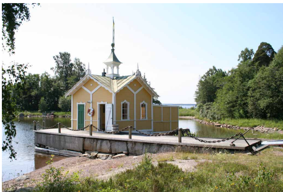
Figur 3. Badhuset från norr, 2006-08-01. Här syns den gjutna betongen på stenkistorna samt ett sentida räcke. Foto: Johannes Kruusi, Läns museet Gävleborg.
