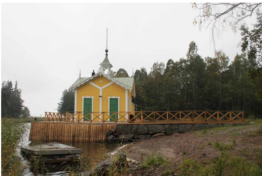
Figur 10. Slutbesiktning 2015-09-24. Badhuset sett från norr. Det nya krysställda räcket sträcker sig efter nästan hela den norra sidan.
