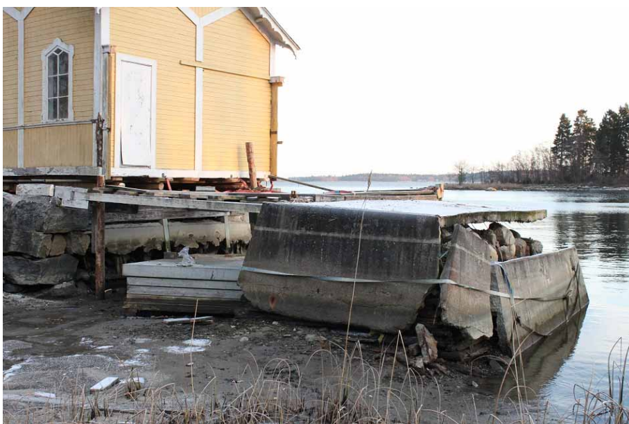
Figur 6. Den södra stenkistan innan påbörjade arbeten. Foto: 2014-12-03.
