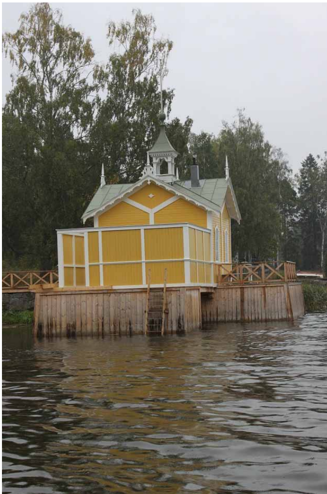
Figur 12. Badhuset sett från söder, 2015-09-24.
