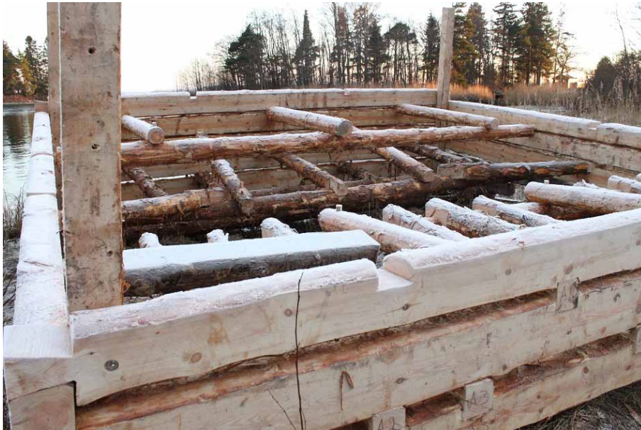
Figur 8. Närbild på den nytimrade stenkistan. Här syns kistans konstruktion med stenslag på insidan. Foto: 2014-12-03.
