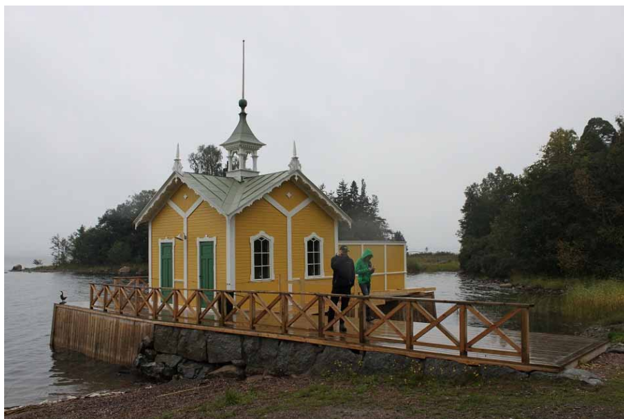
Figur 2. Badhuset i Sjövik vid slutbesiktning, 2015-09-24.
