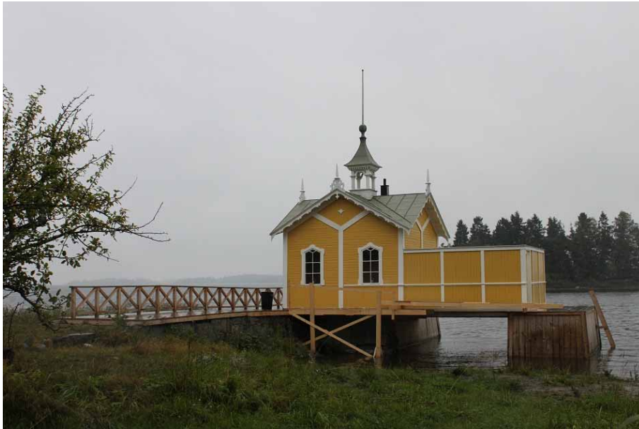
Figur 11. Slutbesiktning 2015-09-24. Badhuset sett från väster. Badhuset vilar på den norra stenkistan, medan badplatsens plank mot söder vilar på den södra stenkistan. I förgrunden syns del av byggnadsställning som vid besöket ännu inte var demonterad.
