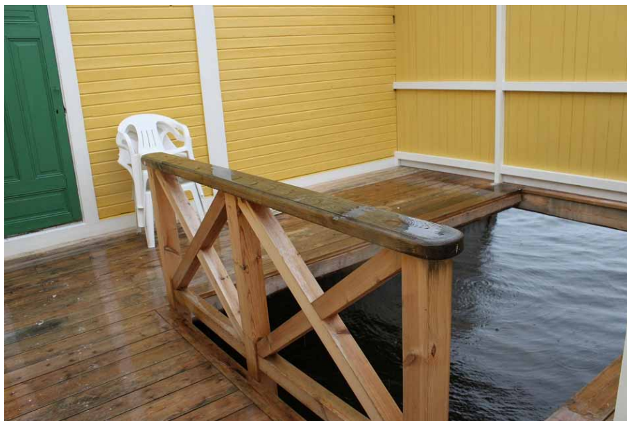
Figur 15. Inne bakom planket vid badplatsen. Ett skyddande räcke, likt tidigare, är monterat vid öppningen. Foto: 2015-09-24.
