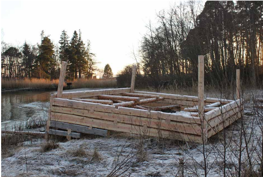
Figur 7. Den nya stenkistan som Sjöblom tillverkat ska på plats på den norra sidan, under badhuset. Foto: 2014-12-03.
