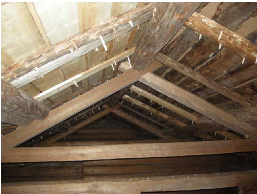
Figur 9. Takkonstruktionen i stallet sedd från vindsvåningen. På bilden ses bland annat sammanfogningen mellan rafter och trobrädor med tränaror. Foto från söder, Daniel Olsson, Läns museet Gävleborg 2014-10-08.
