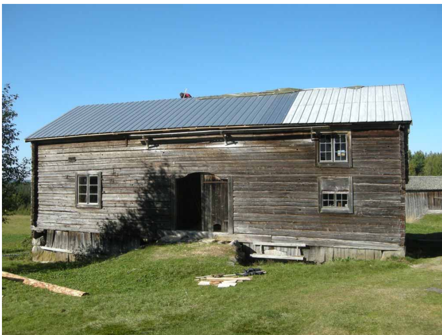
Figur 13. Stallet från nordöst med det bevarade takpartiet i det östra takfallets norra del med äldre pannplåt i mer matt kulör. Vid taknocken skymtar en av Timmerblocks medarbetare som arbetar med det västra takfallet. Foto från nordöst, Daniel Olsson Läns museet Gävleborg 2014-09-05.
