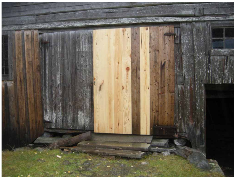
Figur 10. Ladugårdskomplexets norra port efter renovering. Foto från nordväst, Daniel Olsson, Läns museet Gävleborg 2014-10-08.
