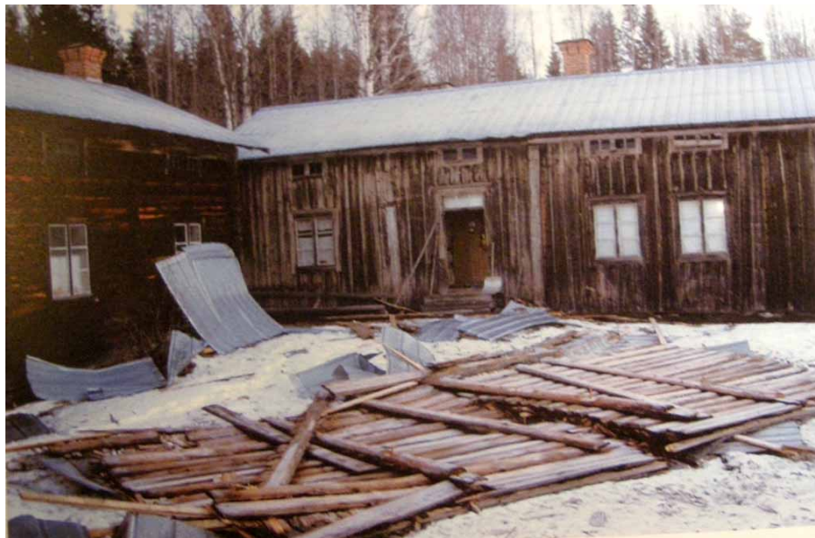
Figur 4. Gårdsplanen vid Ersk-Mats med stora delar av stallens tak utspritt efter stormen Ivars framfart. Foto från sydväst: Boerje Bohlin, december 2013.
