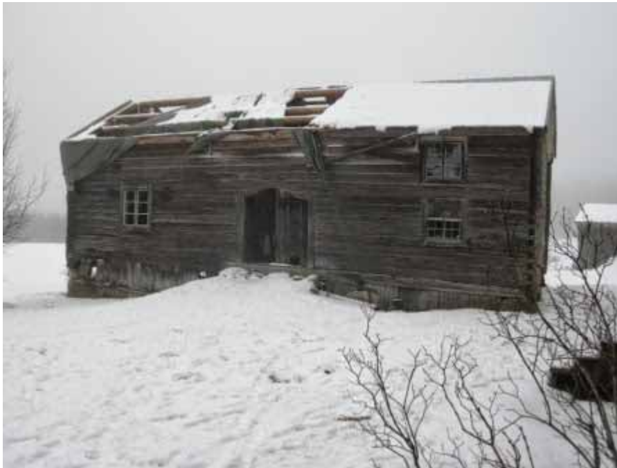
Figur 12. Stallet innan renoveringen inleddes. Jämför med figur 13 här nedan. Foto från nordöst, Daniel Olsson, Läns museet Gävleborg 2014-04-08.
