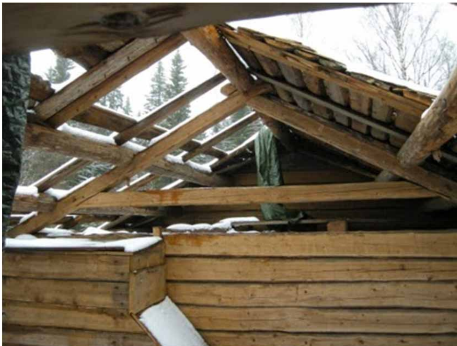
Figur 8. Takkonstruktionen i stallet sedd från vindsvåningen vid genomgången inför renoveringen och innan det provisoriska taket kom på plats under våren 2014. Jämför med nedanstående bild. Foto från sydöst, Daniel Olsson, Läns museet Gävleborg 2014-04-08.
