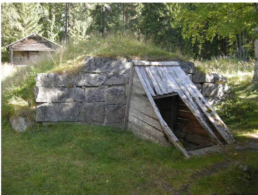
Figur 6. Jordkällarens svale före renoveringen. Dörren är här borttagen. Foto från sydväst, Daniel Olsson, Länsmuseum Gävleborg 2014-09-05.
